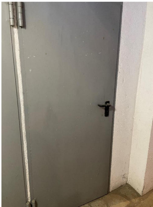
RIPRESA FOTOGRAFICA EFFETTUATA DAL C.T.U. – PIANO SOTTERRANEO – ACCESSO CANTINA – SUB.2
