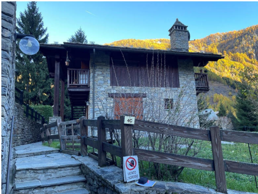
RIPRESA FOTOGRAFICA EFFETTUATA DAL C.T.U. – VISTA ESTERNA CONDOMINIO - FRONTE OVEST
