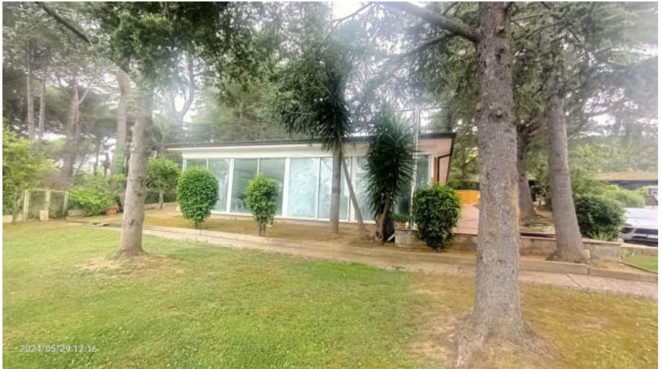
Comune di Sant'Elpidio a Mare, Foglio 33 Particella 182 sub 7 accessorio piscina
