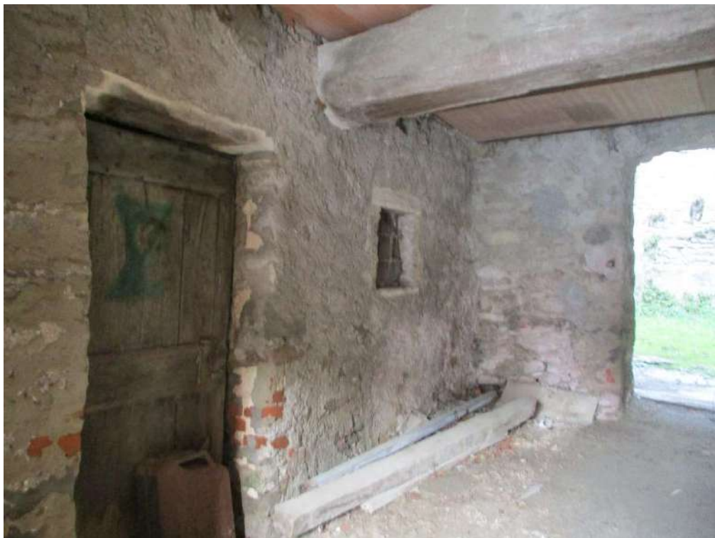
Porta cantina con accesso da sottopasso (altra proprietà)
