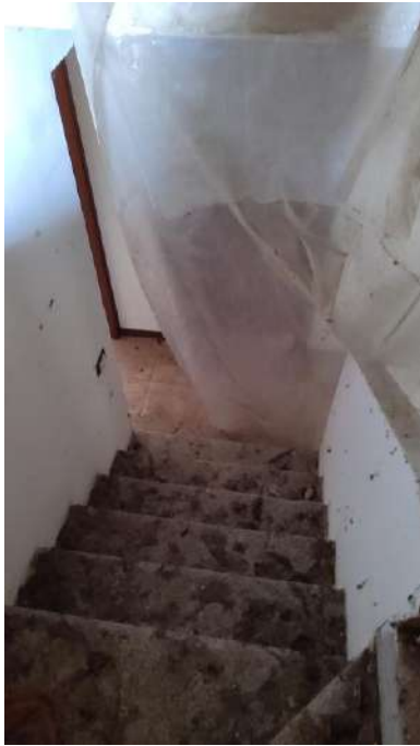
FOTO 16: vista vano scala
