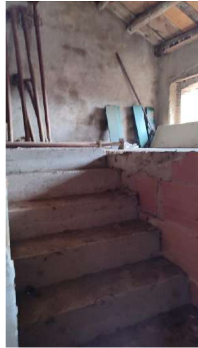
FOTO 17: vista vano scala
