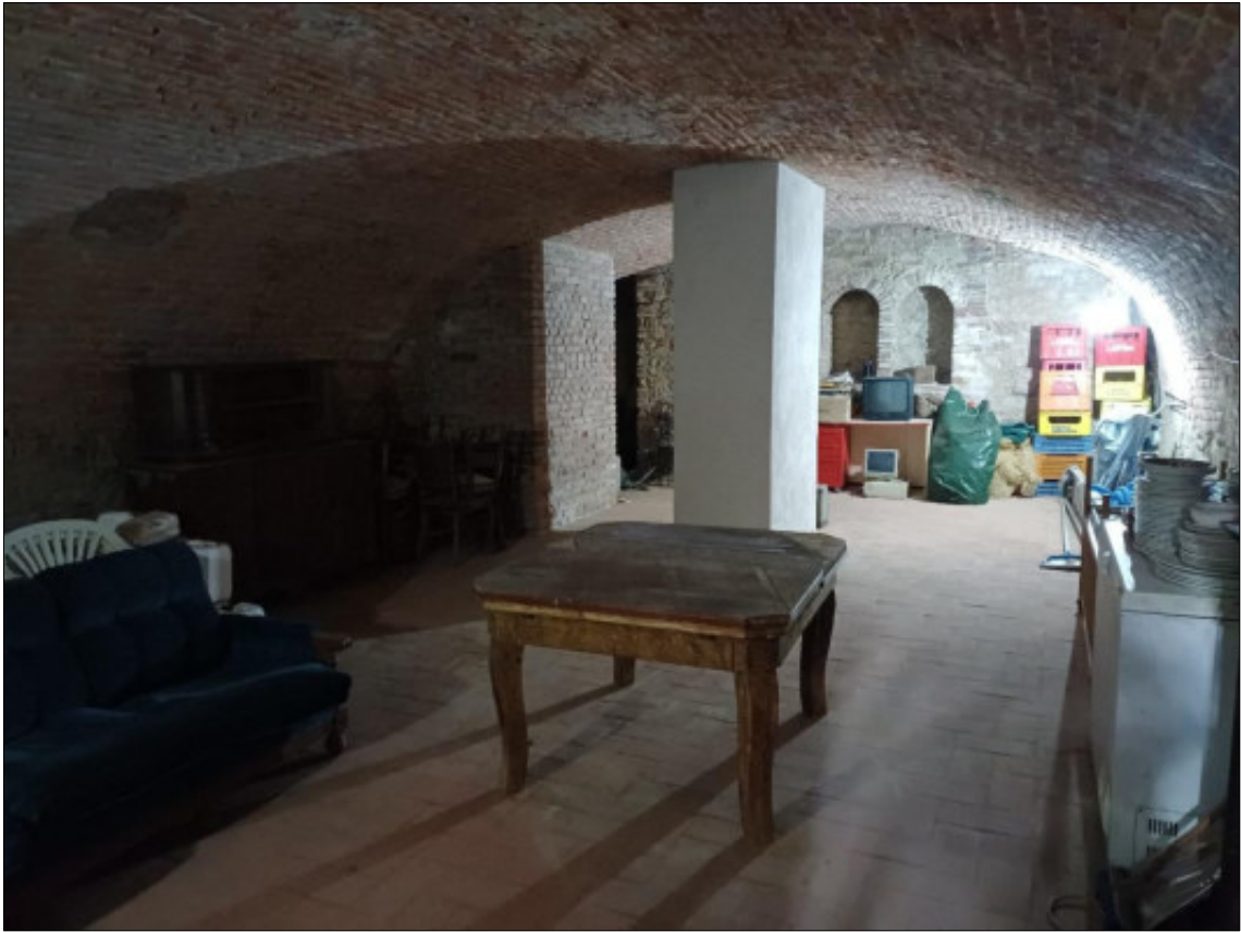
Foto 9 – cantina piano interrato
