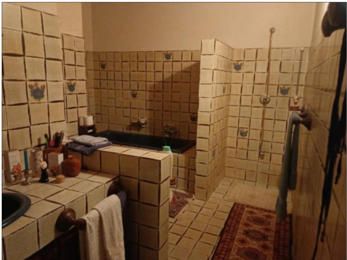
Foto 18 – bagno interno alla camera piano terra
