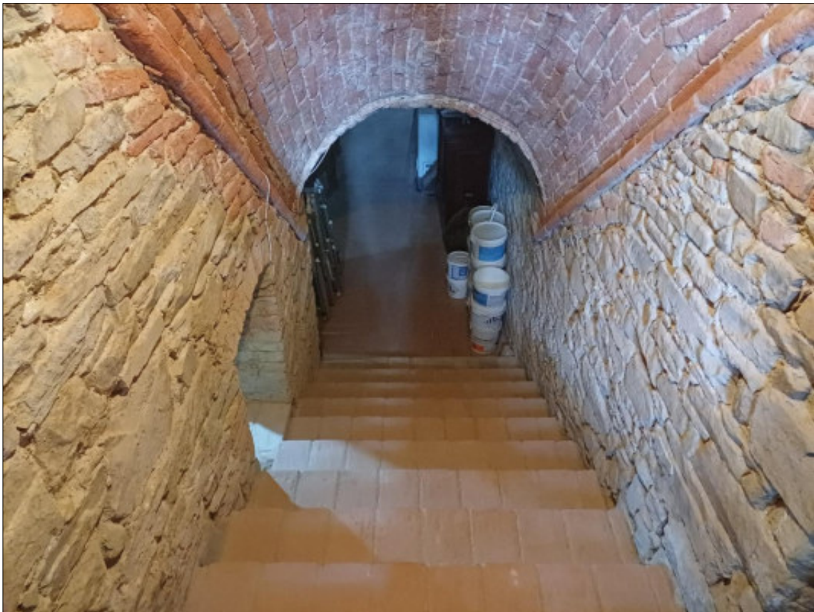
Foto 11 – scala di collegamento piano terra-piano interrato
