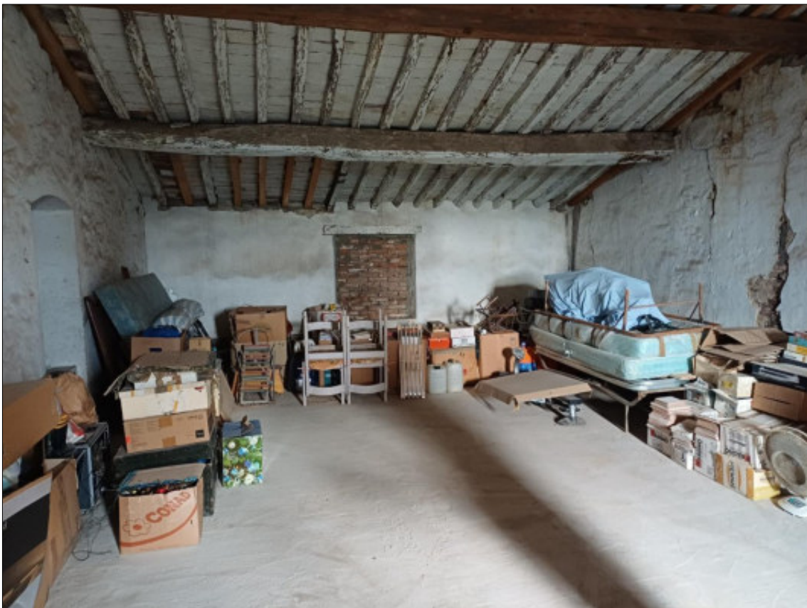
Foto 24 – piano secondo sottotetto (soffitta)
