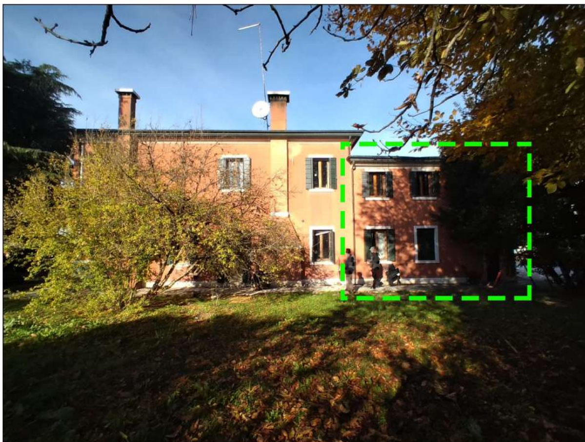
foto 08 - area esterna e fronte est
