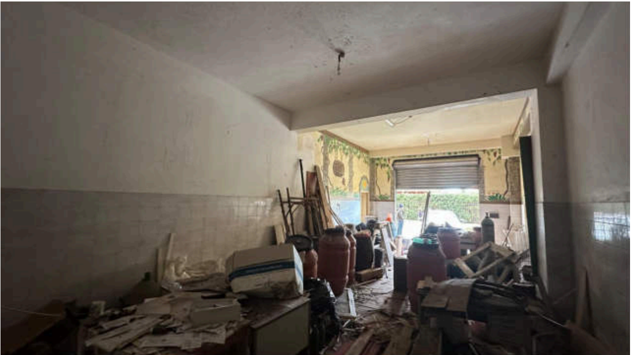
4. Vista 4 su Deposito
