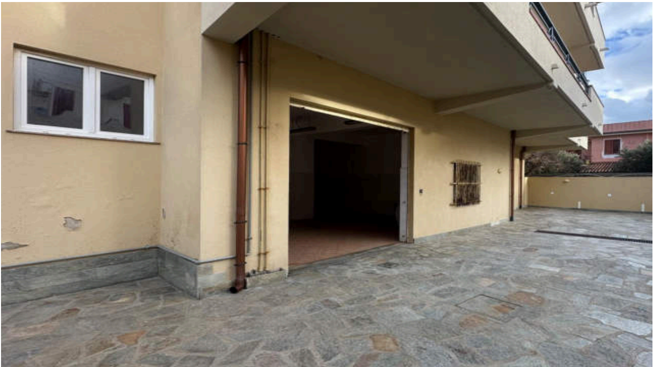
2. Vista su Ingresso Garage
