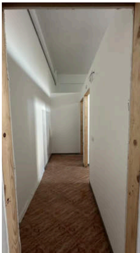
13. Vista 1 su Disimpegno
