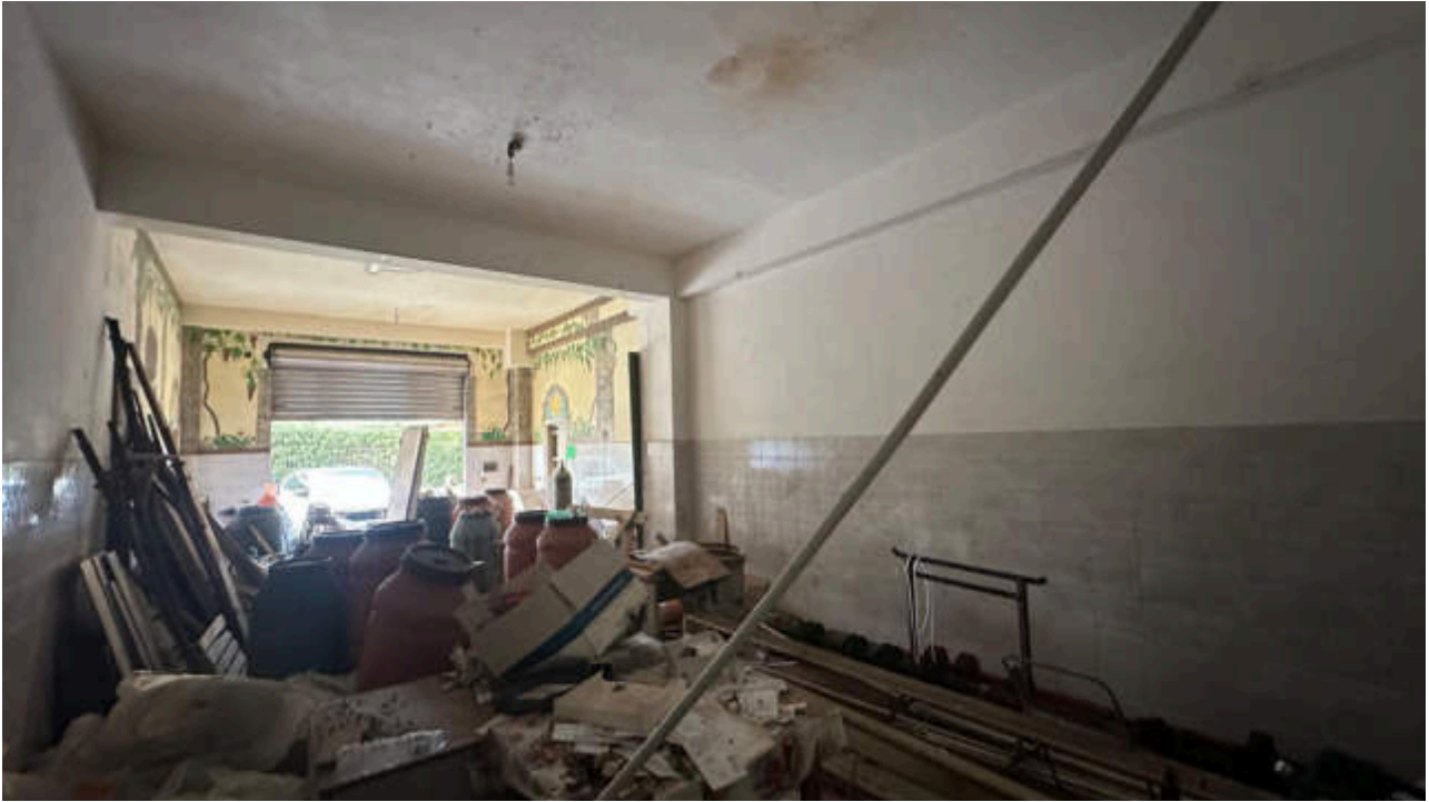
3. Vista 3 su Deposito
