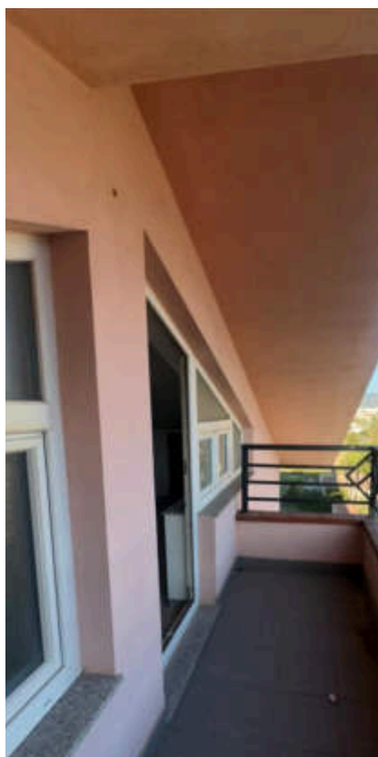
16. Vista 2 su Balcone accessibile dal Locale 8
