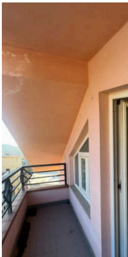
15. Vista 1 su Balcone accessibile dal Locale 8
