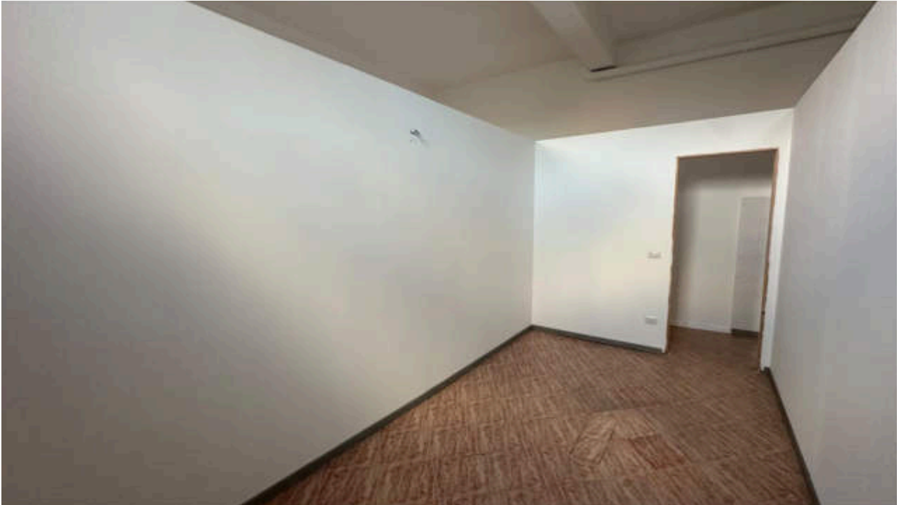
11. Vista 1 su Spogliatoio
