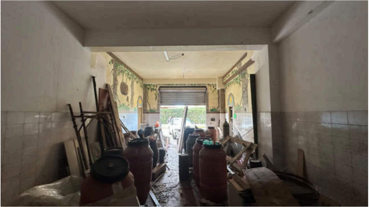
5. Vista 5 su Deposito
