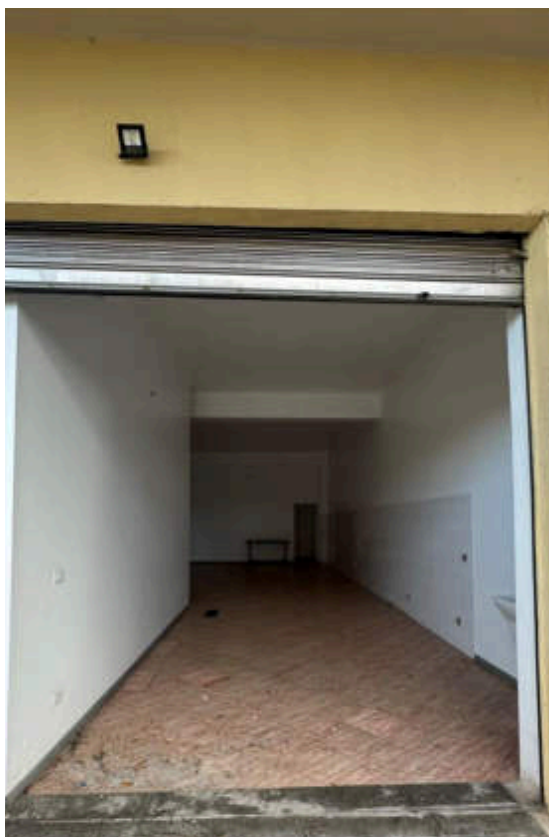
3. Vista 1 su Ingresso Deposito
