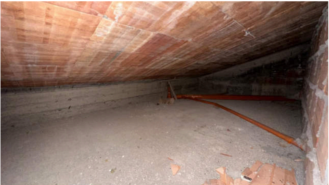
14. Vista su Locale di Sgombero
