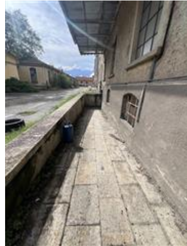
vista della rampa di accesso al piano cantine
