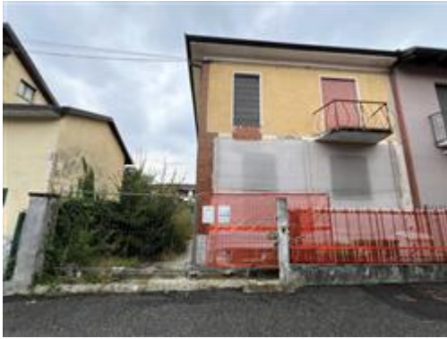
vista della facciata verso via della Croce
