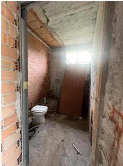
vista del piccolo locale ricavato in corrispondenza del pianerottolo del vano scala (ora demolito) di collegamento con il piano primo
