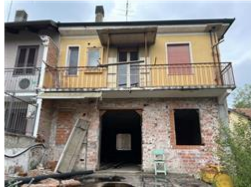
vista della facciata verso il cortile interno
