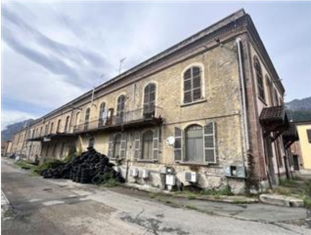
vista della facciata sud dalla quale si accede al piano interrato
