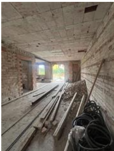
vista del locale unico con ingresso dal terrazzo lato cortile interno
