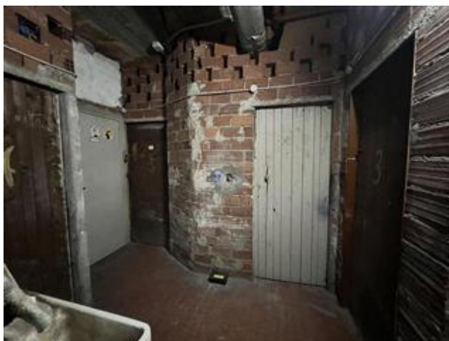
vista esterna della cantina
