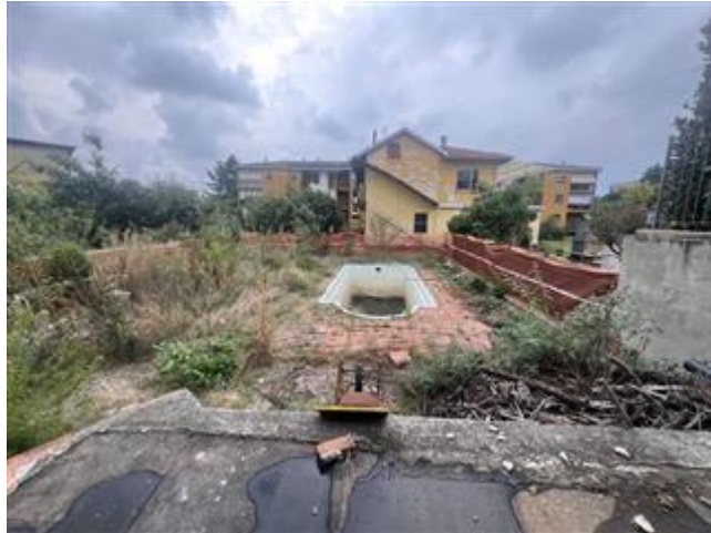
vista del cortile interno di pertinenza esclusiva
