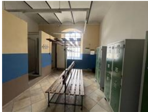
vista del locale spogliatoio dotato di docce e un servizio igienico
