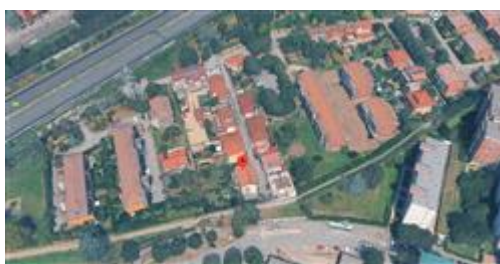
estratto da Google Earth 3D: vista dell'area in cui è situato il fabbricato di interesse
