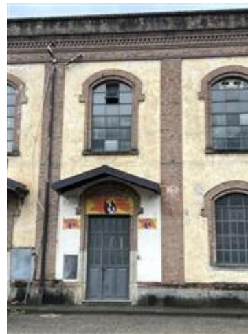
particolare della porta di ingresso all'immobile
