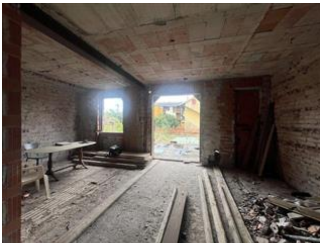
altra vista del locale unico con ingresso dal terrazzo lato cortile interno
