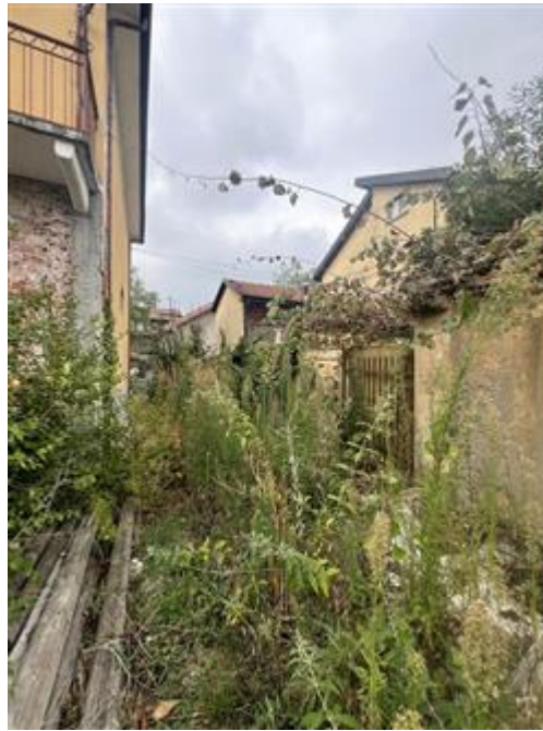
vista del passaggio comune che dall'ingresso della via della Croce conduce al cortile interno
