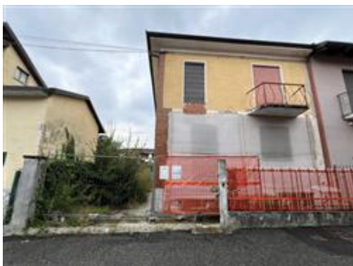
vista della facciata verso via della Croce
