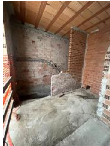
vista del vano scala che conduce al piano interrato
