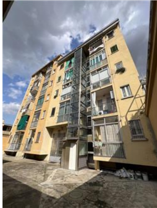
vista del prospetto verso il cortile comune
