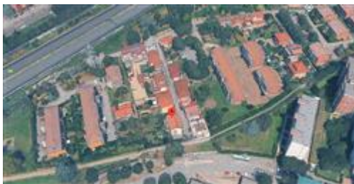
estratto da Google Earth 3D: vista dell'area in cui è situato il fabbricato di interesse
