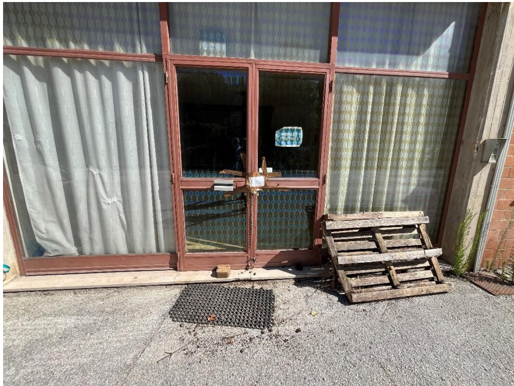
Foto 31 – ingresso alla area uffici F2, dalla zona Sud del piazzale F5
