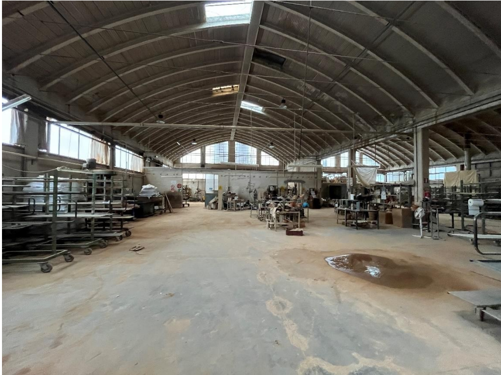
Foto 16 – opificio F1, navata Ovest, da Sud verso Nord dove è ubicata l'area lavorazione terre – copertura in travi di cemento arcuate tipo Sicap, tavelloni in c.a. e tiranti in acciaio – pavimentazione in cemento industriale.
