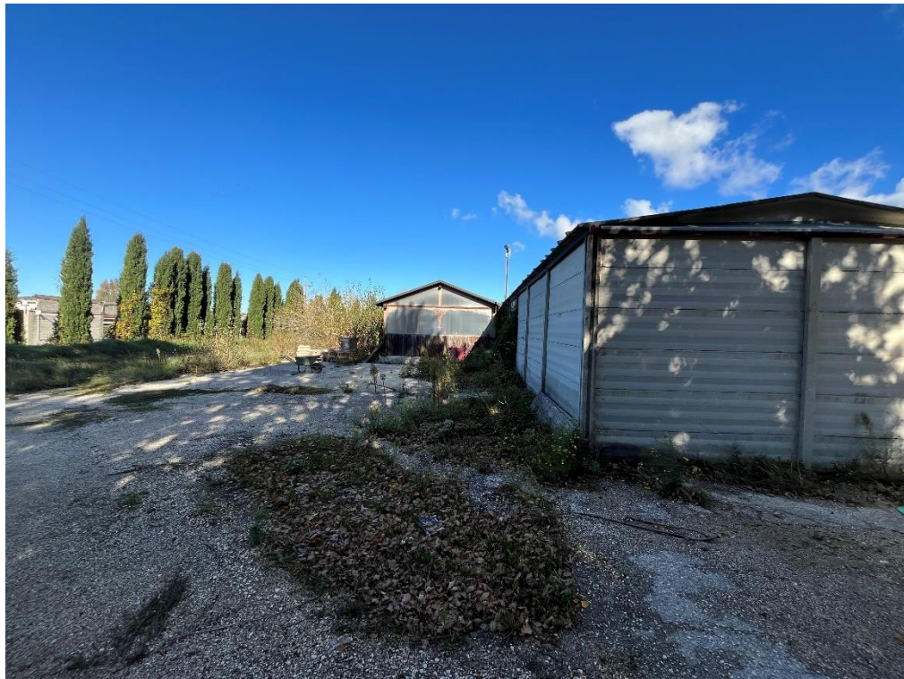
Foto 5 – a sinistra confine verso Ovest della proprietà, al centro il fabbricato LL (prefabbricato in legno, privo di infissi, non autorizzato, non accatastato, di non conveniente recupero), a destra il lato Sud del magazzino F4. Attorno piazzale (corte comune) F5.
