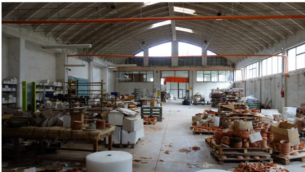
Foto 49 – F1, navata Est, zona confezionamento ingombra di materiali abbandonati.
