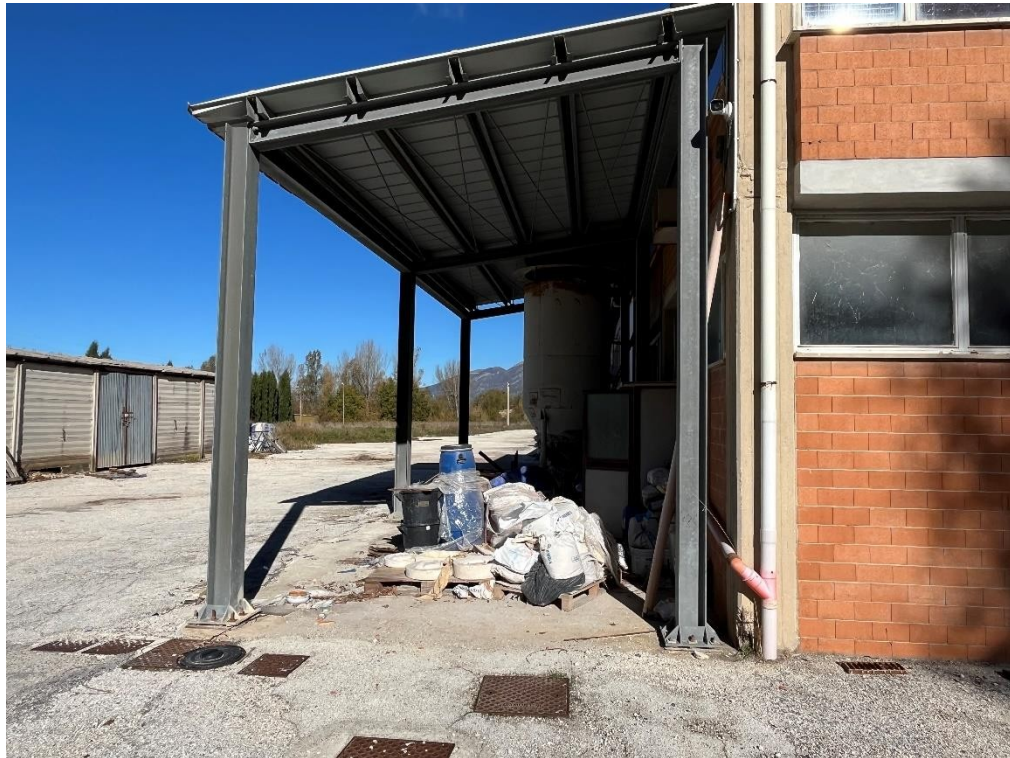
Foto 3 – a sinistra il fabbricato F4, al centro in primo piano la tettoia TD, a destra il fabbricato principale F1 e F2.
