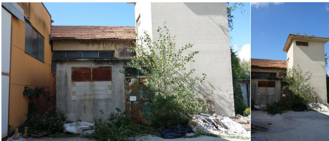
Foto 11 – edificio F3 con altezze a due livelli: nella porzione di sinistra è ubicato il gruppo compressore Irmap, nella porzione di destra è ubicata la cabina elettrica di trasformazione.
