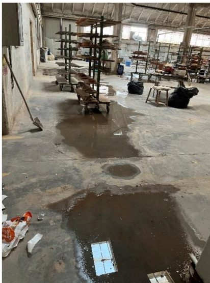
Foto 23, 24, 25, 26, 27, 28 – opificio F1, infiltrazioni di acqua piovana dalla copertura.
