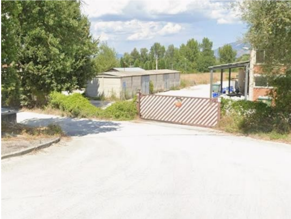
Foto 1 – da Via degli Artigiani verso ingresso carrabile, da Sud Est verso Nord Ovest. Dal cancello si accede al piazzale F5: a sinistra fabbricato F4, a destra tettoia TD e fabbricato principale F1, F2.
