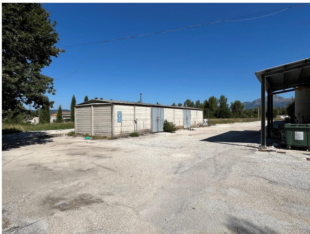
Foto 4 – a sinistra il fabbricato F4, al centro il piazzale F5 comune a tutti i fabbricati, a destra la tettoia TD.
