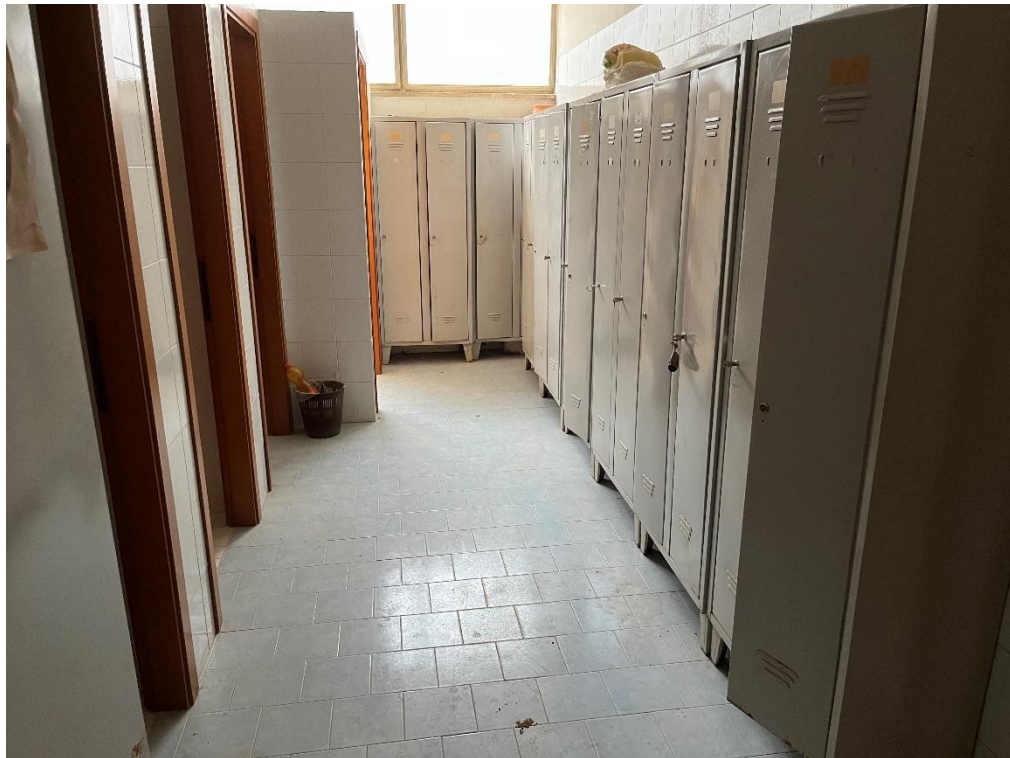
Foto 29 – opificio F1, locale bagni spogliatoi.
