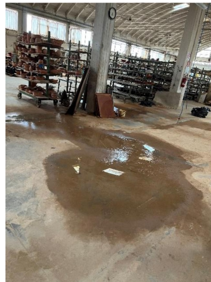
Foto 23, 24, 25, 26, 27, 28 – opificio F1, infiltrazioni di acqua piovana dalla copertura.
