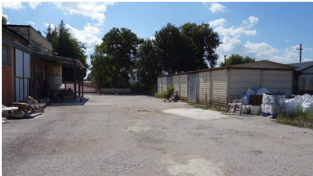
Foto 6 – al centro piazzale (corte comune) da Nord verso Sud, verso il cancello di ingresso/uscita, a sinistra tettoia TD e opificio F1, a destra il magazzino F4, lungo il cui lato Nord, risultano depositati a terra sacchi e contenitori vari contenenti residui di smalti ceramici, privi di copertura né protezione
