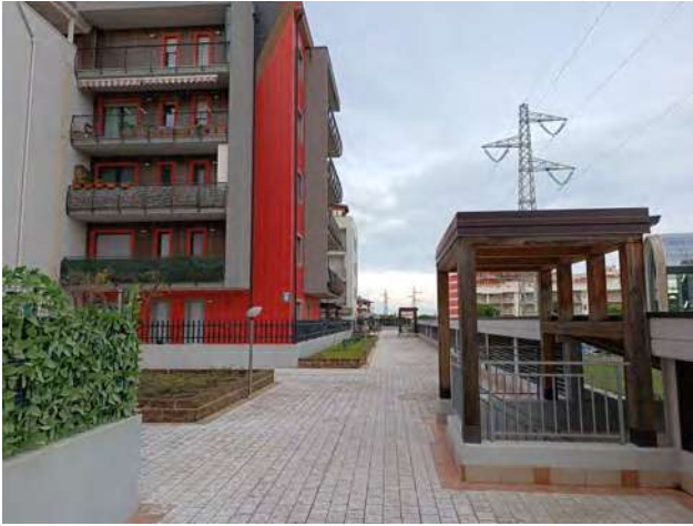
FOTO NN.07-08 Accesso pedonale al piano interrato dei box
