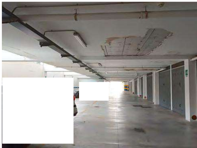
FOTO N.09 Corsia di manovra dei box
