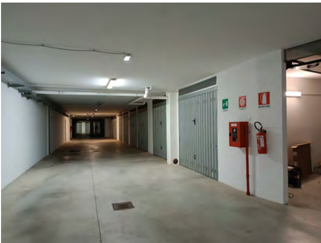
FOTO N.09 Corsia di manovra dei box
