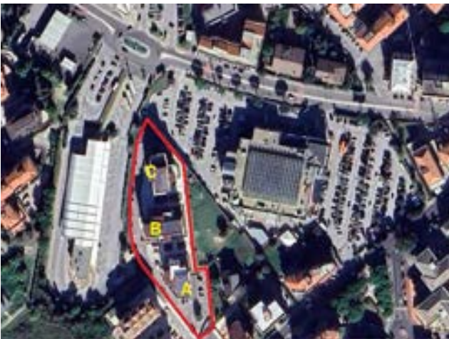
FOTO N.03 Inquadramento di zona mediante google maps
