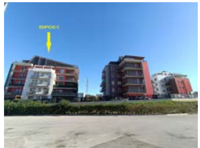
FOTO N.04 Inquadramento Edificio C
