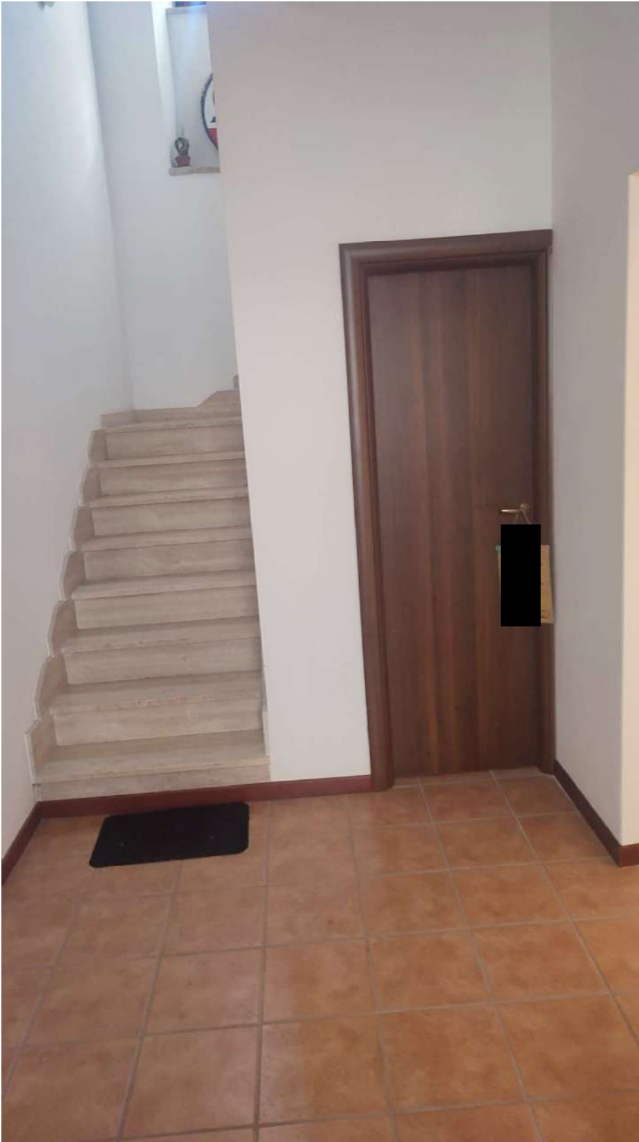
Ingresso piano terra vano scala condominiale e ripostiglio sub 8
