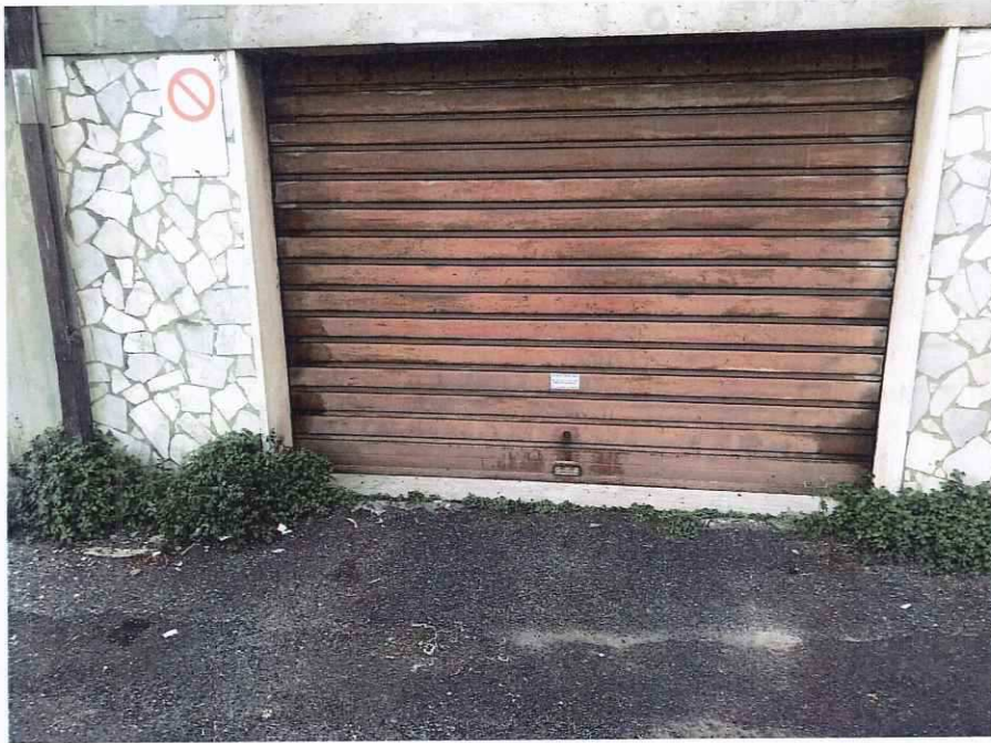
VIOTTOLO DI ACCESSO ALL' APPARTAMENTO IN VIA VALDELLORA 87
