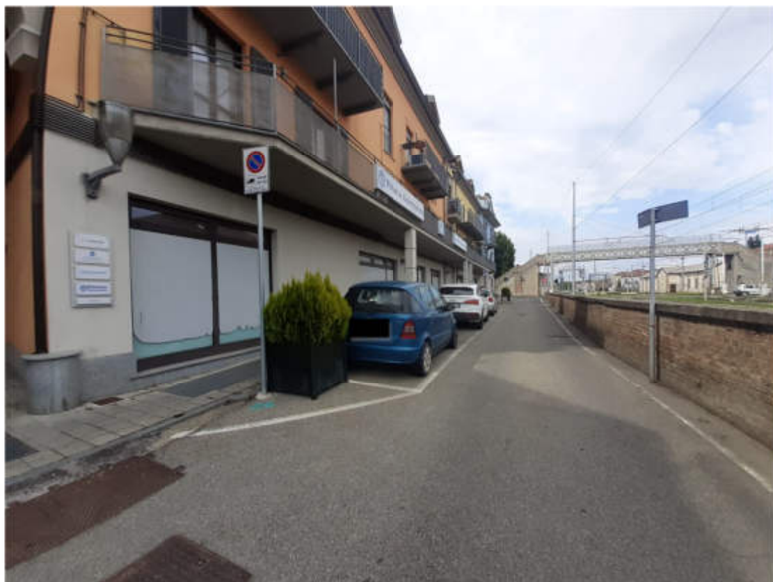
Vista delle vetrine prospettanti sulla sede stradale pubblica – Via San Carlo
