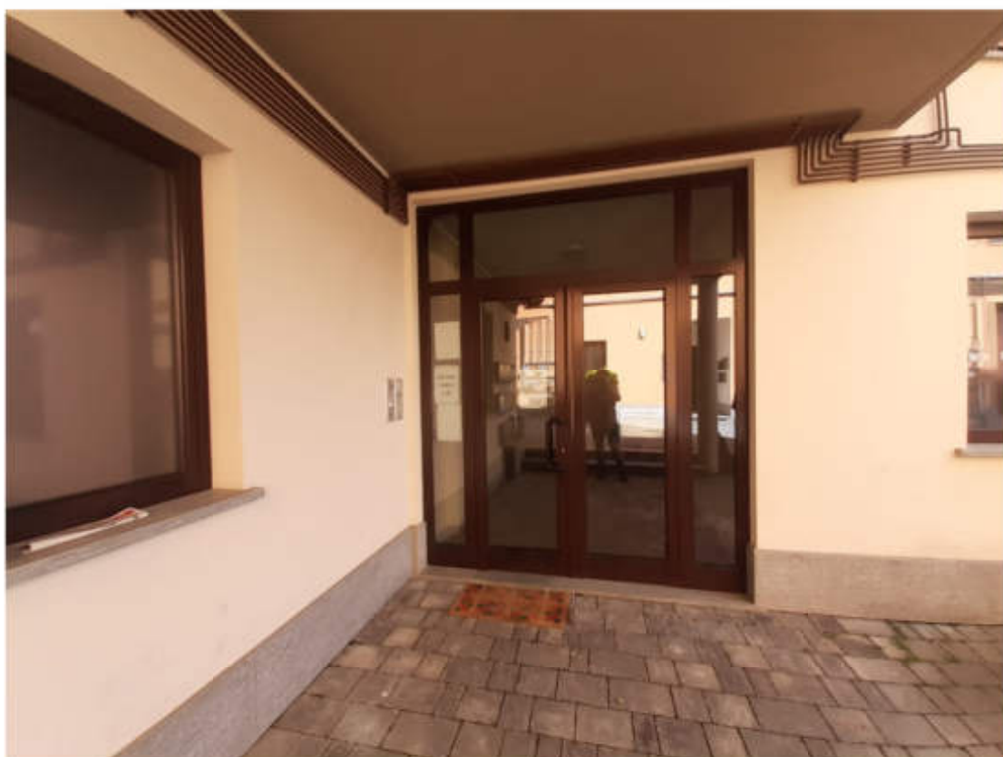
Vista dal cortile interno comune del portone di accesso alla scala condominiale " A "
