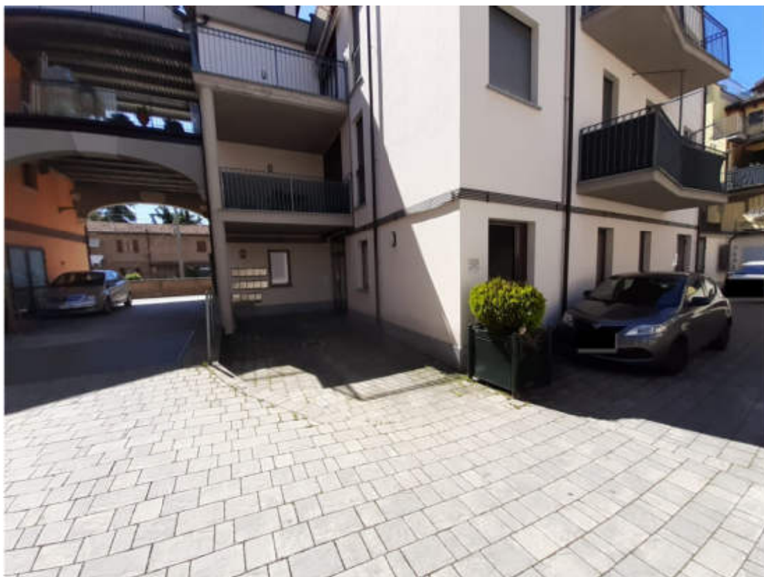
Vista del cortile interno comune alle U.I.U.
