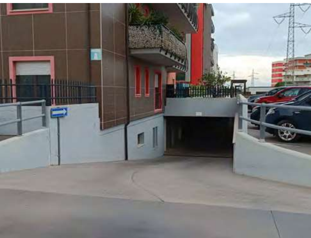
FOTO N.05-06 Corsie di entrata e di uscita al piano interrato dei box
