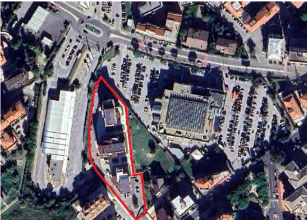
FOTO N.03 Inquadramento di zona mediante google maps
