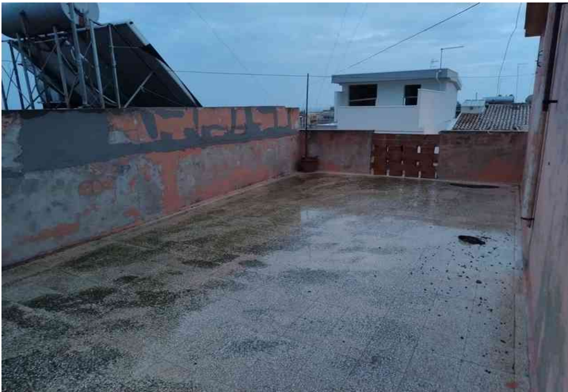
G.32 – Veduta del terrazzo lato Sud-Est (Terrazzo).
