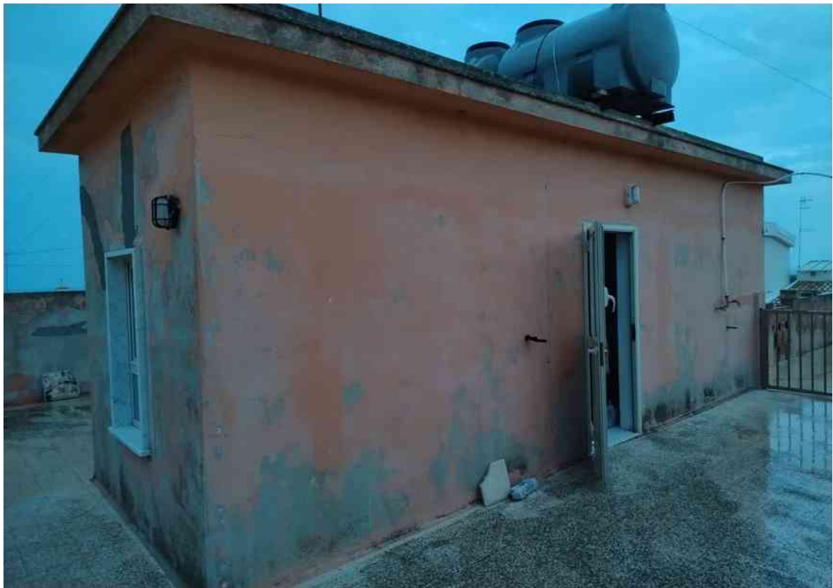
G.30 – Veduta esterna del corpo scale di accesso al terrazzo superiore (Terrazzo).
