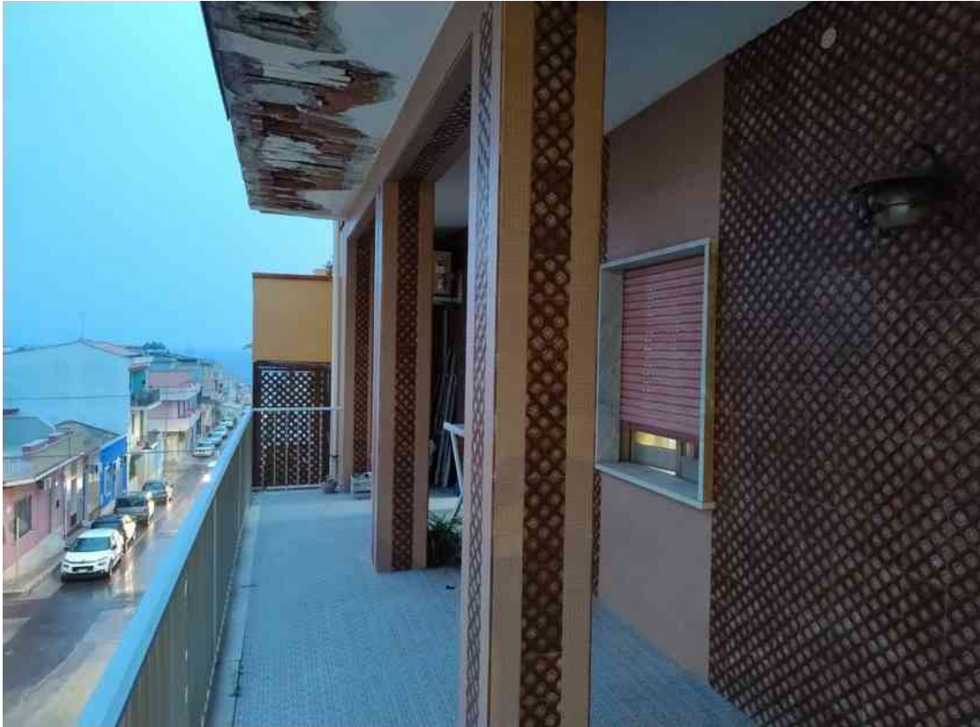
G.20 – Veduta dal balcone sul lato frontale al piano primo (balc 2).
