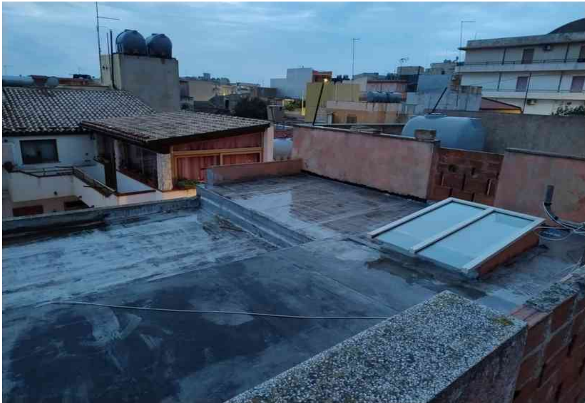
G.35 – Veduta della copertura a tetto piano (non calpestabile) lato Sud.
