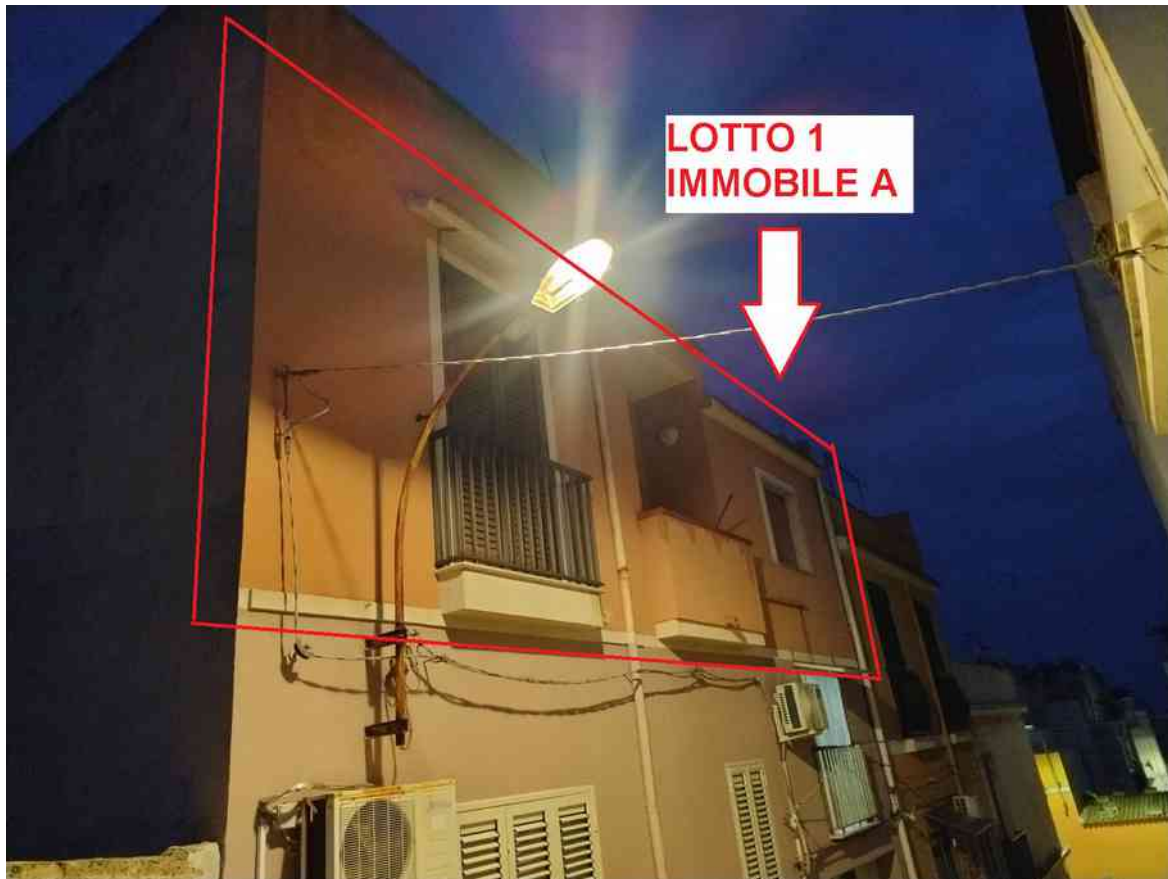
G.06 – altra veduta del prospetto secondario (affaccio posteriore) su Ronco 3° di Via Roma.
