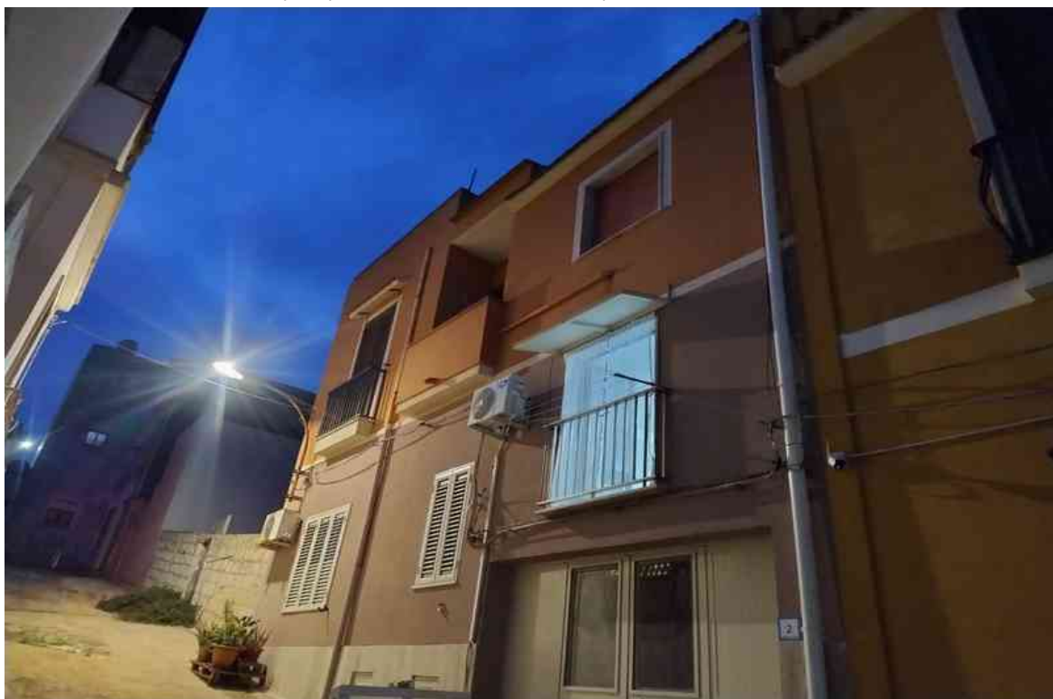
G.07 – altra veduta del prospetto secondario (affaccio posteriore) su Ronco 3° di Via Roma.
