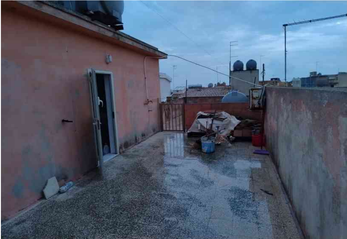
G.31 – Veduta del terrazzo lato Sud-Ovest (Terrazzo).
