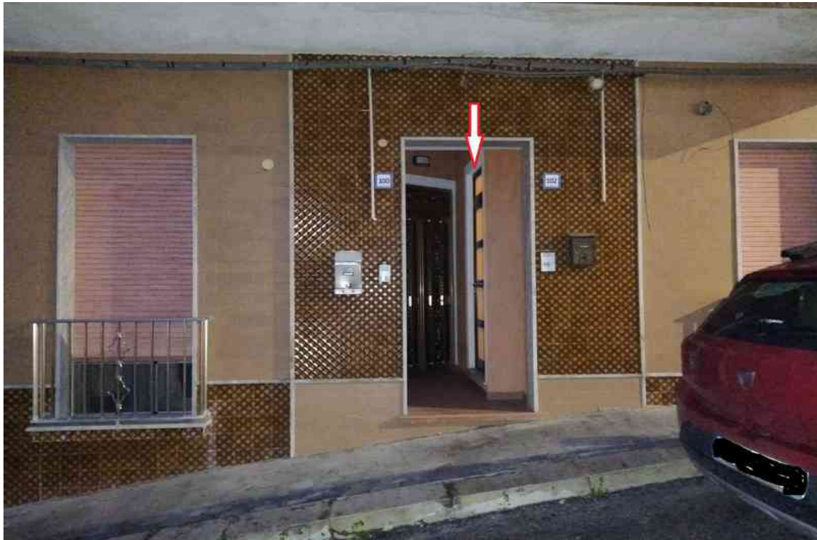
G.03 – Particolare del prospetto principale – porta d'ingresso di accesso alla scala del piano primo.
