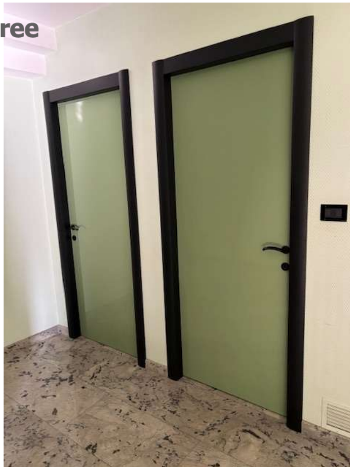
Foto n. 25 – Particolare degli infissi interni al piano terra, accesso ai due uffici anteriori
