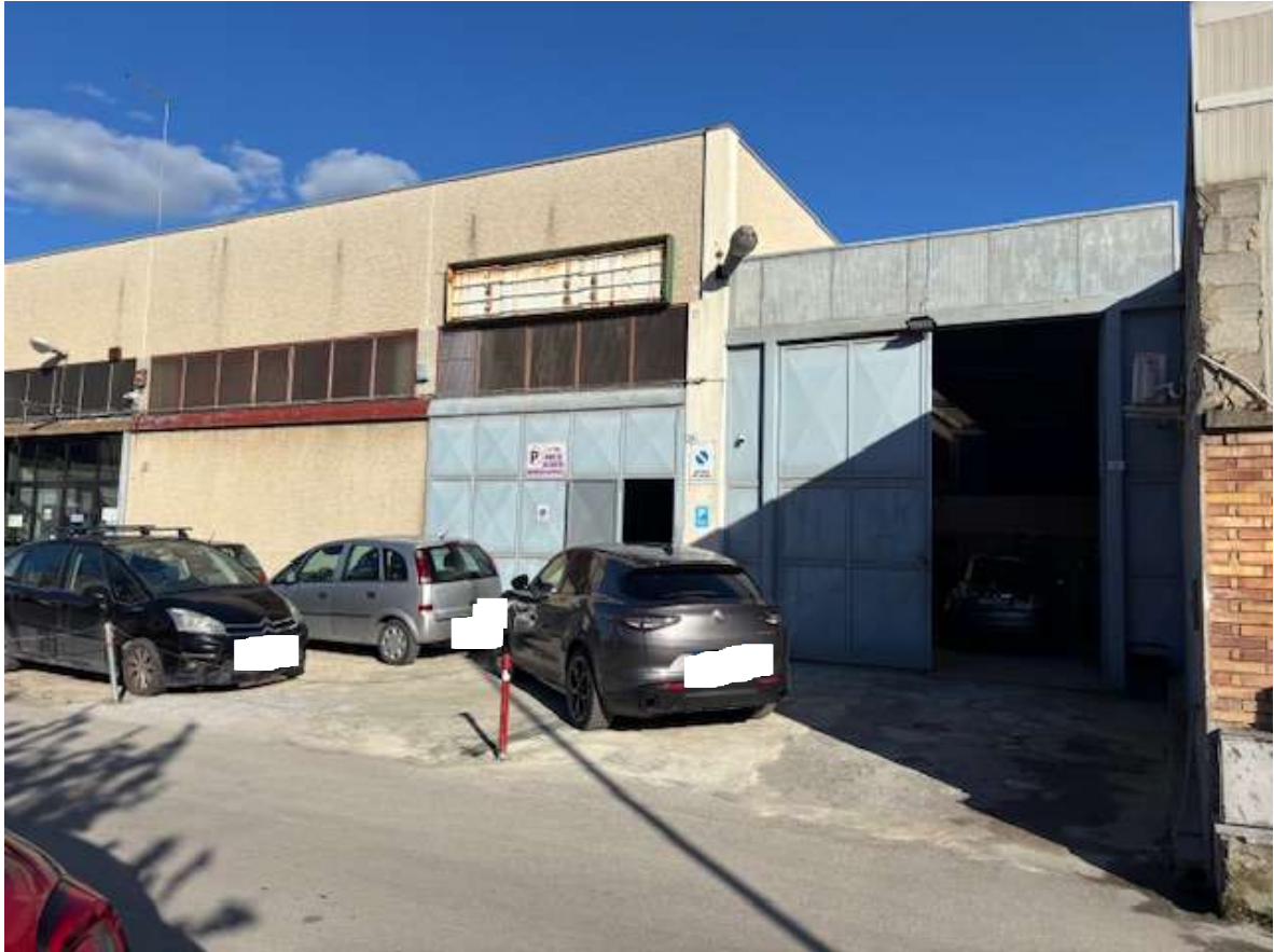
Foto n. 1 – Prospetto principale degli accessi da Via N. Bixio
