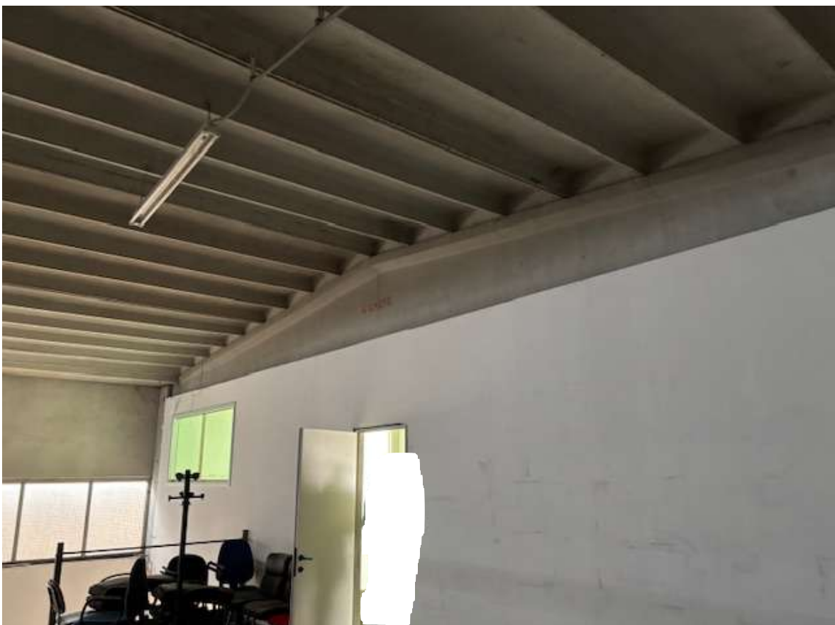
Foto n. 12 – Area al primo piano, soprastate la zona uffici (non accatastata) e porta d'accesso all'archivio
