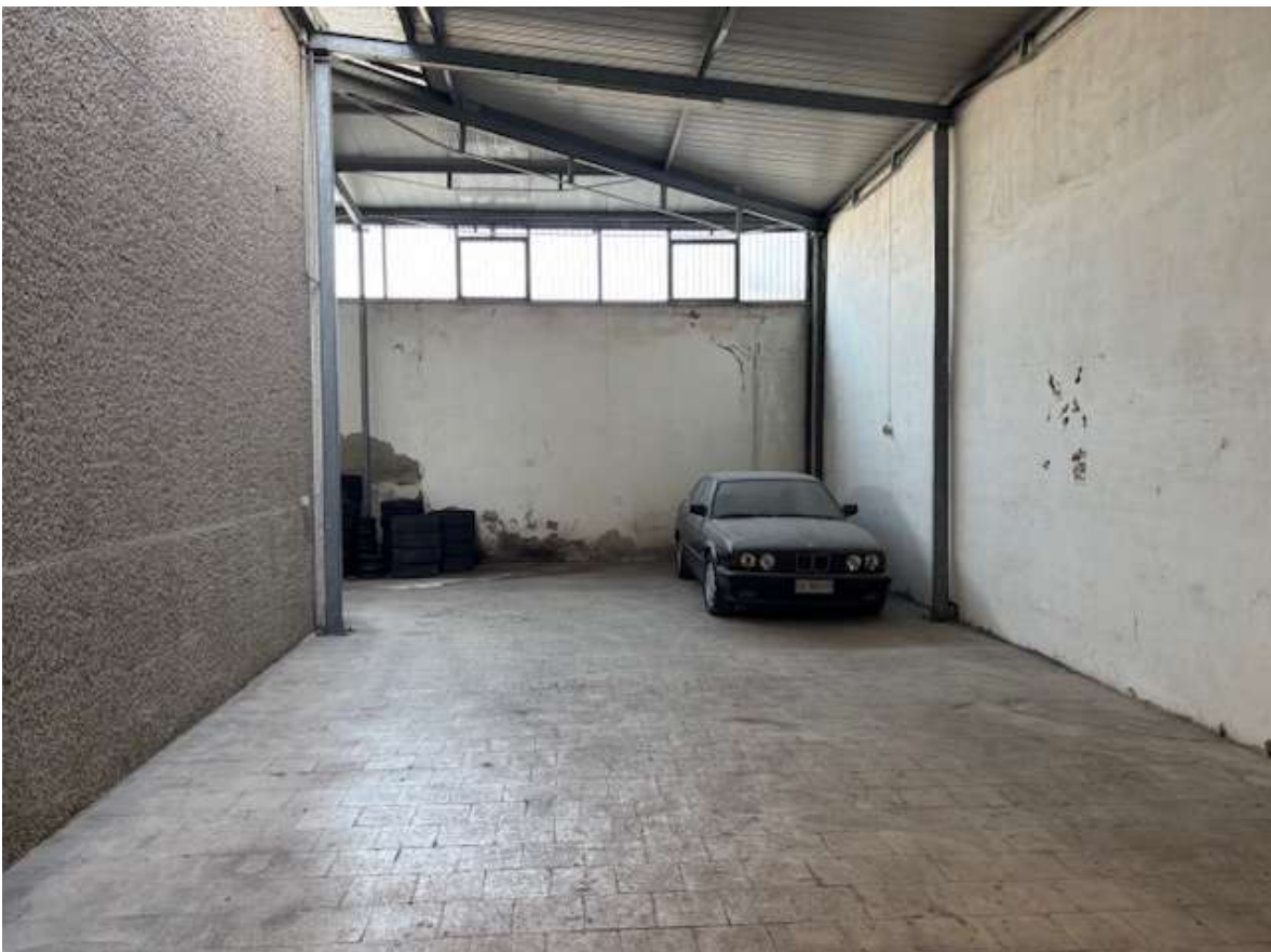
Foto n. 36 – Zona laterale e retrostante il capannone principale
