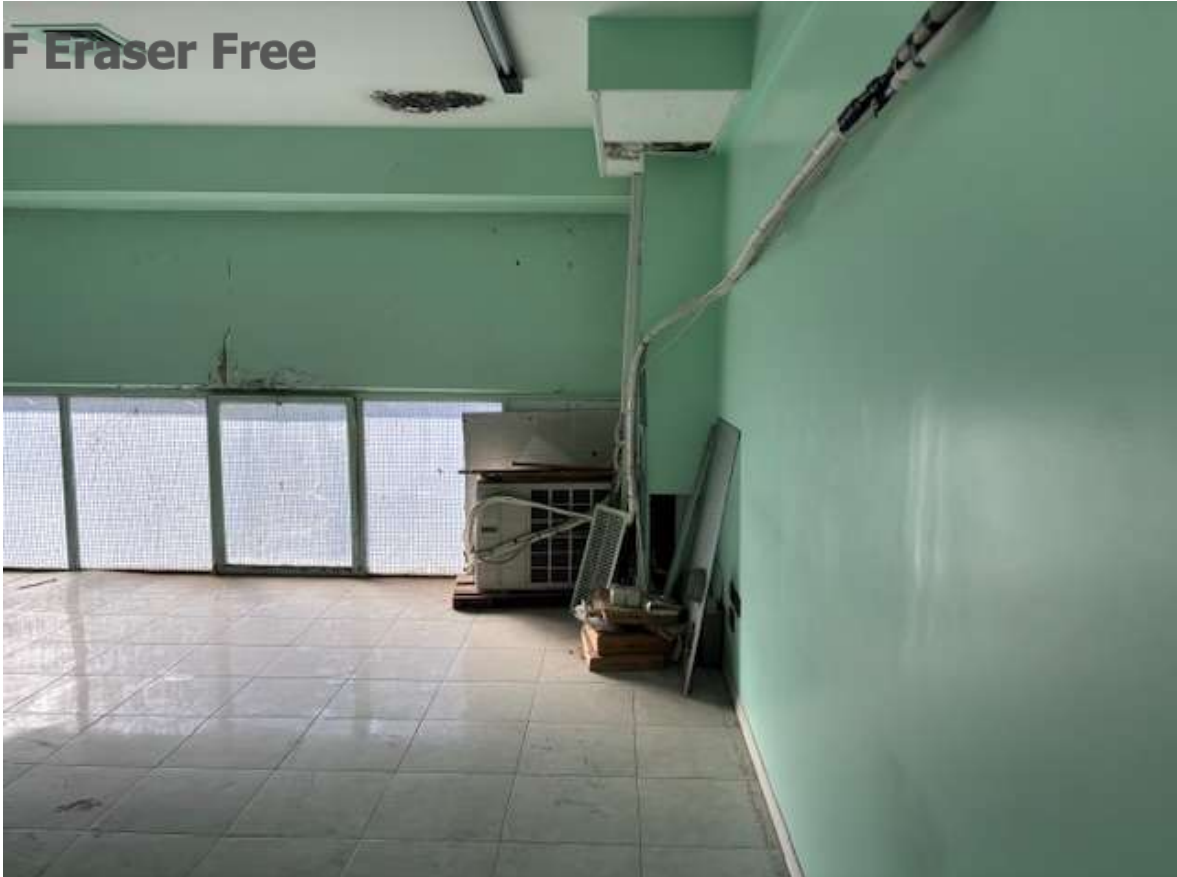
Foto n. 15 – Primo piano, prima stanza d'archivio, finestre sul prospetto principale
