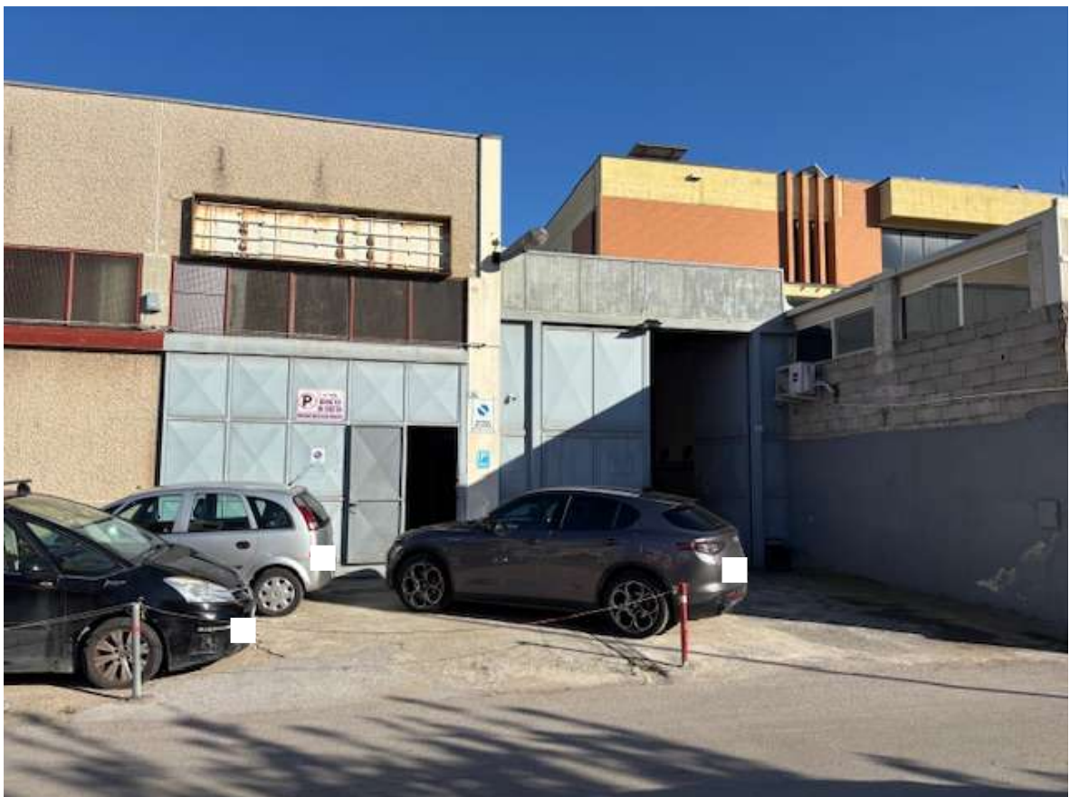
Foto n. 2 – Prospetto principale degli accessi da Via N. Bixio
