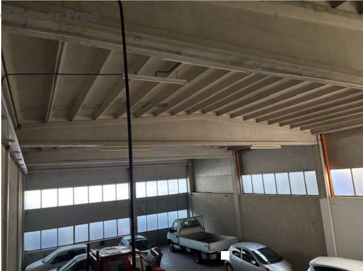
Foto n. 13 – Particolare dei tegoli di copertura del capannone e delle finestrate
