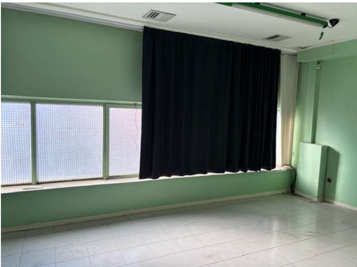
Foto n. 20 – Seconda stanza d'archivio, finestratura sul prospetto principale
