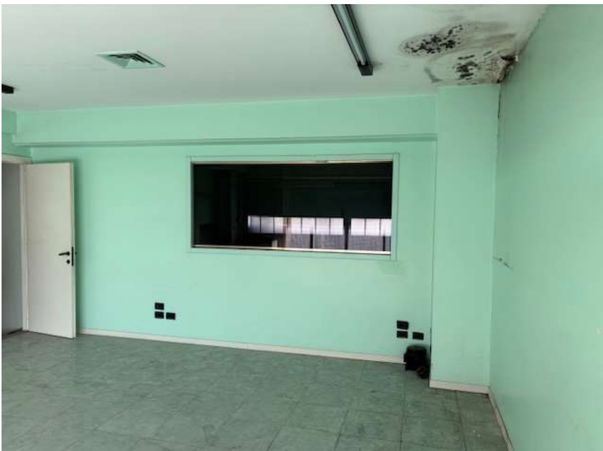
Foto n. 16 – Primo piano, prima stanza d'archivio, finestrata sul prospetto retrostante
