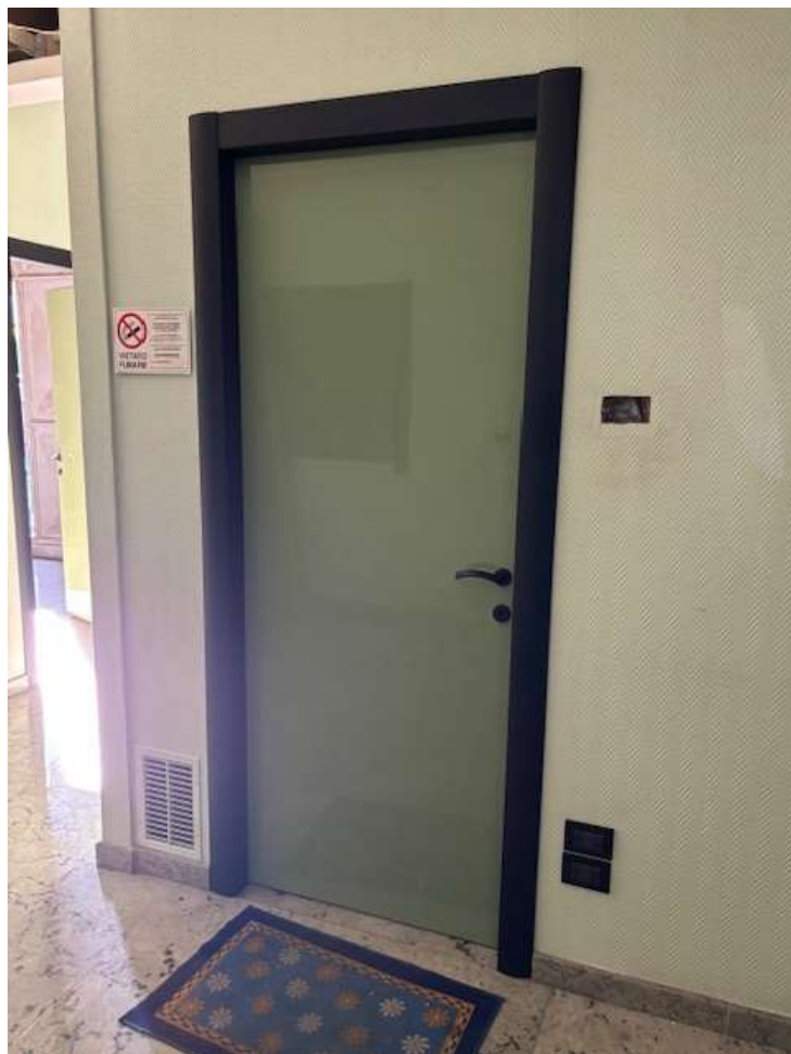
Foto n. 24 – Particolare degli infissi interni al piano terra della zona uffici
