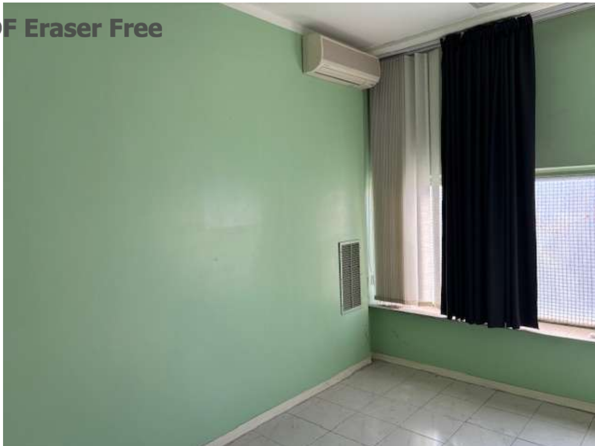
Foto n. 21 – Seconda stanza d'archivio, finestratura sul prospetto principale
