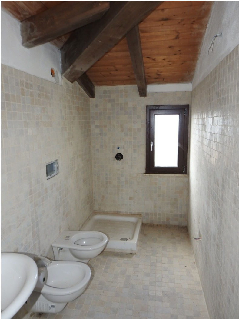
Figura 47 - Piano primo, bagno
