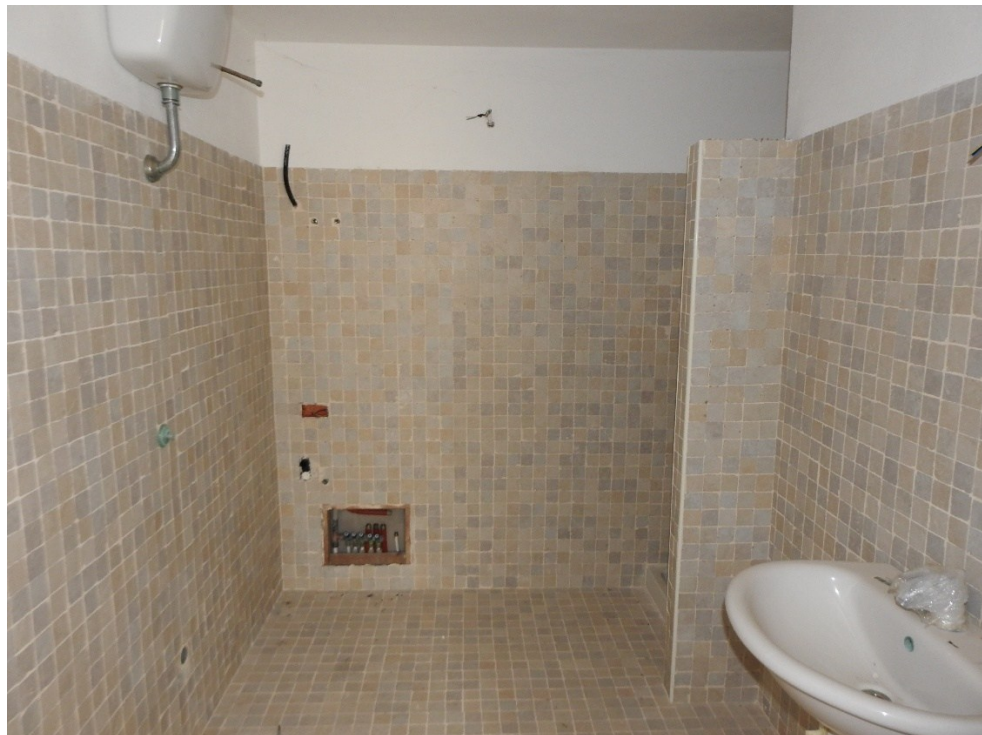
Figura 31 - Piano seminterrato, bagno
