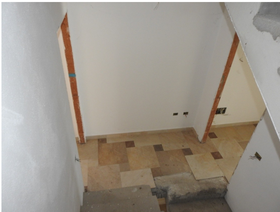
Figura 34 - Piano Terra, disimpegno vano scala
