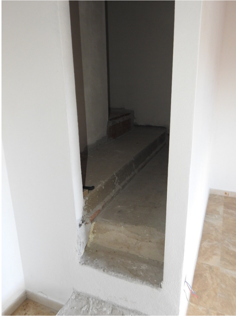
Figura 44 - Piano primo, cabina armadio
