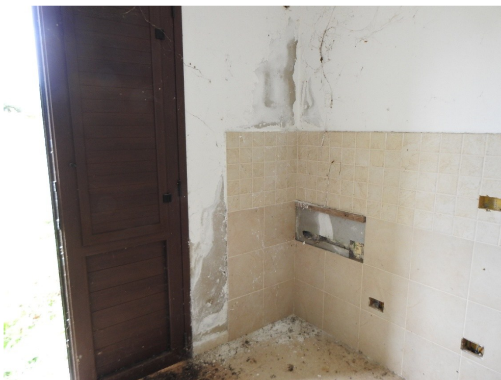
Figura 53 - Patologie edilizie, umidità per capillarità al piano seminterrato e impianti non ultimati
