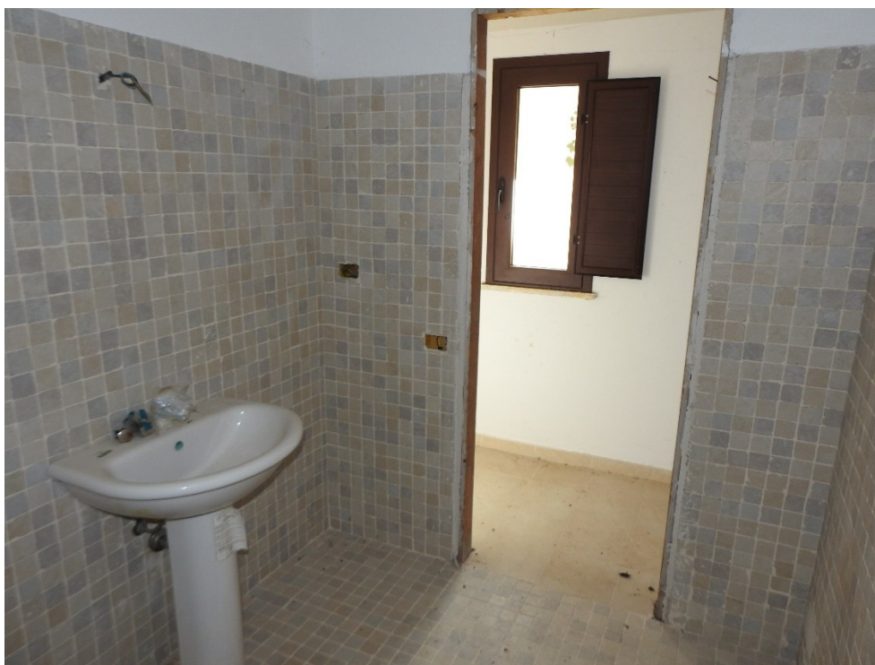
Figura 32 - Piano seminterrato, bagno
