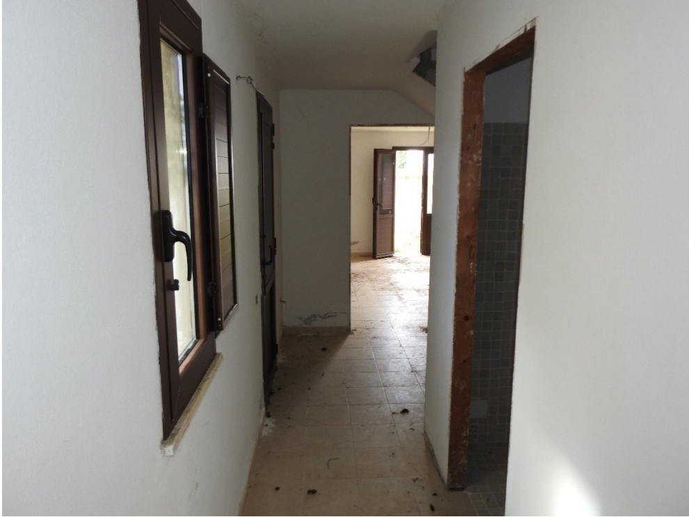
Figura 28 - Piano seminterrato, disimpegno
