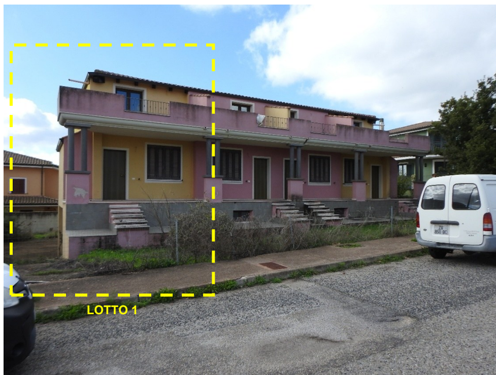
Figura 20 - Visuale complessiva del fabbricato da via degli Ulivi
