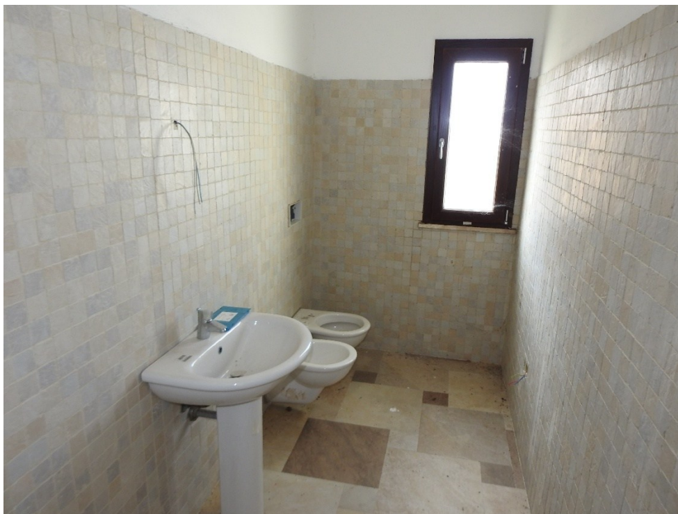
Figura 36 - Piano Terra, bagno
