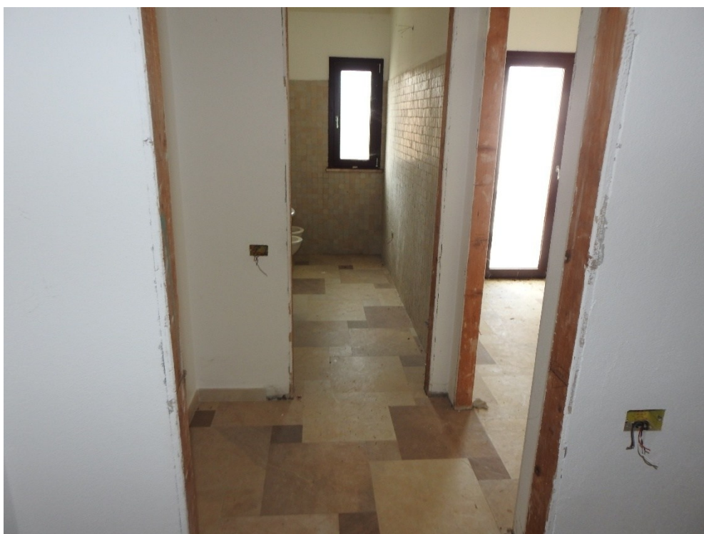
Figura 35 - Piano Terra, disimpegno bagno/cucina
