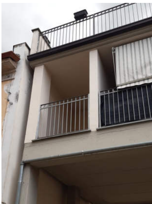
Vista locale in piano secondo – lastrico solare inaccessibile
