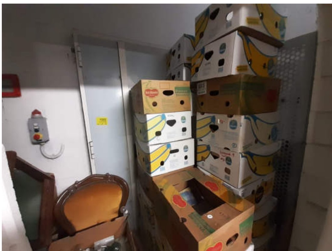
Vista interna suddivisione ambienti piano interrato - particolare montacarichi
