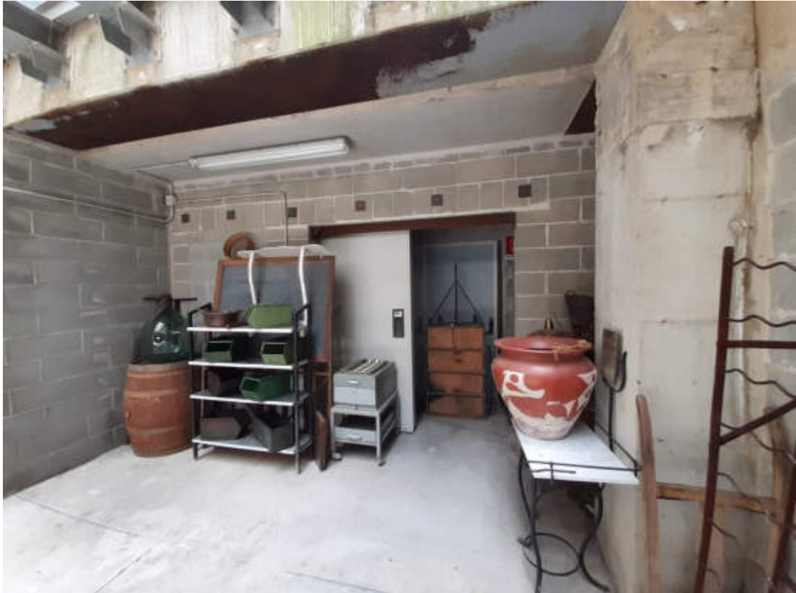
Vista da corsia di manovra in piano interrato dell'accesso alla U.I.U. oggetto di valutazione
