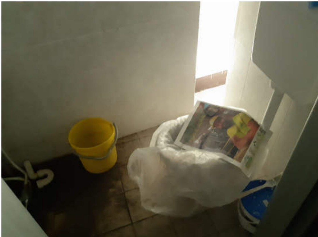
Vista interna locale bagno piano terra
