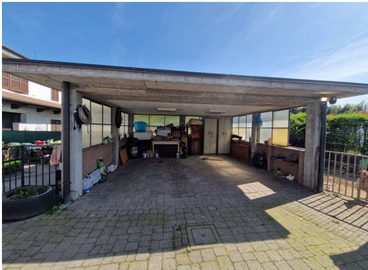
16 - vano autorimessa esterno
