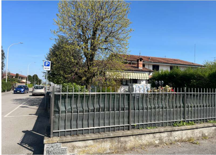
1 - facciata prospettante sul parcheggio pubblico
