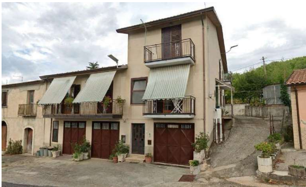
1 | Vista fabbricato dalla S.S. 7 Appia
