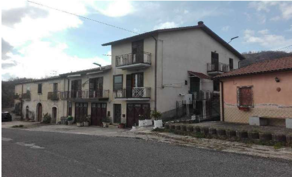
3 | Vista fabbricato dalla S.S. 7 Appia
