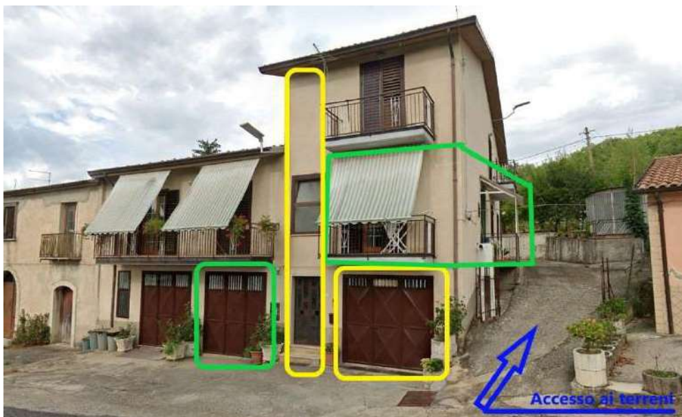
2 | Vista fabbricato dalla S.S. 7 Appia
