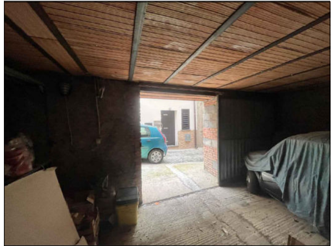
Magazzino piano terra
