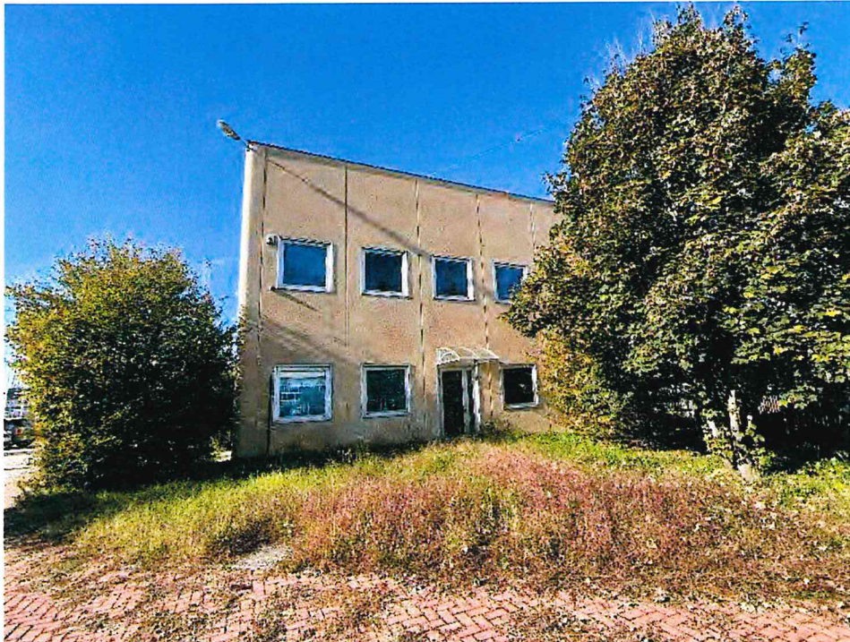
5. Vista del fabbricato sul lato sud-est con accesso secondario per la sala conferenze.
