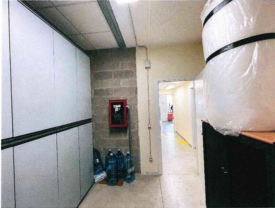
35. Locaie deposito accanto al laboratorio.
