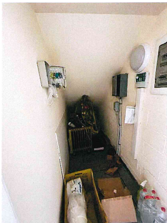
18. Vano ripostiglio sottoscala.
