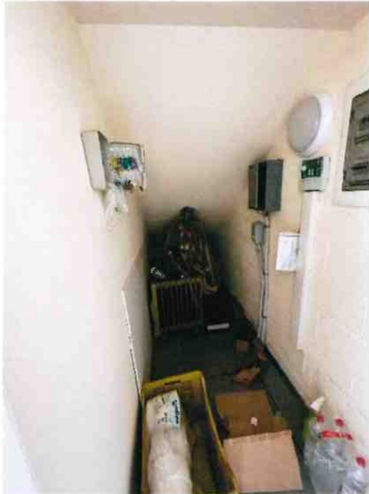
18. Vano ripostiglio sottoscala.
