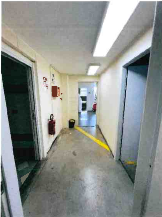
20. Corridoio antistante l'accesso al laboratorio.
