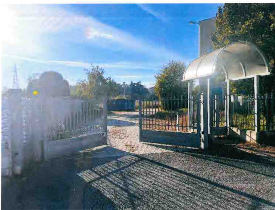
2. Accesso carrabile e pedonale.
