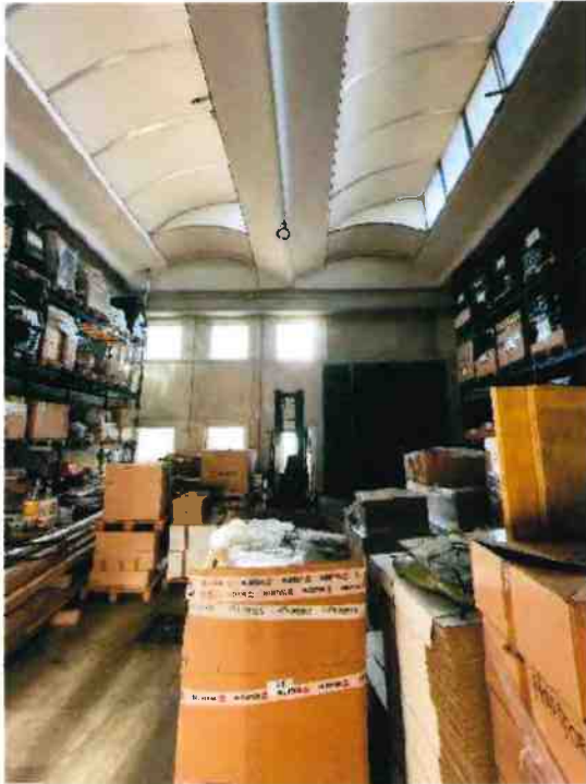
41. Laboratorio con accesso dal cortile.
