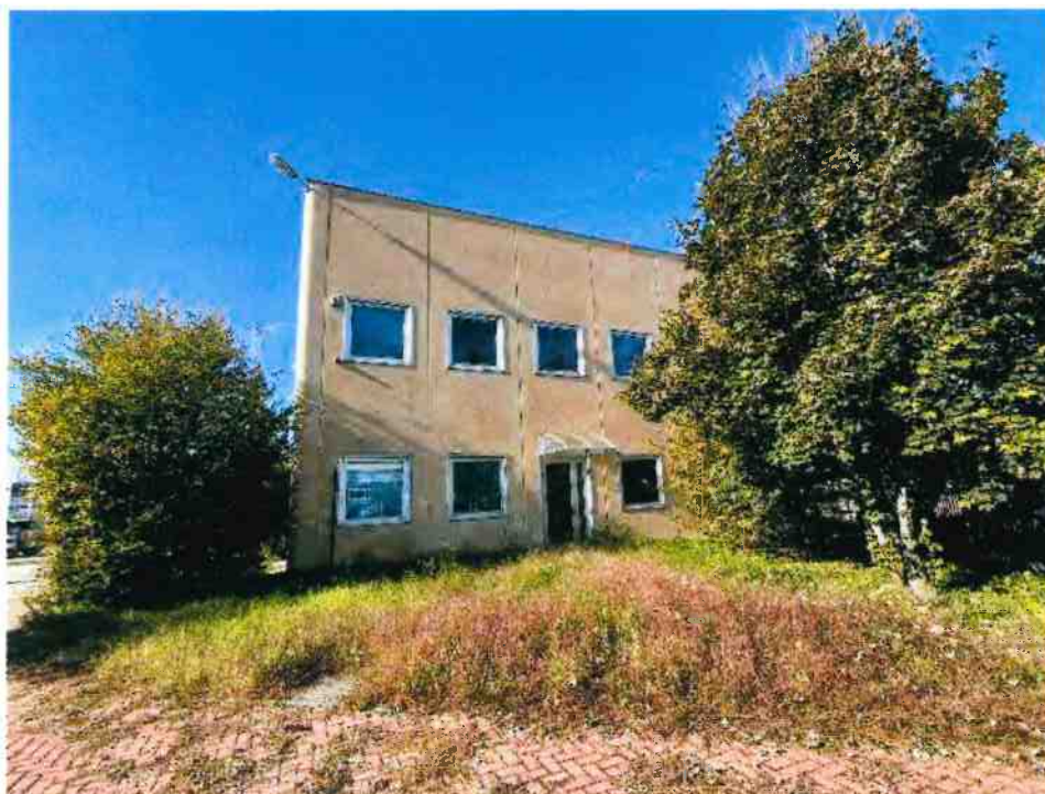
5. Vista del fabbricato sul lato sud-est con accesso secondario per la sala conferenze.
