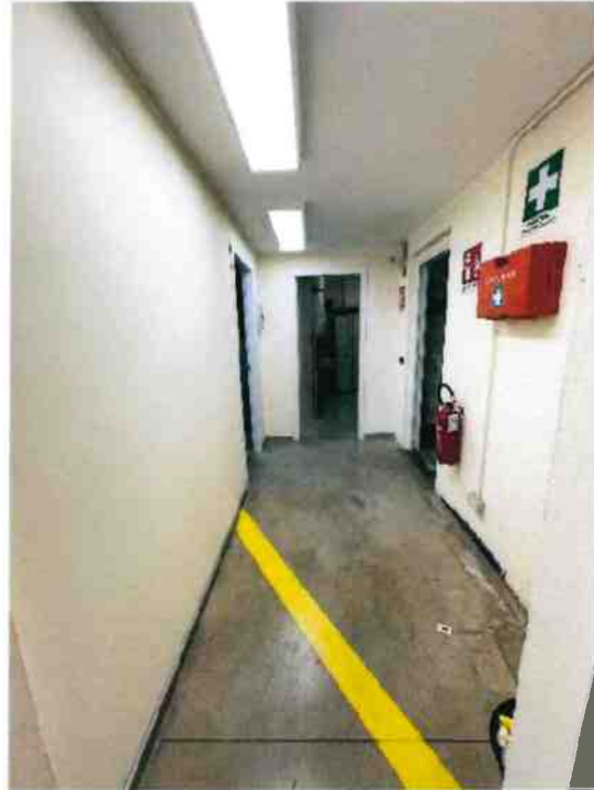
19. Corridoio antistante l'accesso al laboratorio.
