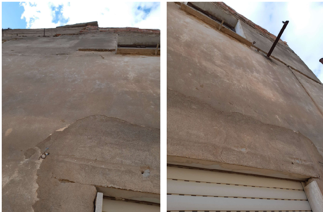
Figura 3 – parte del prospetto sopra il balcone dell'immobile, lato afferente su via Alonge
