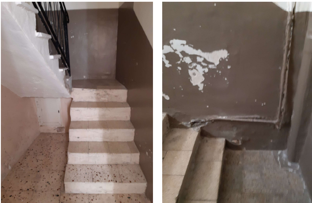
figure 2: vano scala condominiale
