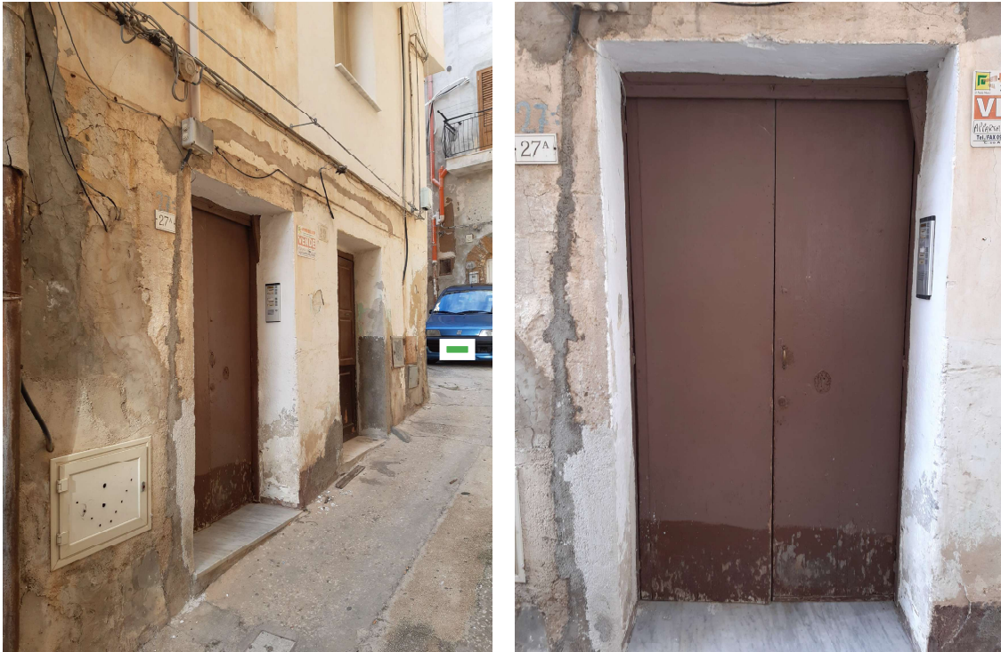
FIGURA 1: ingresso principale al civico 27/A (condominiale)
