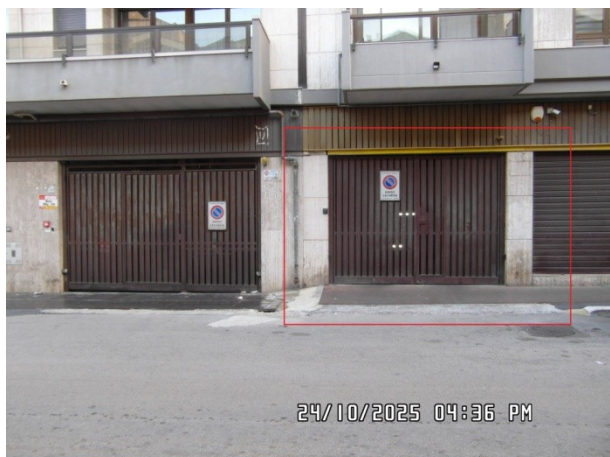
accesso esterno da via Gorizia
