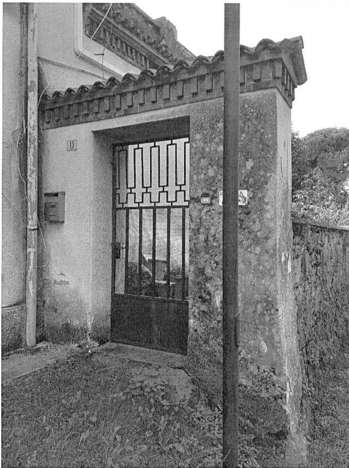
Foto n° 08 - Portone di Accesso presso il Civico n° 15 di via San Rocco
