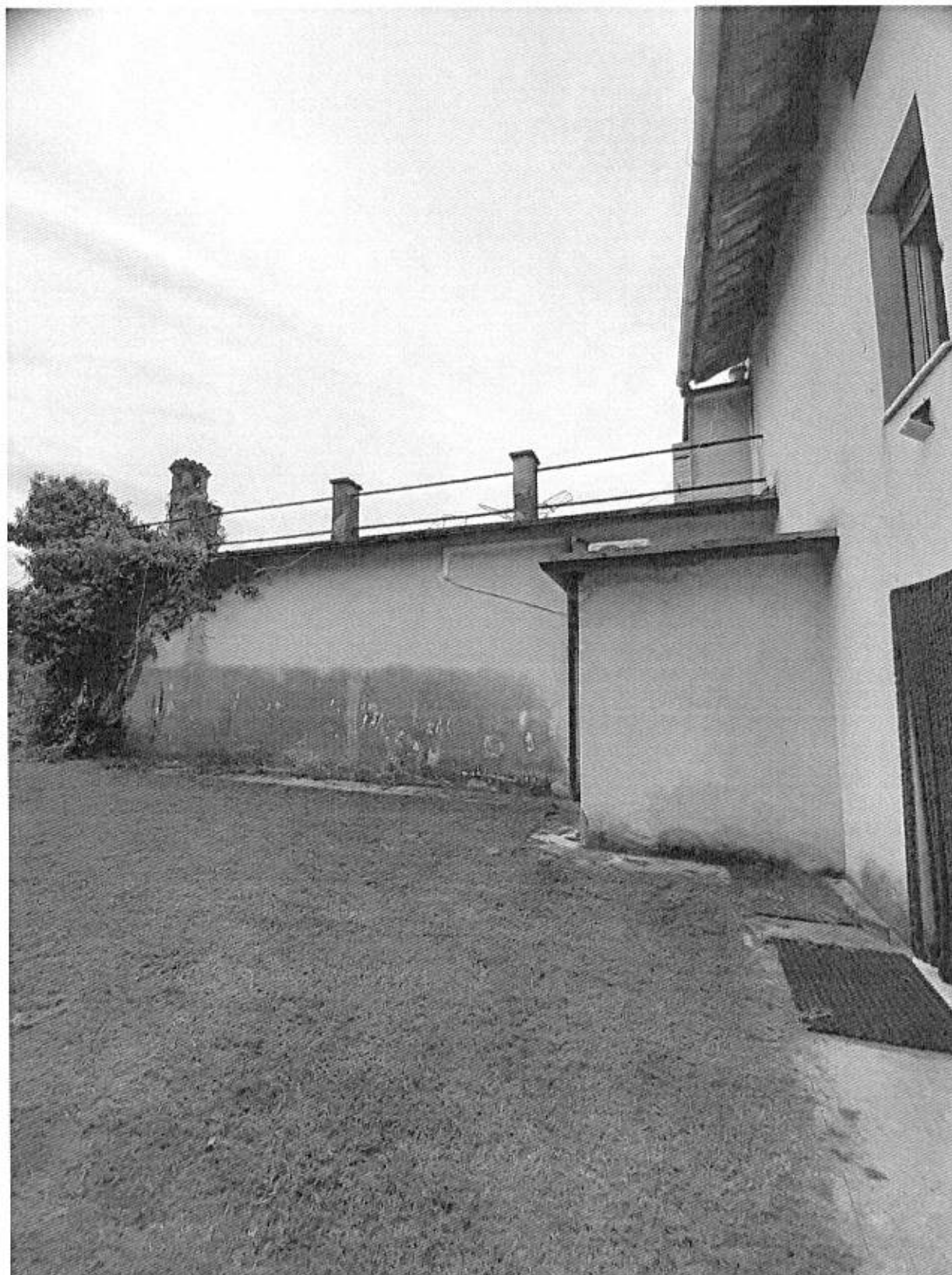
Foto n° 42 - Dalla Corte pertinenziale, vista di porzione del fabbricato eretto sulla p.c. 429/9
