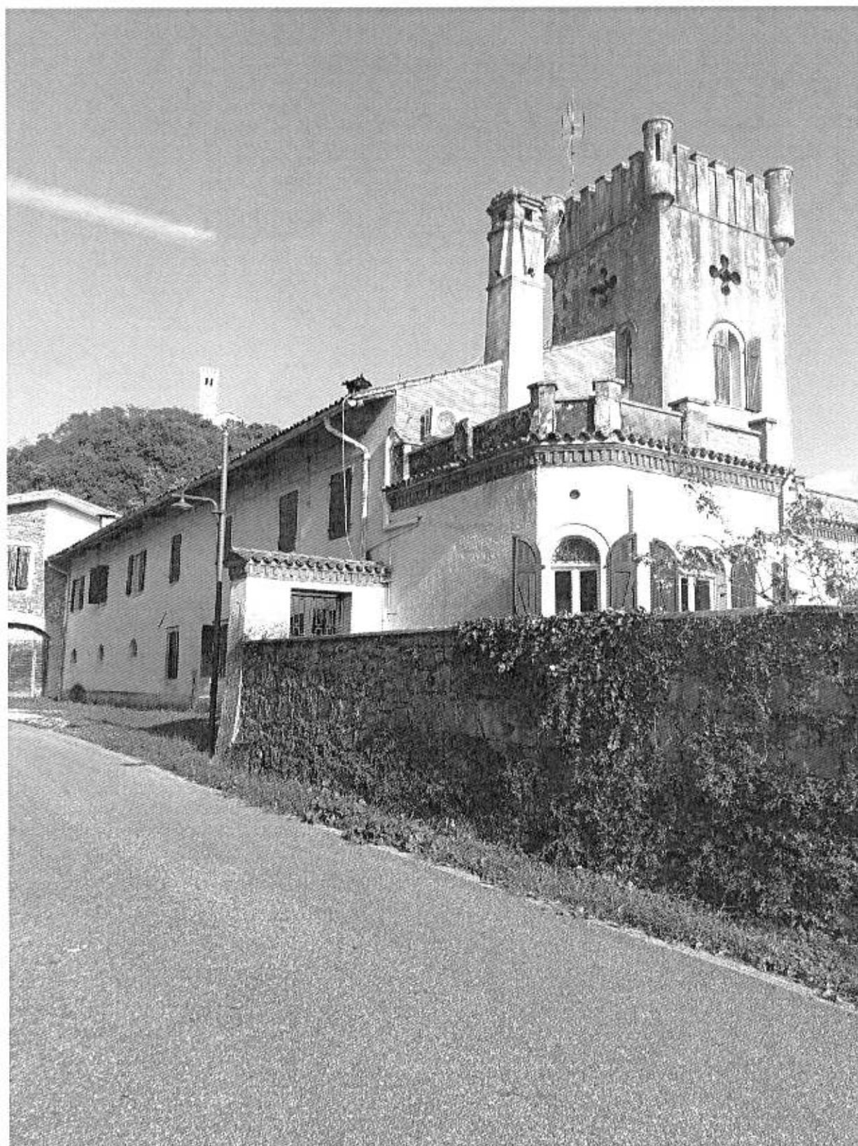
Foto n° 01 - Vista del Fabbricato su p.c. 429/9 e del Muretto di Recinzione da via San Rocco
