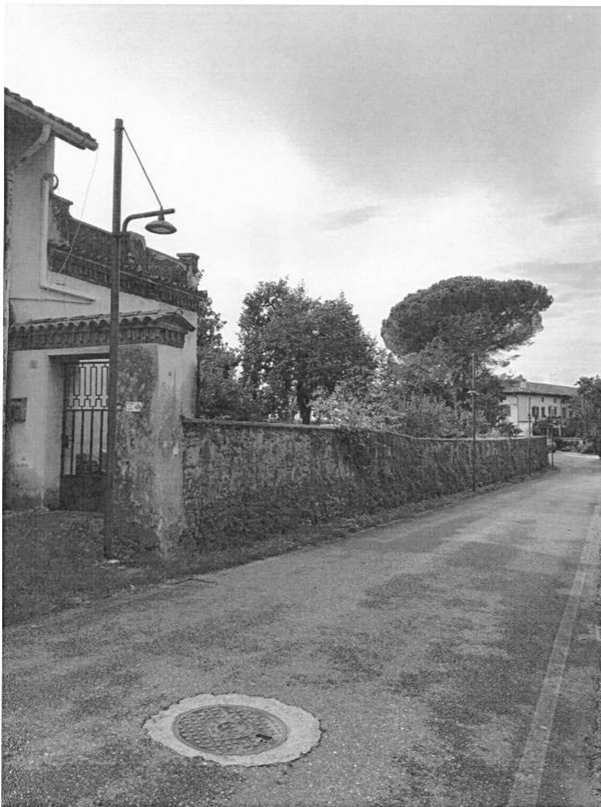
Foto n° 13 - Scorcio Portone di Accesso presso il Civico n° 15 di via San Rocco e del Muretto di Recinzione
