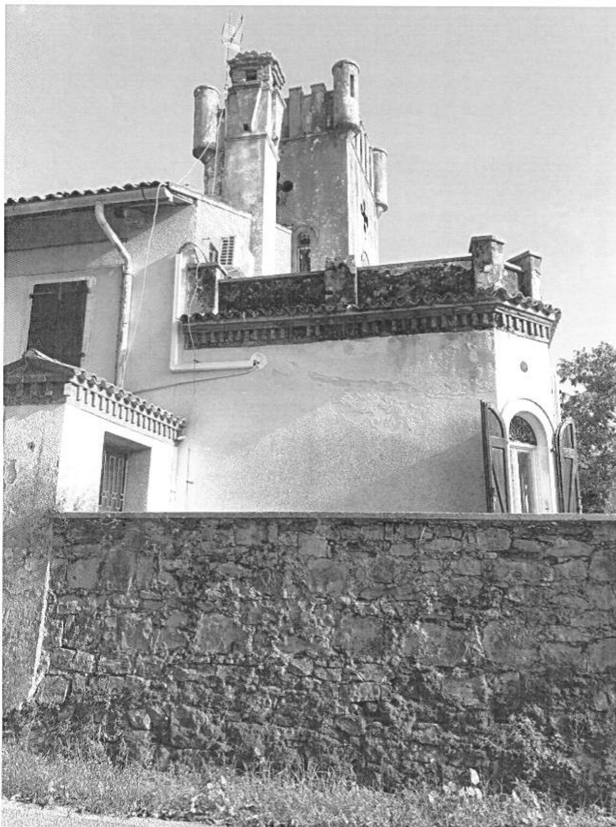
Foto n° 05 - Vista del Fabbricato su p.c. 429/9 e del Muretto di Recinzione da via San Rocco
