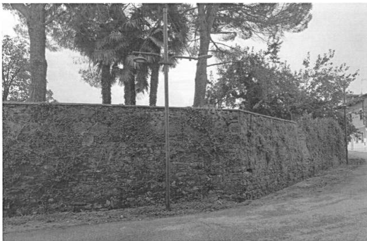
Foto n° 18 - Muretto di Recinzione lungo via San Rocco
