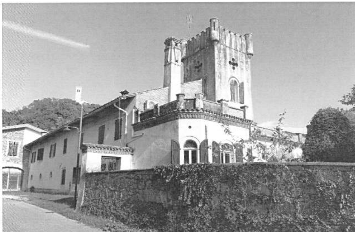
Foto n° 03 - Vista del Fabbricato su p.c. 429/9 e del Muretto di Recinzione da via San Rocco
