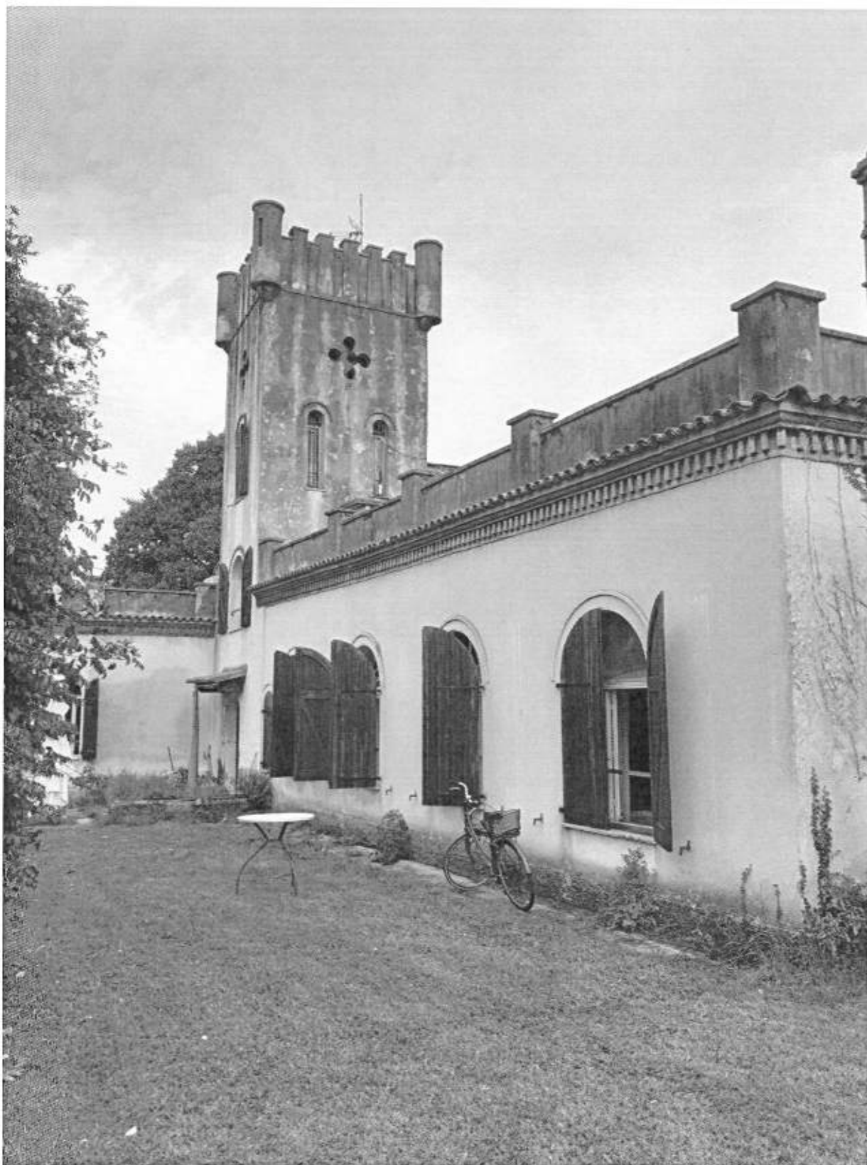
Foto n° 33 - Dalla p.c. 429/2 (di fatto strada), vista di porzione del fabbricato su p.c. 429/9
