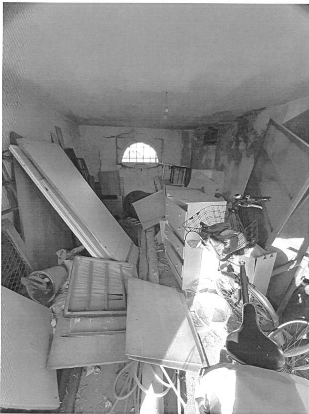
Foto n° 02 - "U.I. Sub. 4 Rimessa" - Piano Terra - Box Auto Chiuso
