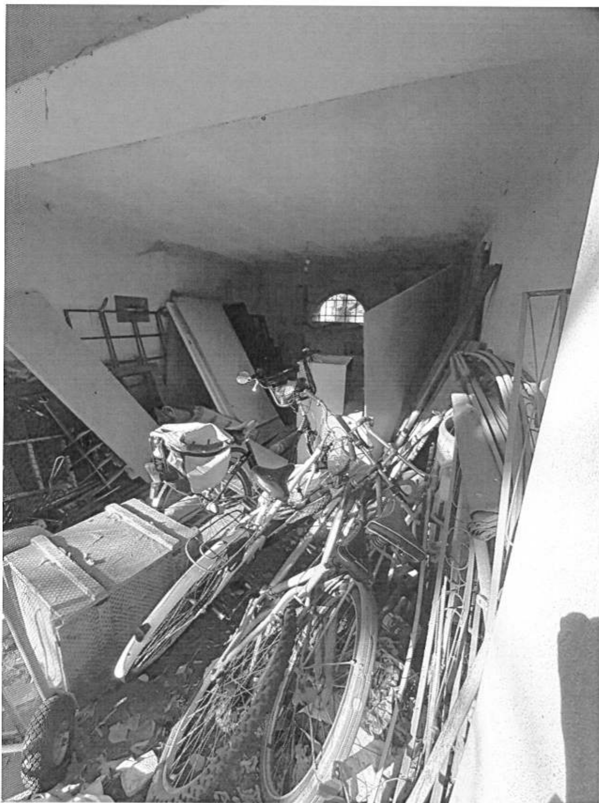
Foto n° 04 - "U.I. Sub. 4 Rimessa" - Piano Terra - Box Auto Chiuso
