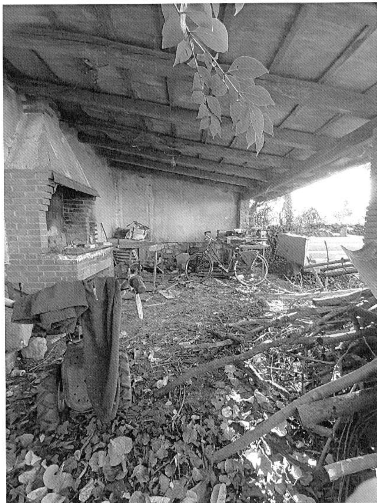
Foto n° 7 - "U.I. Sub. 5 Rimessa" - Piano Terra - Posto Auto Coperto
