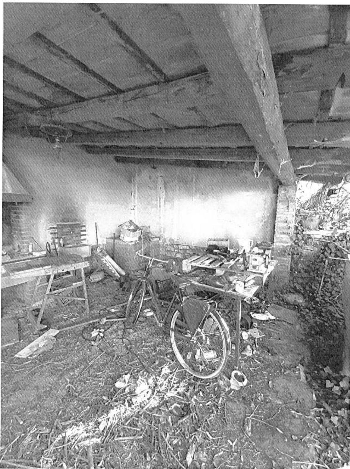
Foto n° 8 - "U.I. Sub. 5 Rimessa" - Piano Terra - Posto Auto Coperto
