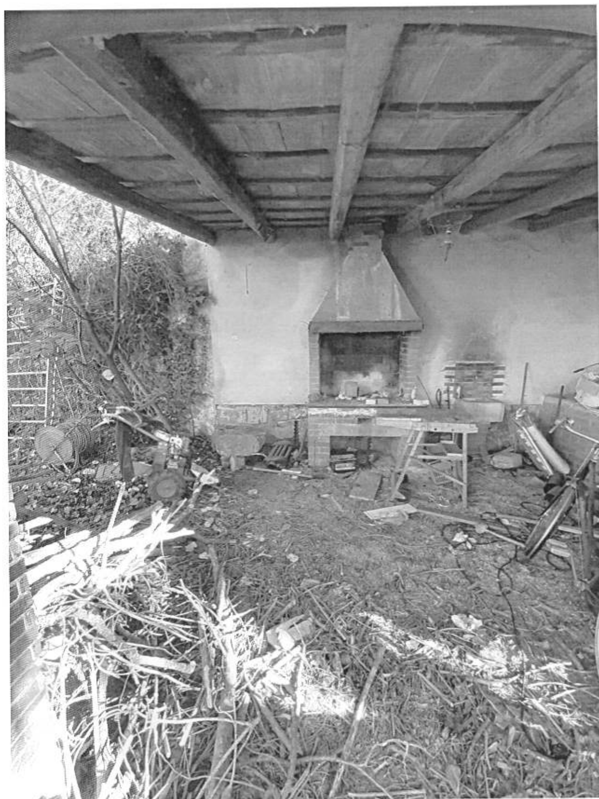
Foto n° 9 - "U.I. Sub. 5 Rinessa" - Piano Terra - Posto Auto Coperto
