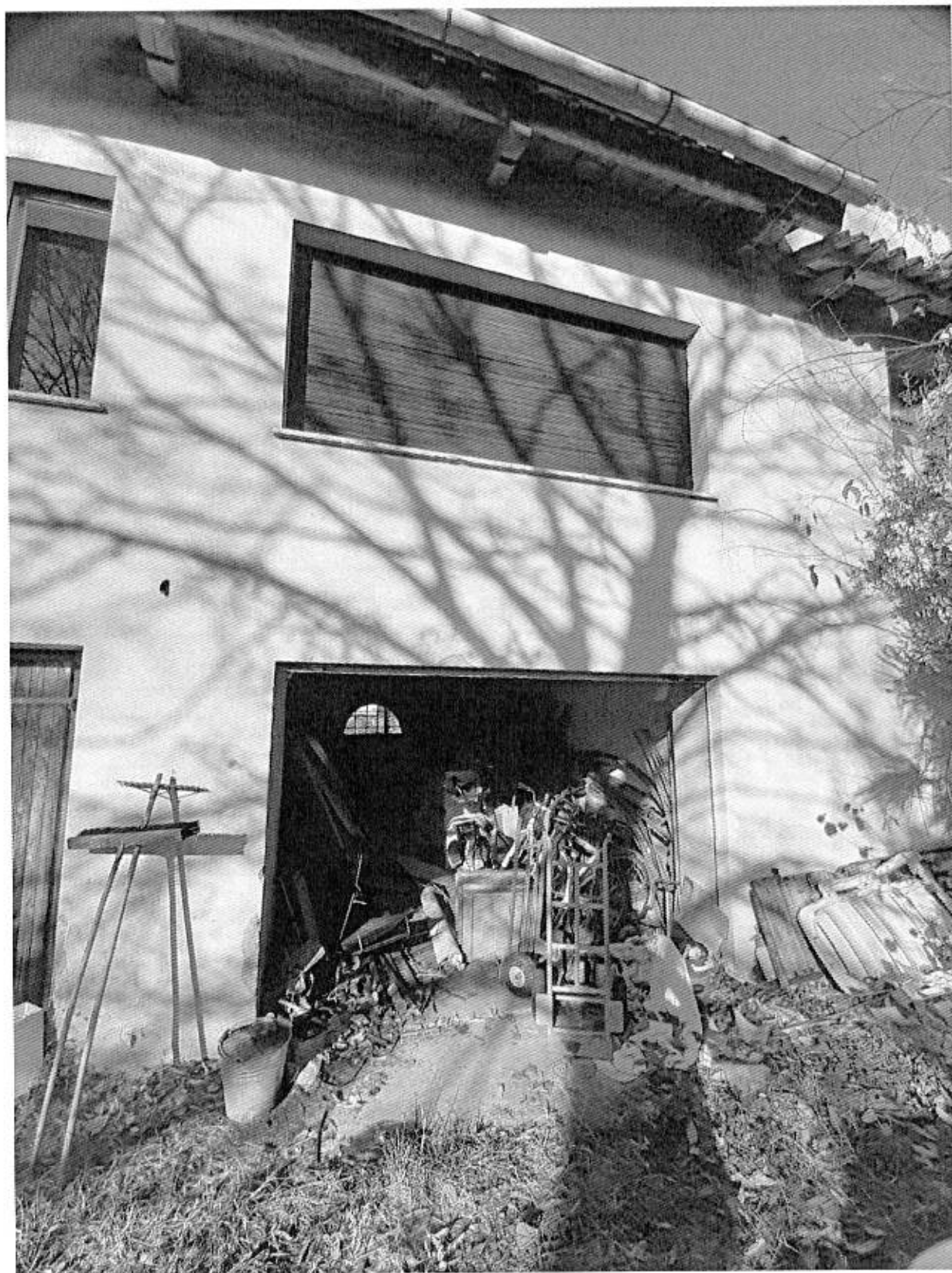
Foto n° 01 - "U.I. Sub. 4 Rimessa" - Piano Terra - Box Auto Chiuso
