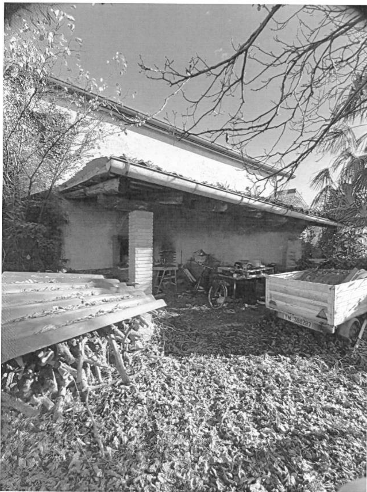
Foto n° 6 - "U.I. Sub. 5 Rimessa" - Piano Terra - Posto Auto Coperto
