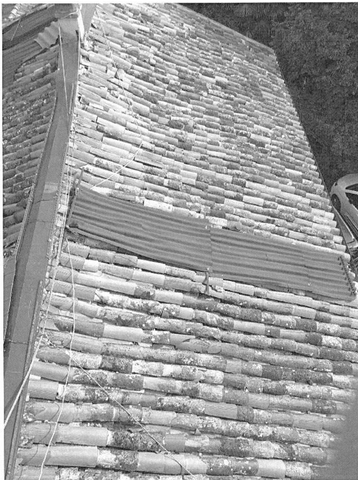
Foto n° 91 - Piano Quarto - vista dalla Terrazza Panoramica delle sottostanti coperture
