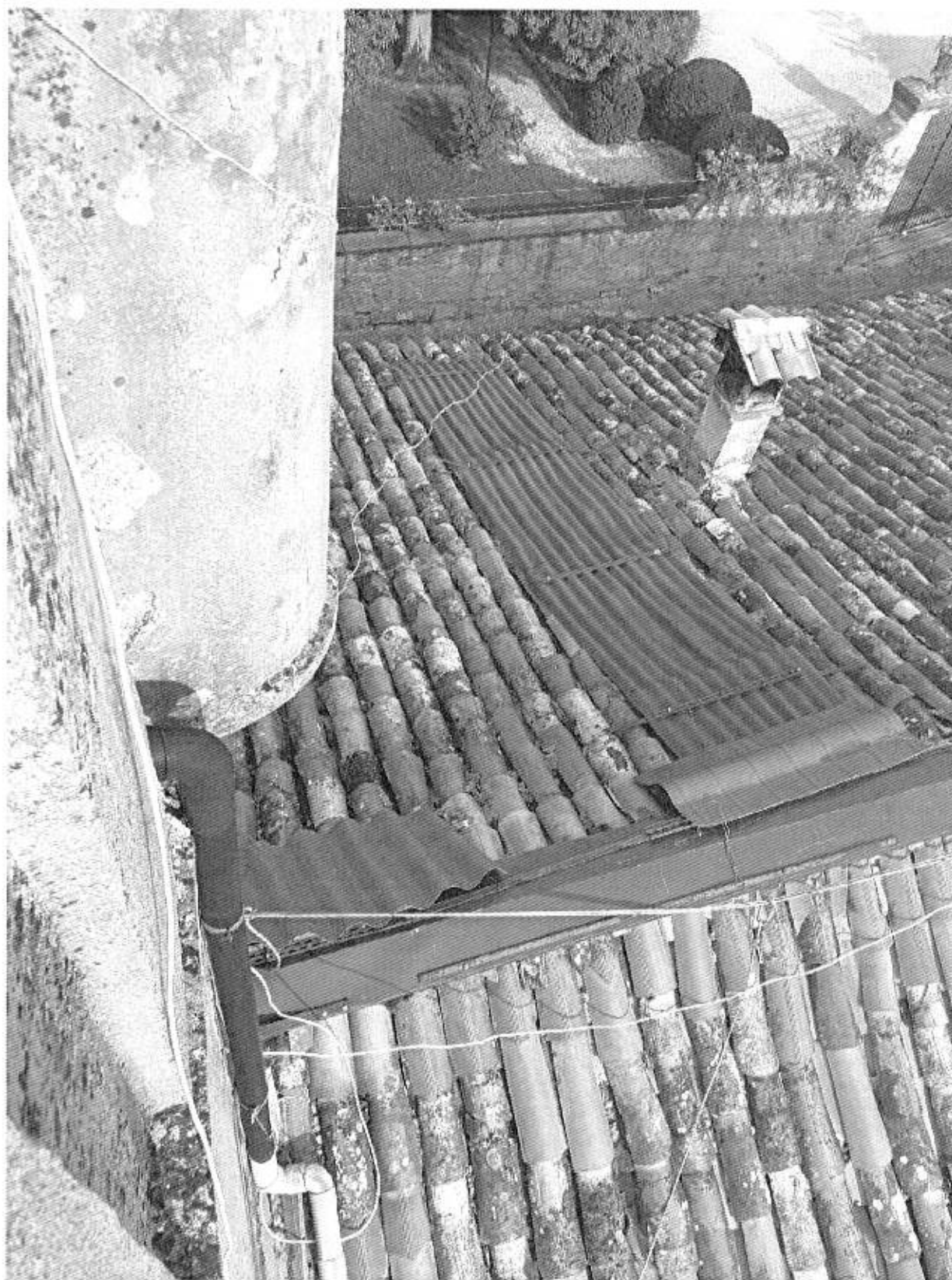
Foto n° 89 - Piano Quarto - vista dalla Terrazza Panoramica delle sottostanti coperture
