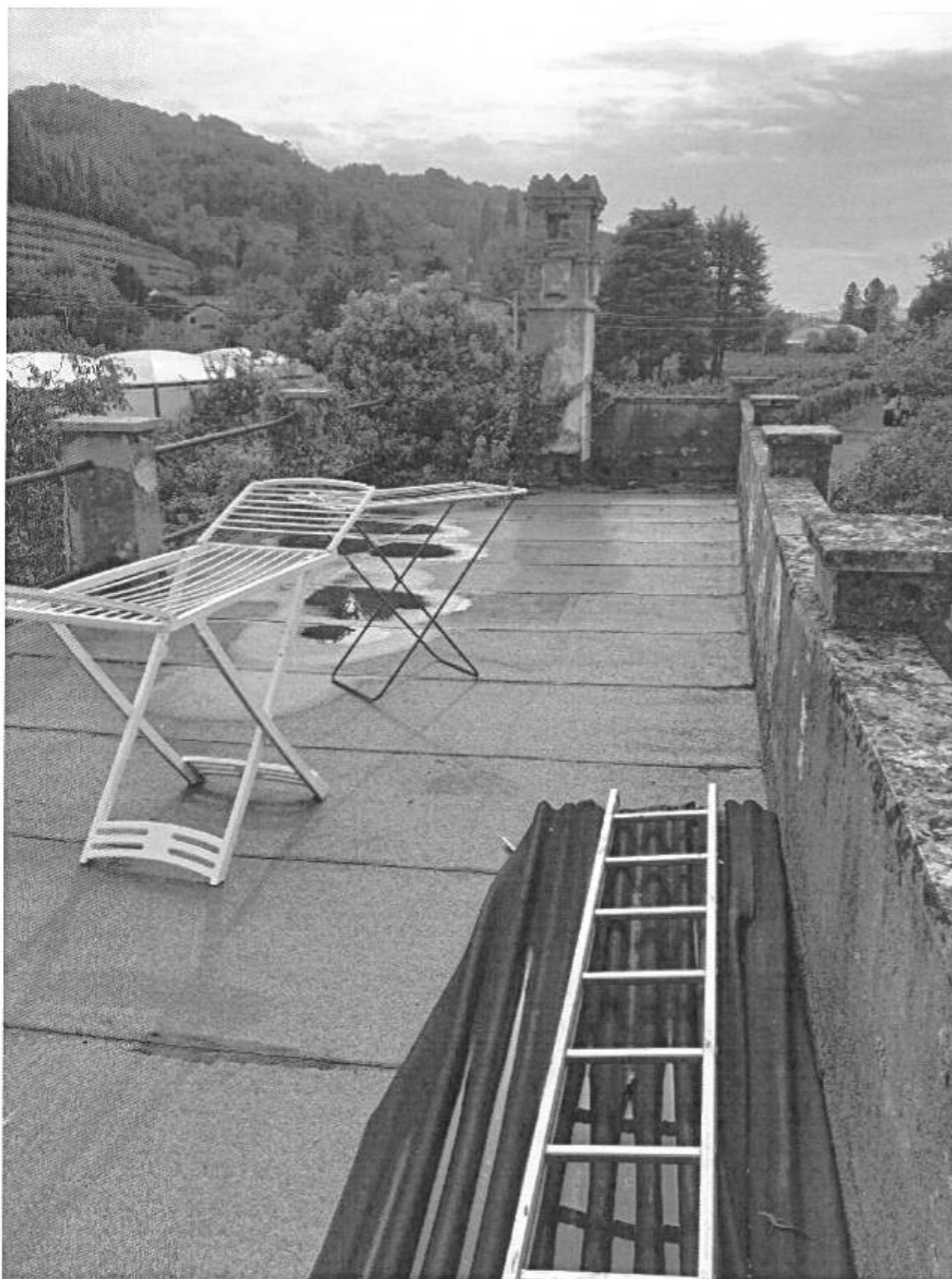
Foto n° 56 - Piano Primo - Terrazza e Torretta Camino della sottostante Sala
