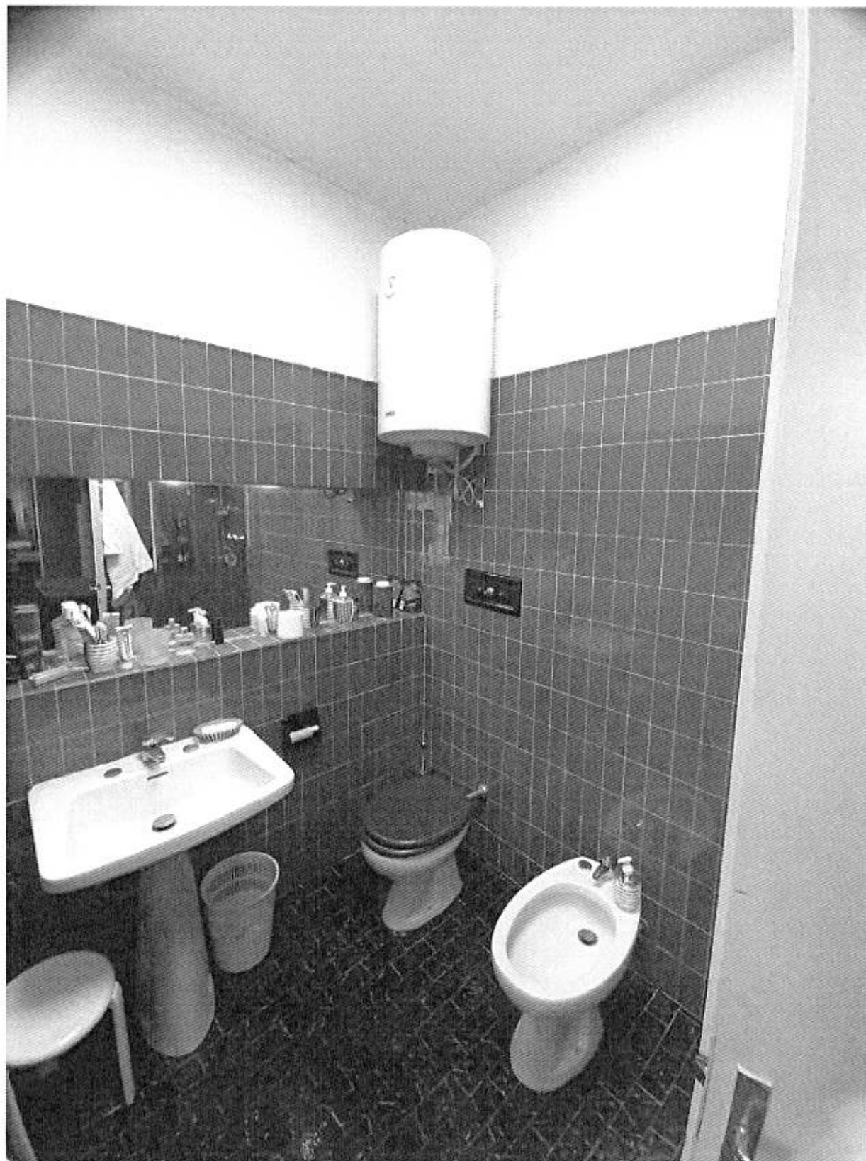
Foto n° 43 - Piano Primo - Bagno W.C. 2
