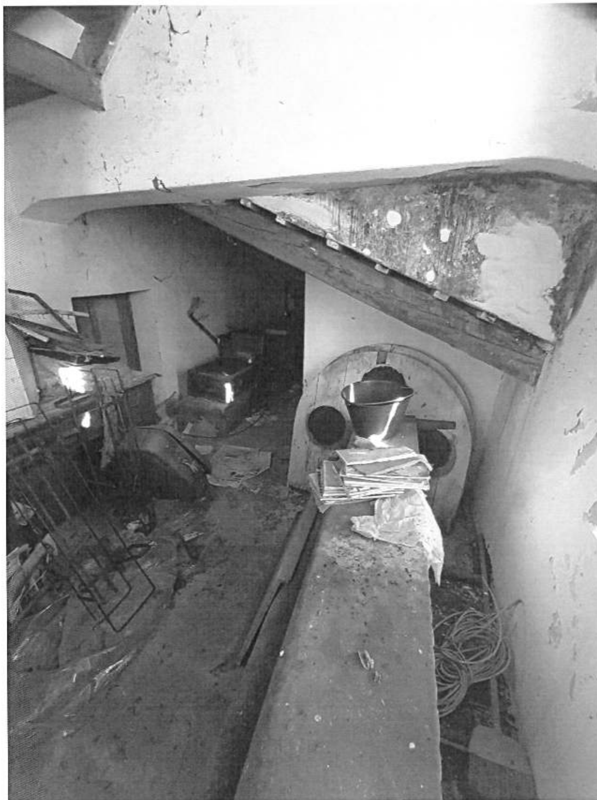
Foto n° 75 - Piano Secondo - Sottotetto visto dal Vano Torre, a sinistra il Cavedio di Accesso al Sottotetto 2
