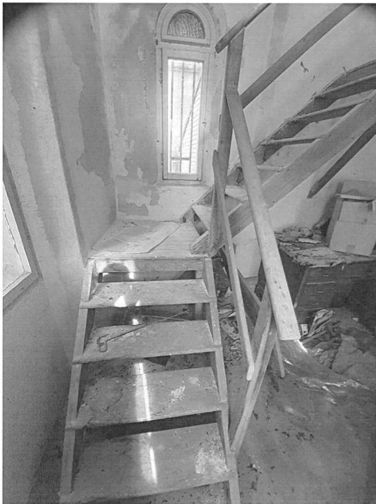
Foto n° 77 - Piano Secondo - Vano Torre
