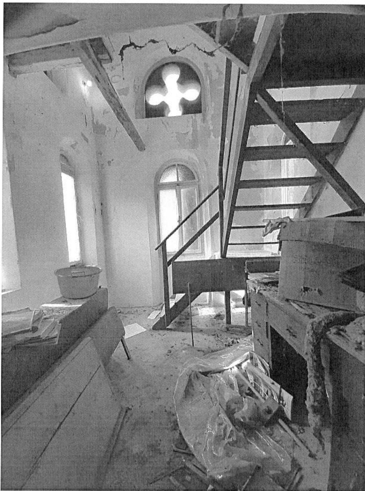
Foto n° 76 - Piano Secondo - Vano Torre
