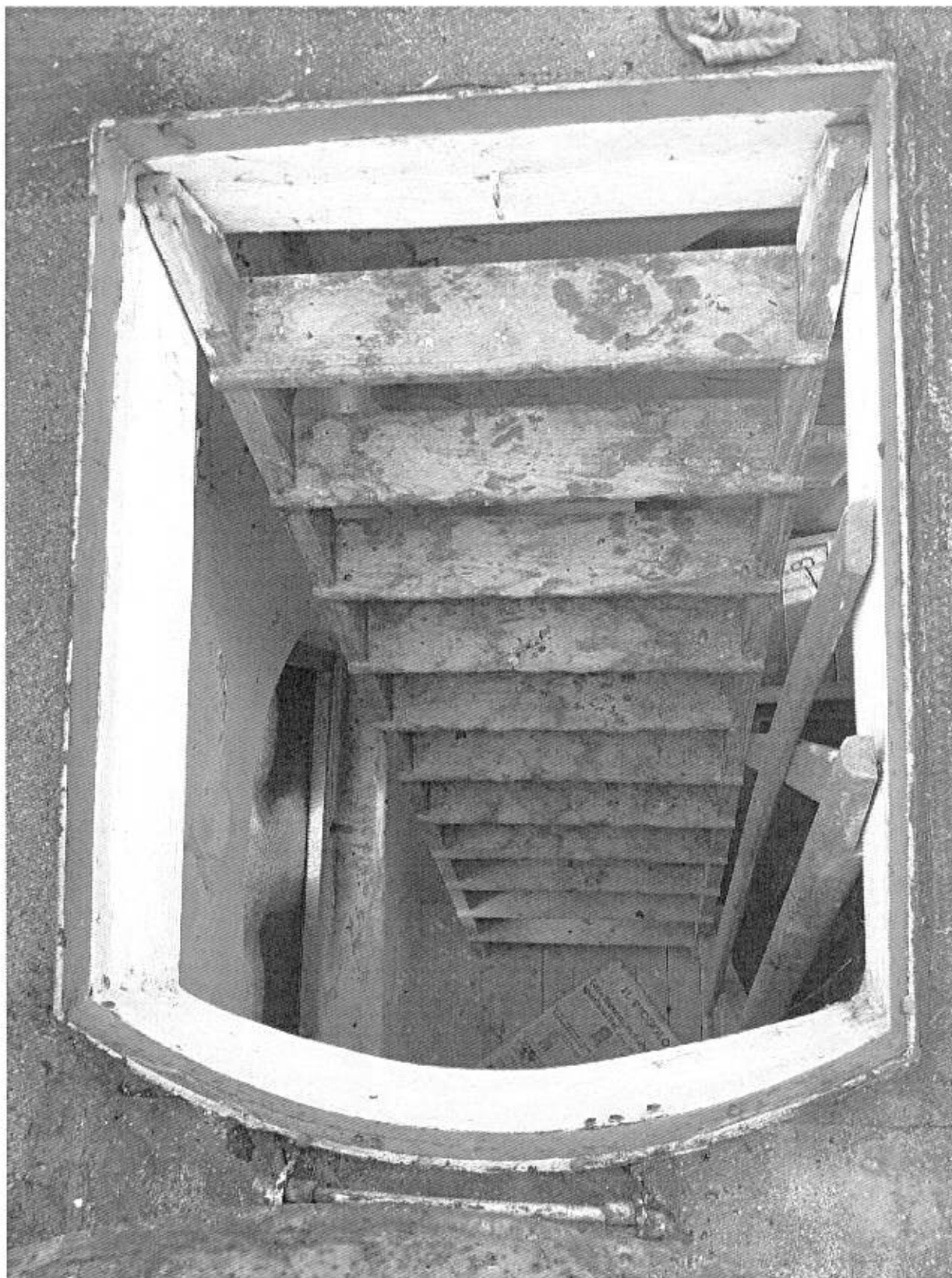
Foto n° 83 - Piano Quarto - Botola e Scaletta di accesso alla Terrazza Panoramica del Piano
