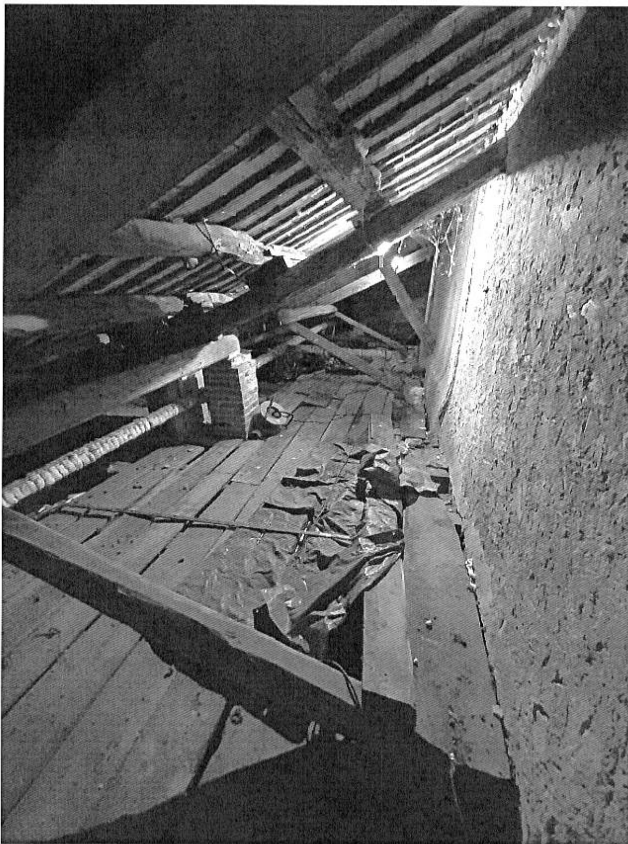
Foto n° 74 - Piano Secondo - Sottotetto 2
