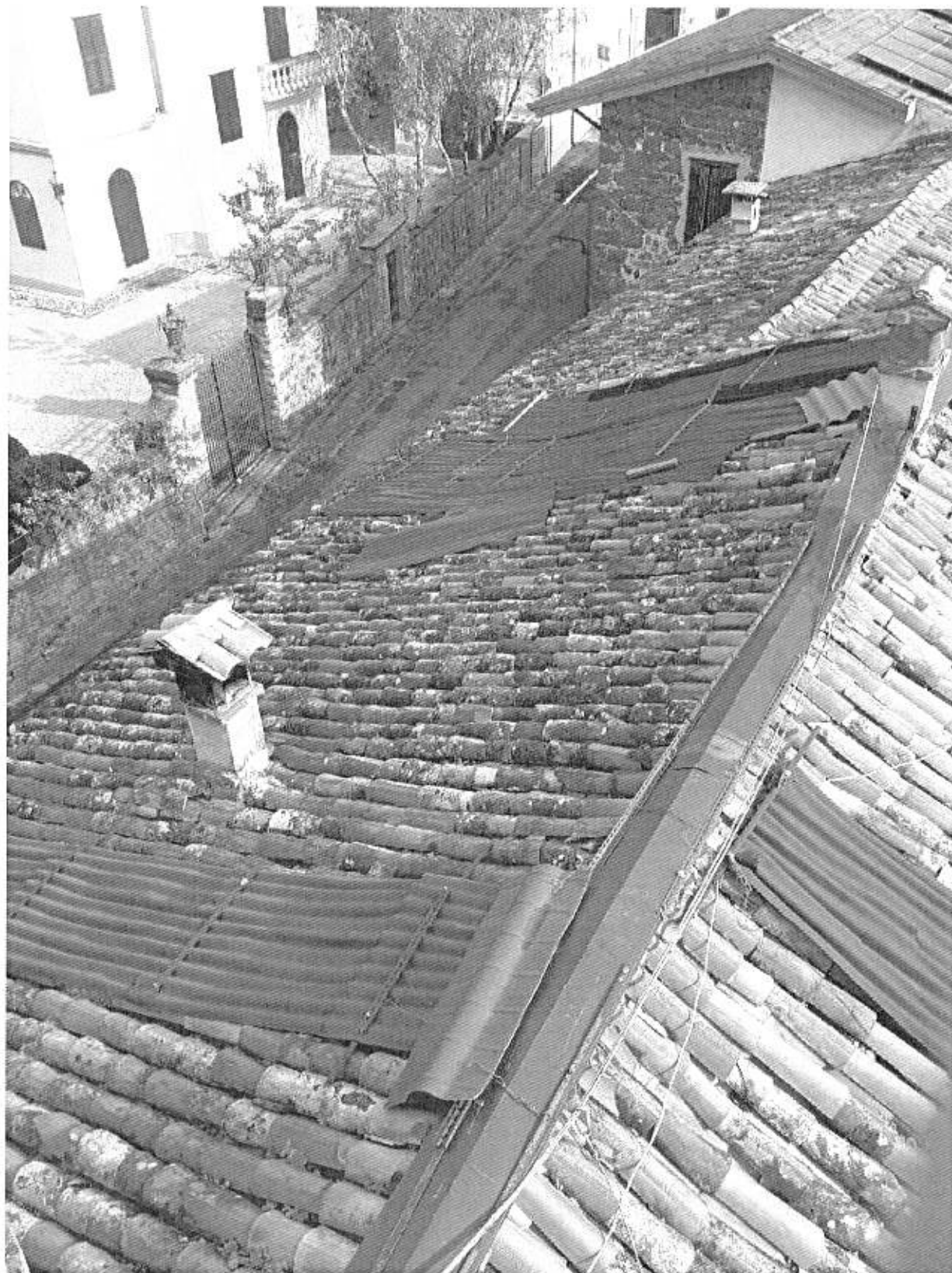
Foto n° 90 - Piano Quarto - vista dalla Terrazza Panoramica delle sottostanti coperture
