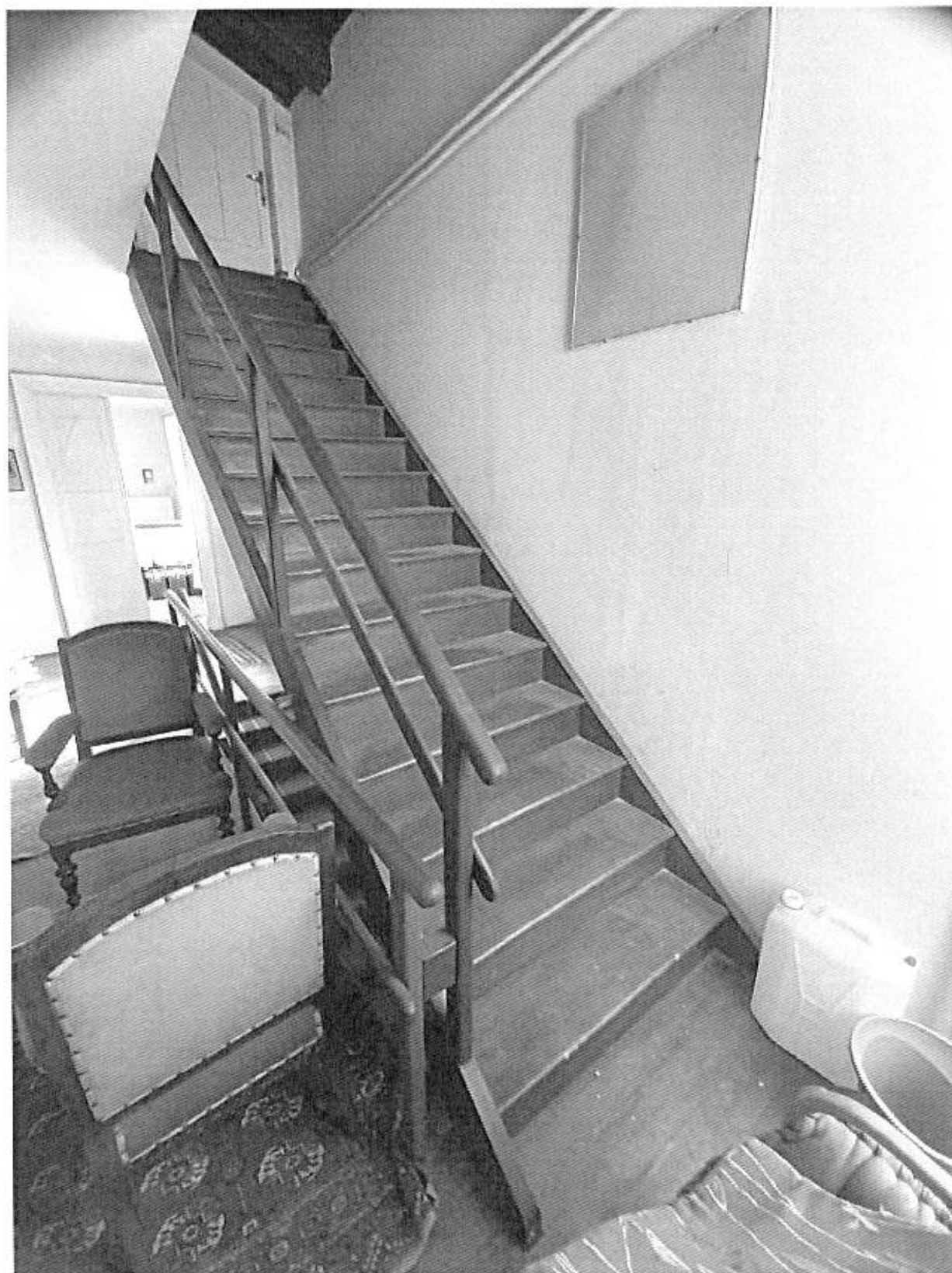
Foto n° 67 - Piano Primo - Scala di accesso al Sottotetto
