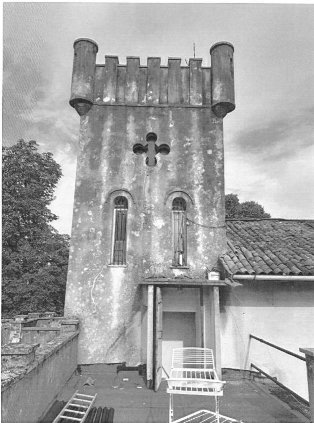
Foto n° 52 - Piano Primo - Arrivo alla Terrazza e vista della Torre Panoramica
