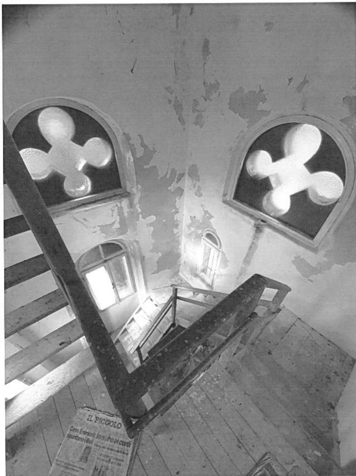
Foto n° 81 - Piano Terzo - sviluppo interno complessivo del Vano Torre (vista sul sottostante Piano Secondo)
