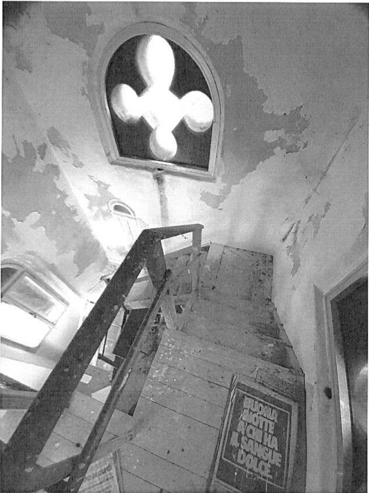
Foto n° 80 - Piano Terzo - sviluppo interno complessivo del Vano Torre (vista sul sottostante Piano Secondo)
