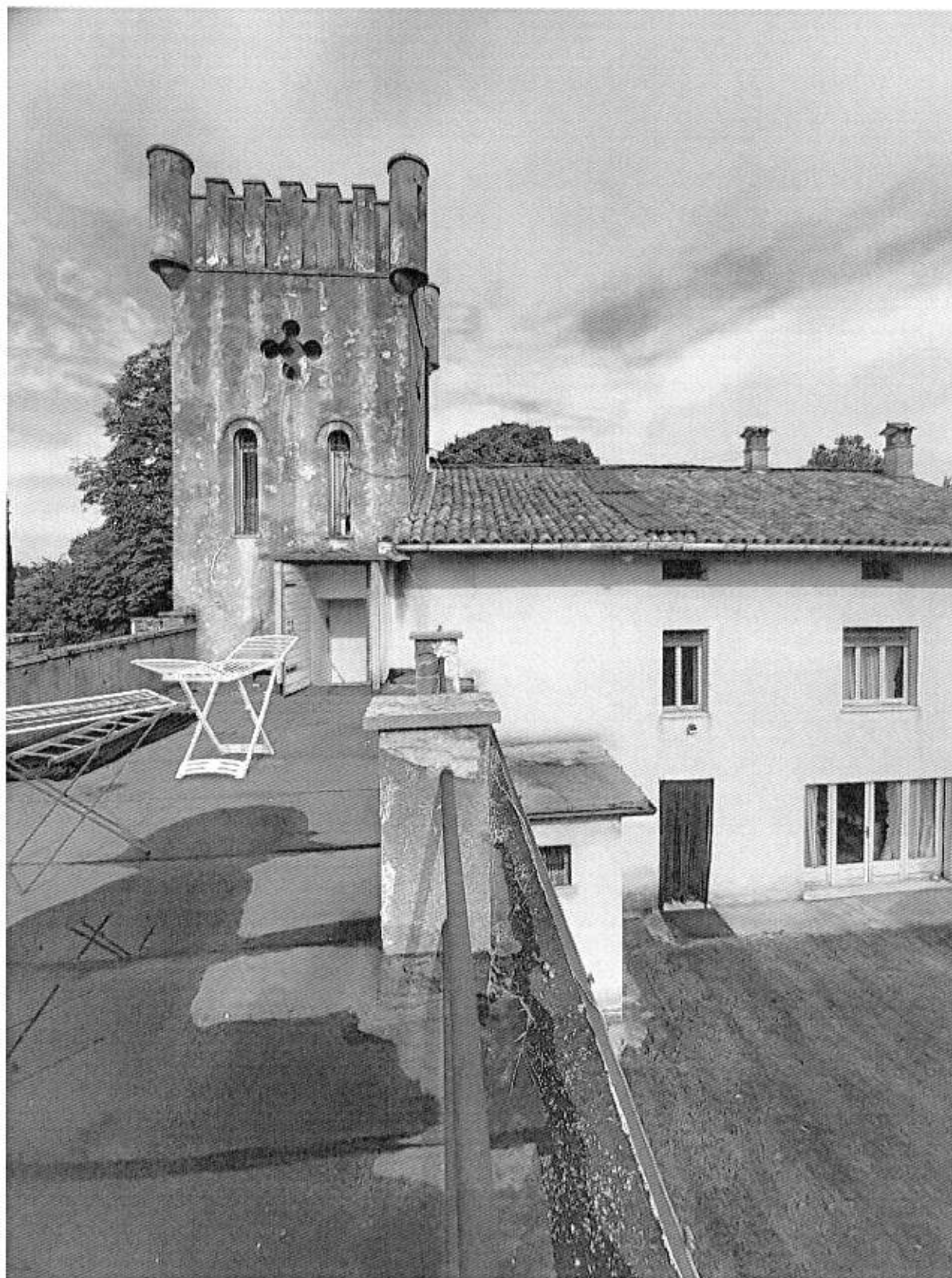
Foto n° 53 - Piano Primo - Terrazza e Torre Panoramica
