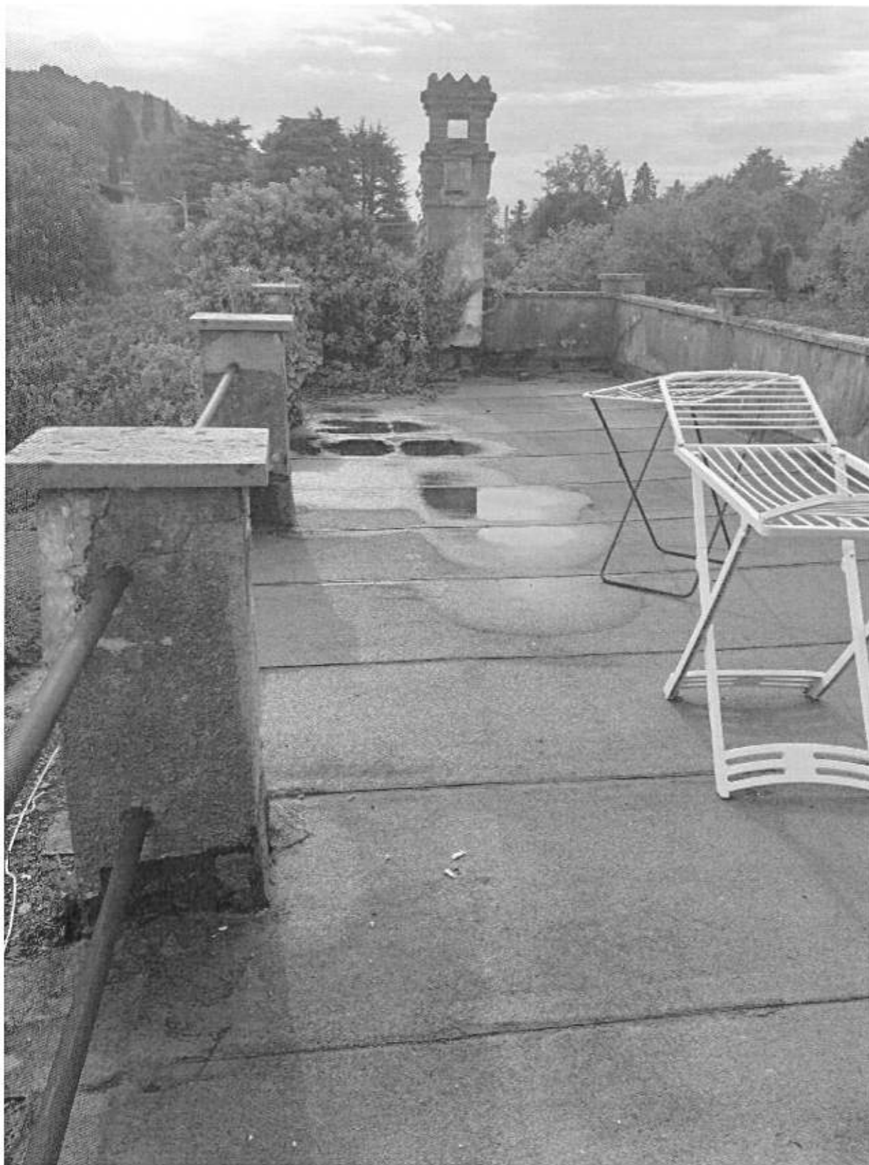
Foto n° 55 - Piano Primo - Terrazza e Torretta Camino della sottostante Sala
