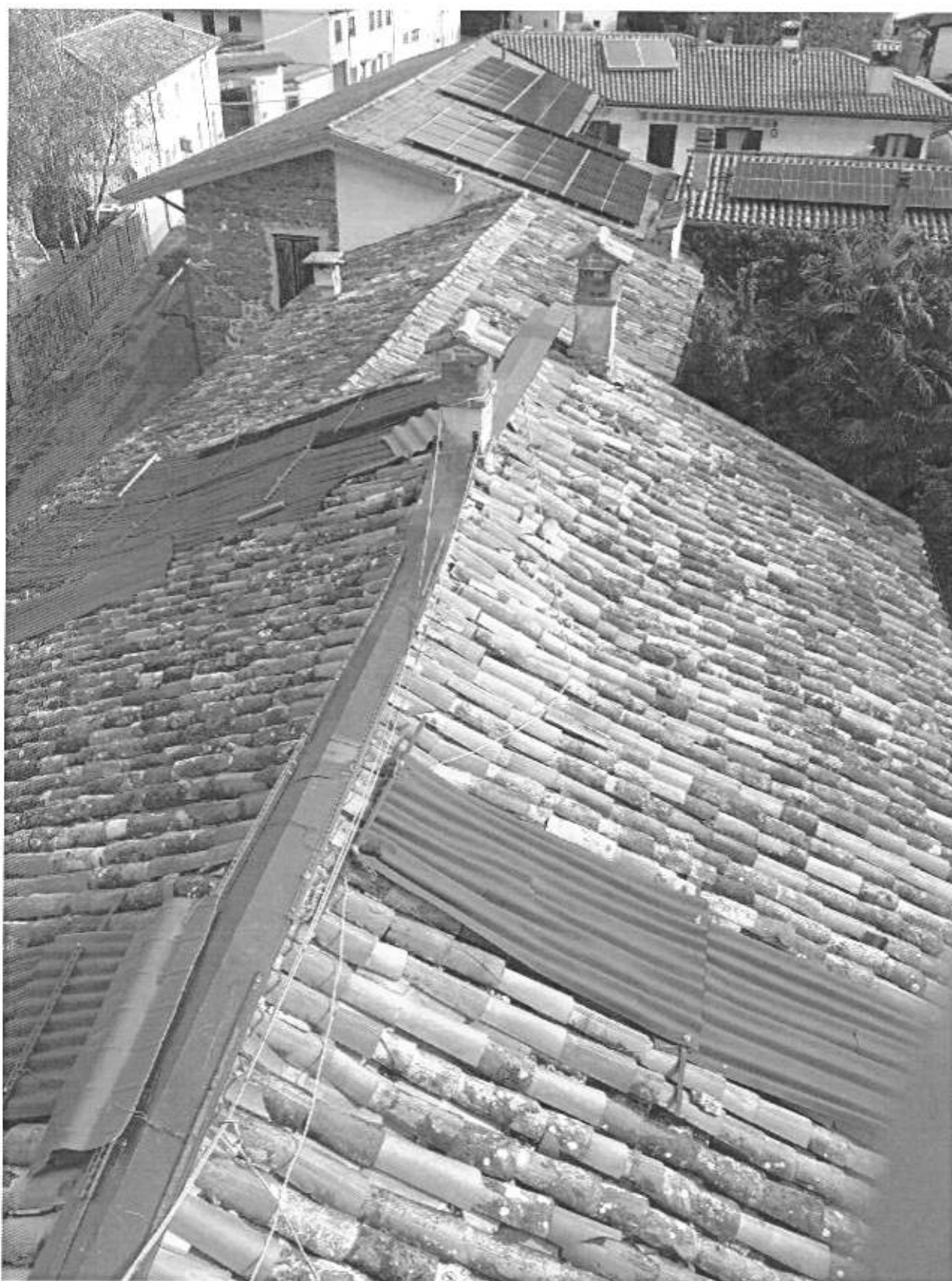
Foto n° 92 - Piano Quarto - vista dalla Terrazza Panoramica delle sottostanti coperture
