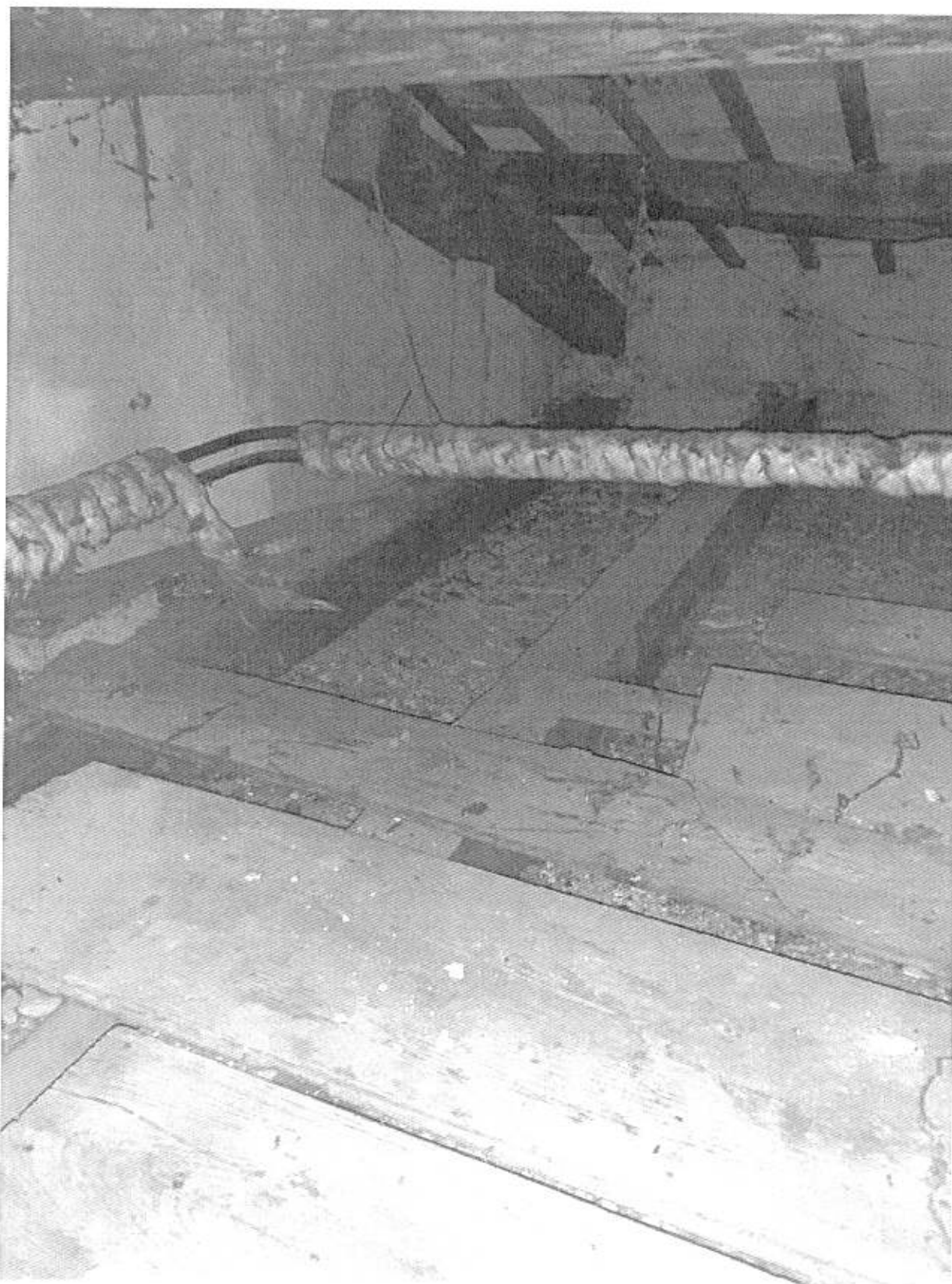
Foto n° 72 - Piano Secondo - Sottotetto 2
