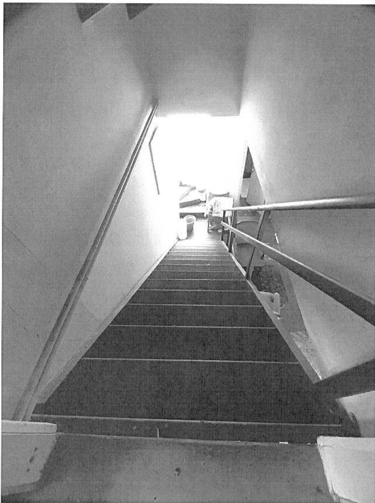
Foto n° 68 - Piano Secondo - Scala di accesso al Sottotetto vista dallo stesso
