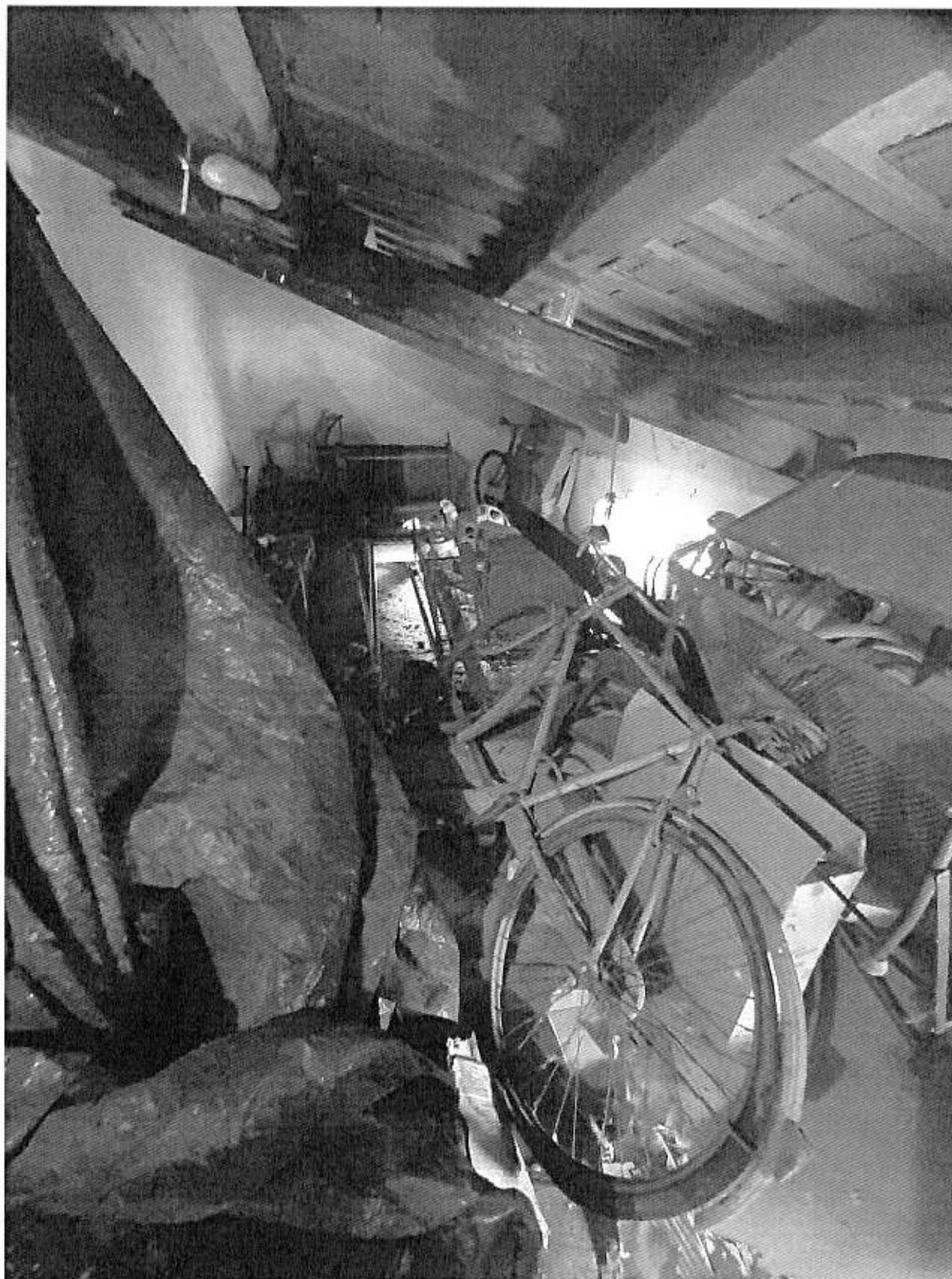
Foto n° 69 - Piano Secondo - Sottotetto
