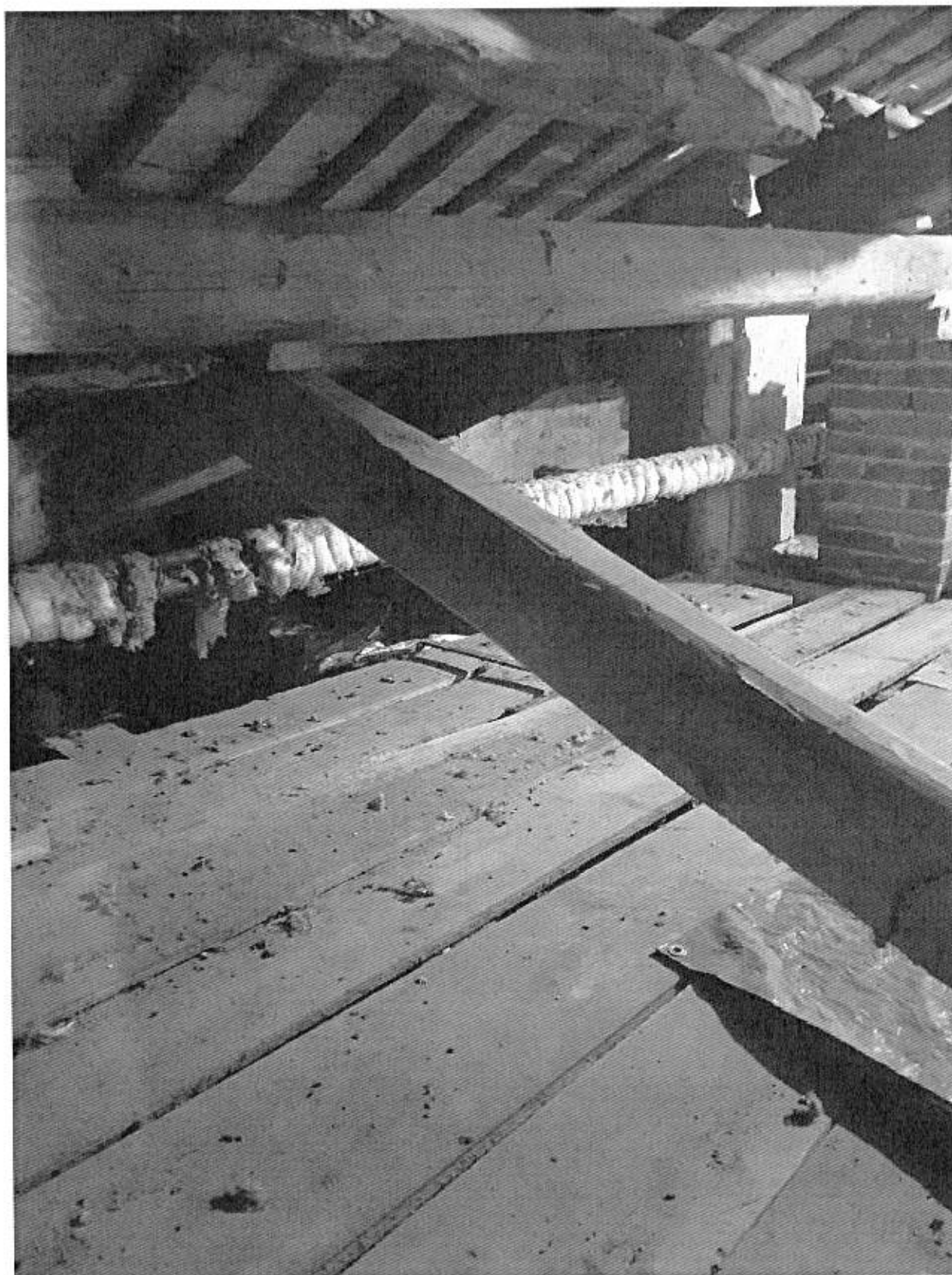
Foto n° 73 - Piano Secondo - Sottotetto 2
