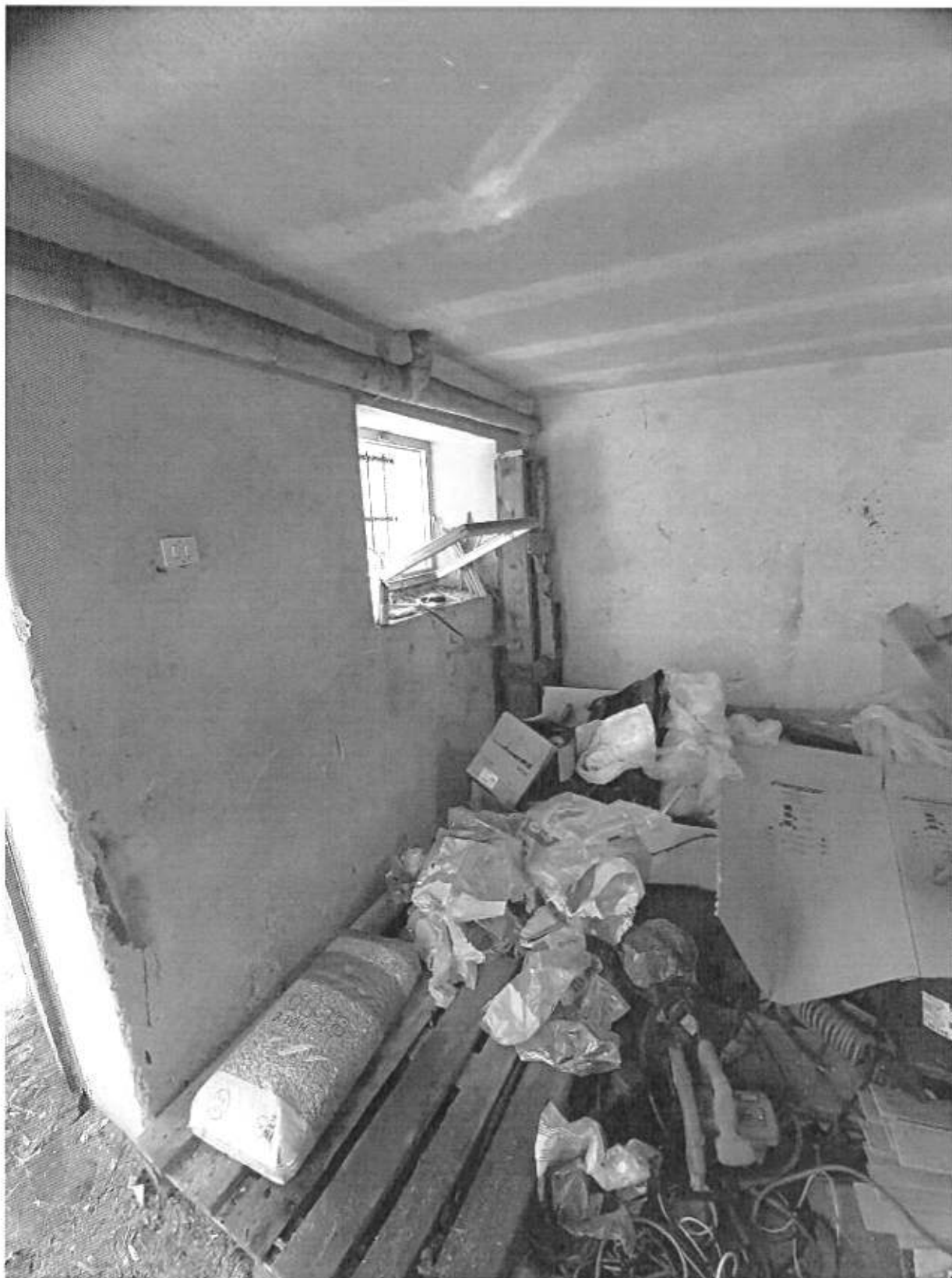
Foto n° 95 - Piano Terra - Locale di Sgombero
