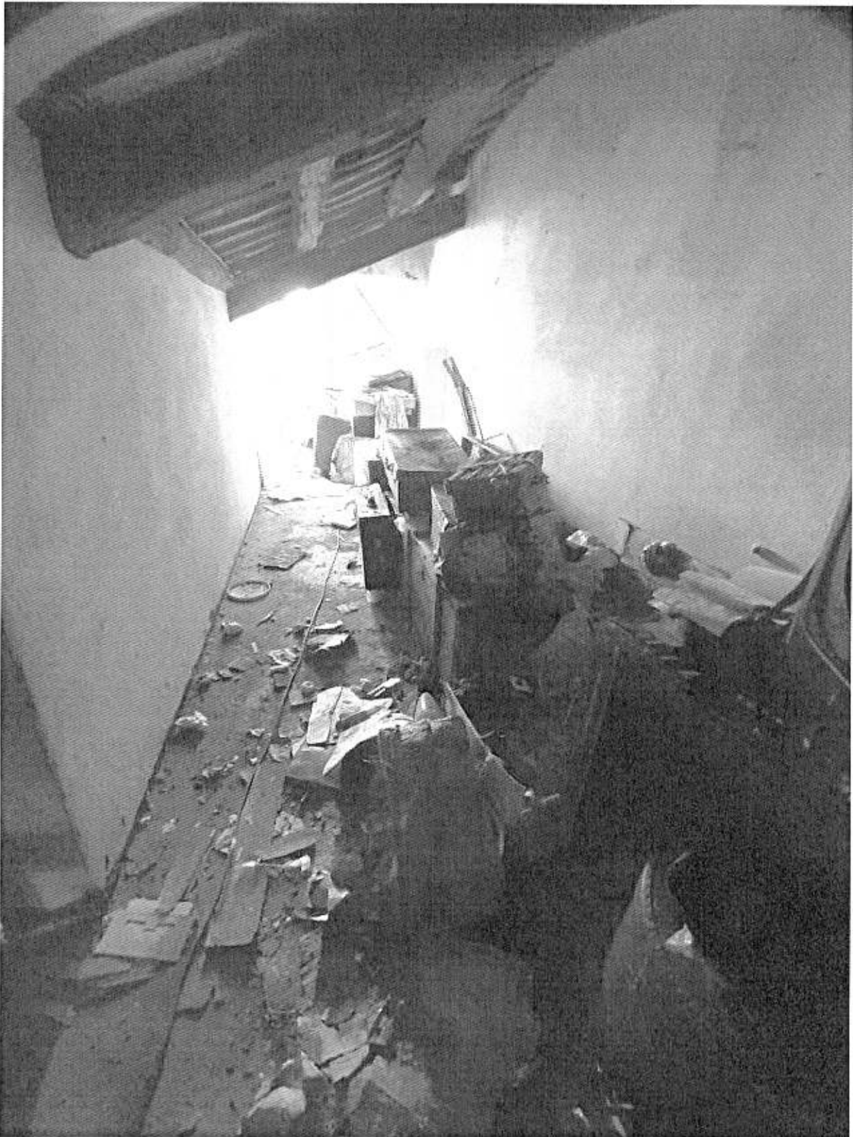
Foto n° 70 - Piano Secondo - Sottotetto e sullo sfondo il Vano Torre
