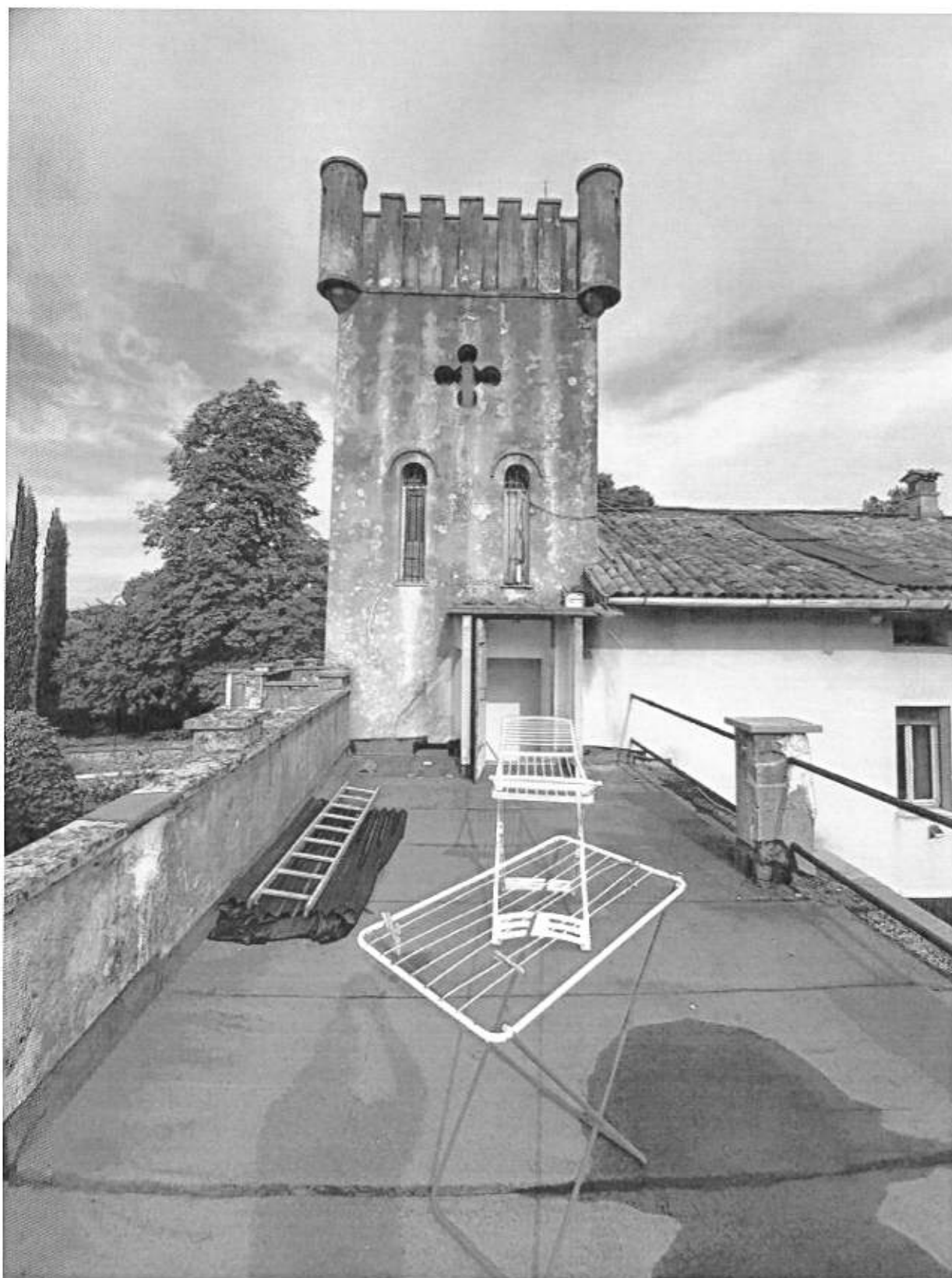
Foto n° 54 - Piano Primo - Terrazza e Torre Panoramica
