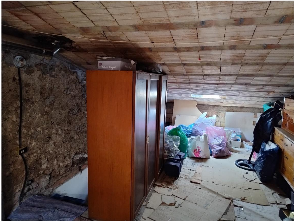
Sottotetto lato scala P3 (foto del 03/04/2025)
