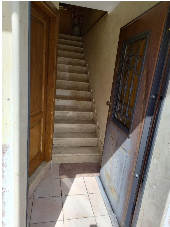
Ingresso Via Aquila n.122 (foto del 03/04/2025)
