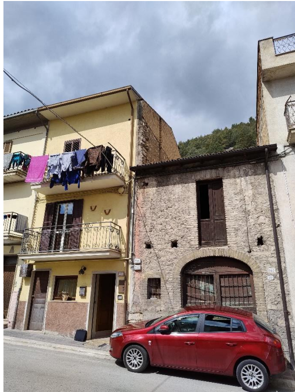
Prospetto su Via Aquila (foto del 03/04/2025)
