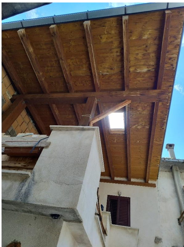
Struttura di copertura in legno del terrazzo da rimuovere (foto del 03/04/2025)
