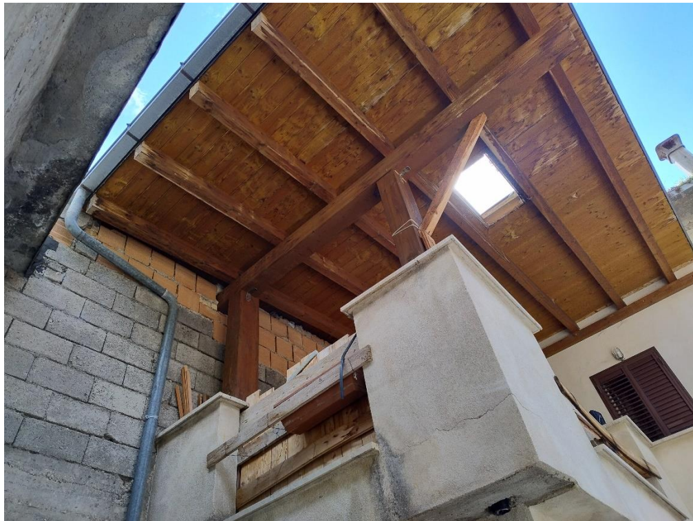
Struttura di copertura in legno del terrazzo da rimuovere (foto del 03/04/2025)
