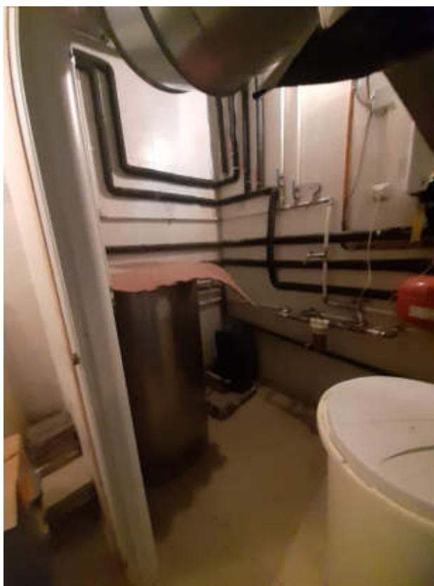
Vista interna tipoloe e dotazioni servizi igienici
