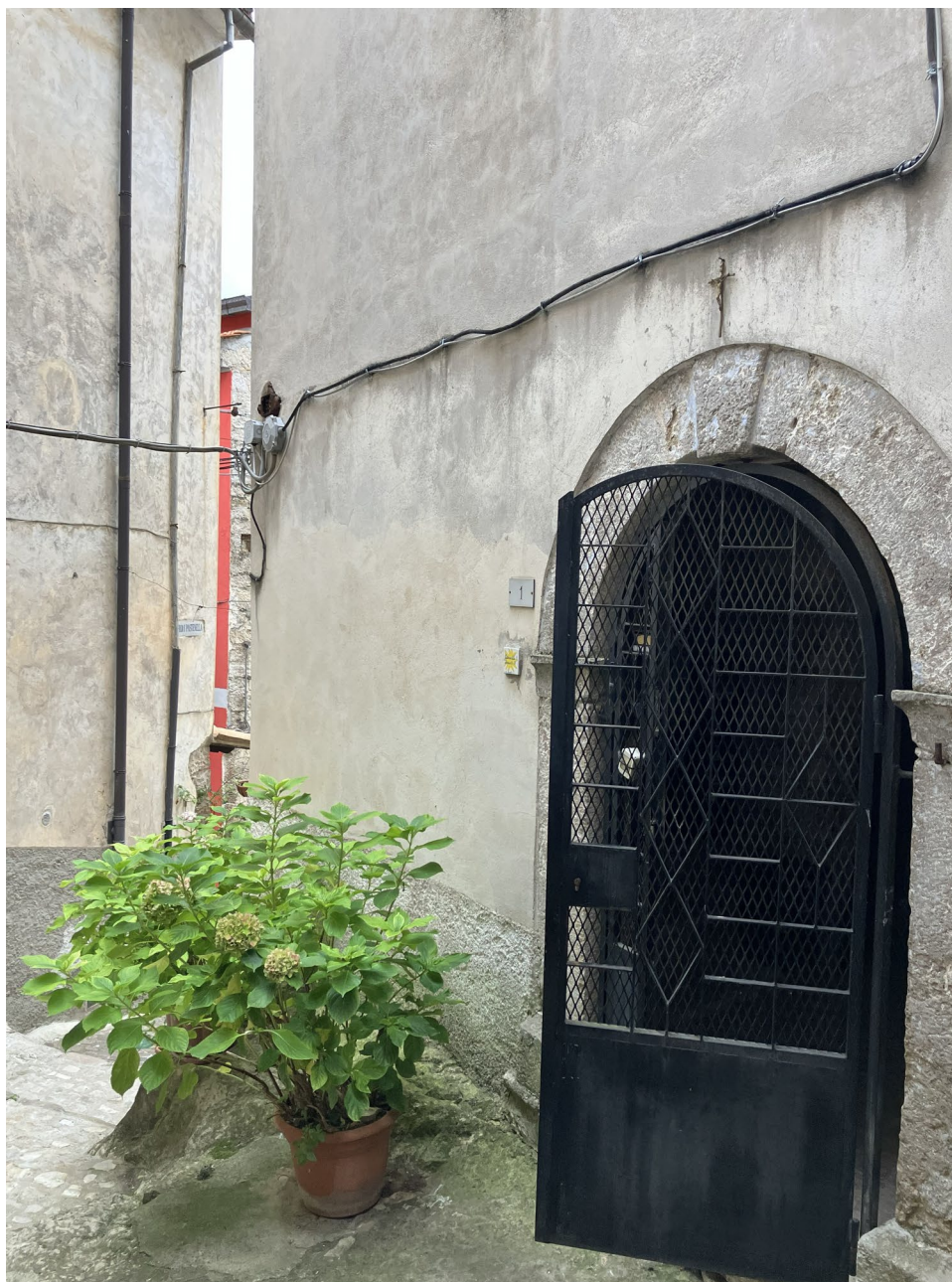
VISTA DEL CANCELLO D'INGRESSO AL PIANO TERRA SU VICO PRIMO PASTANELLA
