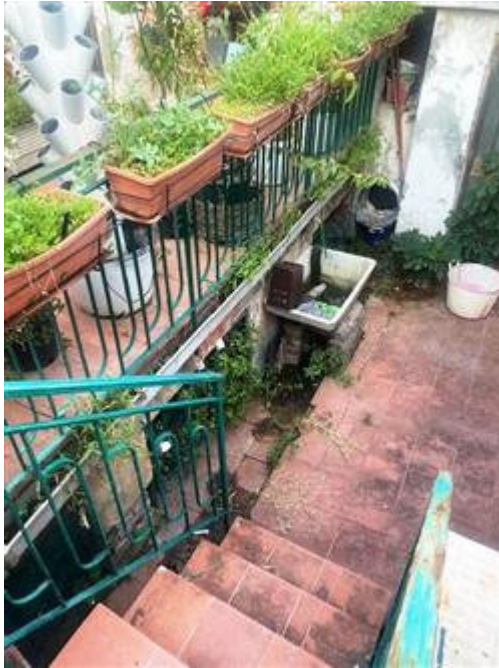
Corte antistante il magazzino sub. 7 sita al P.T.
