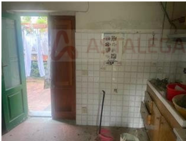
Vano 3 sub. 7 P.T. adibito a cucina in disuso
