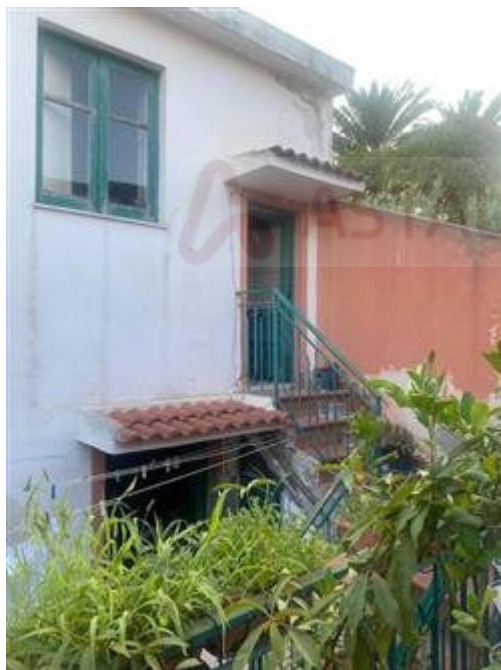
Sub 7_Deposito - ingresso P.1
