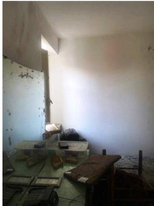
Vano 2 sub. 7 P.1 adibito a magazzino
