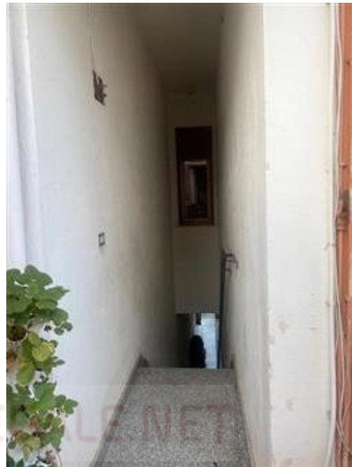
Vano scala di collegamento al P.1
