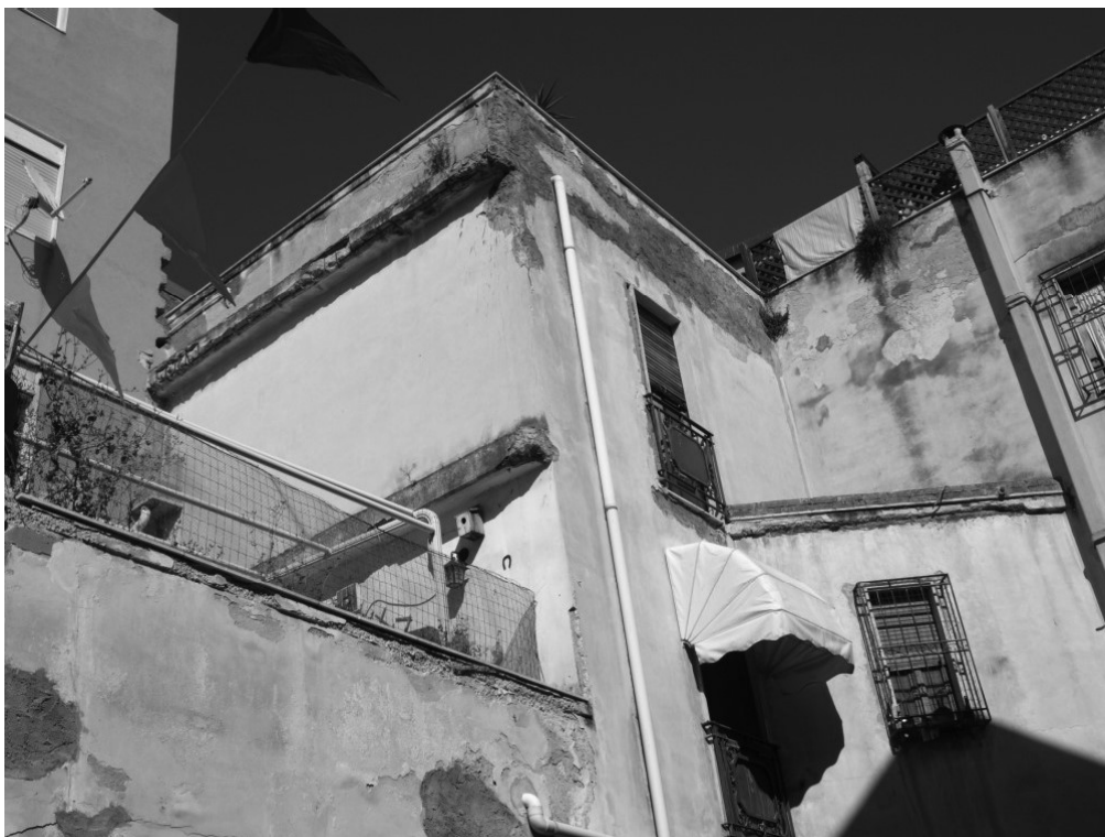
Foto n° 4 – Appartamento in Gela nel vicolo Giardinelli n° 28, foglio 253, part. 339 sub 11, graffate part. 340 sub 9 e part. 341 sub 10 – Panoramica del prospetto su corte privata (lato ovest).
