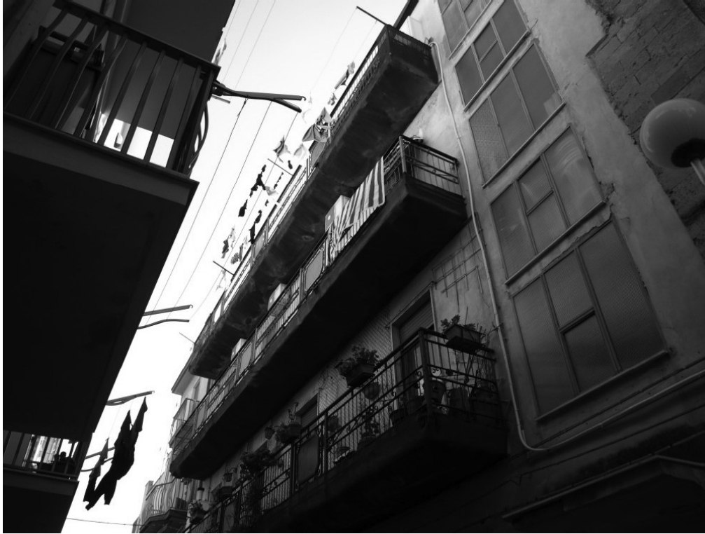
Foto n° 1 – Appartamento in Gela nel vicolo Giardinelli n° 28, foglio 253, part. 339 sub 11, graffate part. 340 sub 9 e part. 341 sub 10 – Panoramica del prospetto principale su vicolo Giardinelli.
