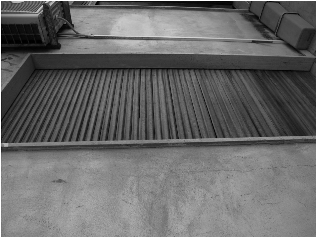
Foto n° 9 – Appartamento in Gela nel vicolo Giardinelli n° 28, foglio 253, part. 339 sub 11, graffate part. 340 sub 9 e part. 341 sub 10 – Panoramica degli interni del 2° piano (infisso esterno).
