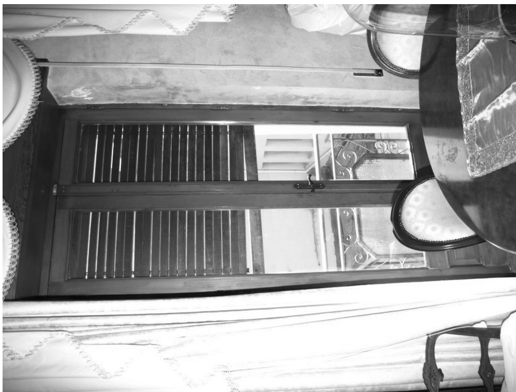
Foto n° 8 – Appartamento in Gela nel vicolo Giardinelli n° 28, foglio 253, part. 339 sub 11, graffate part. 340 sub 9 e part. 341 sub 10 – Panoramica degli interni del 2° piano (infisso interno).
