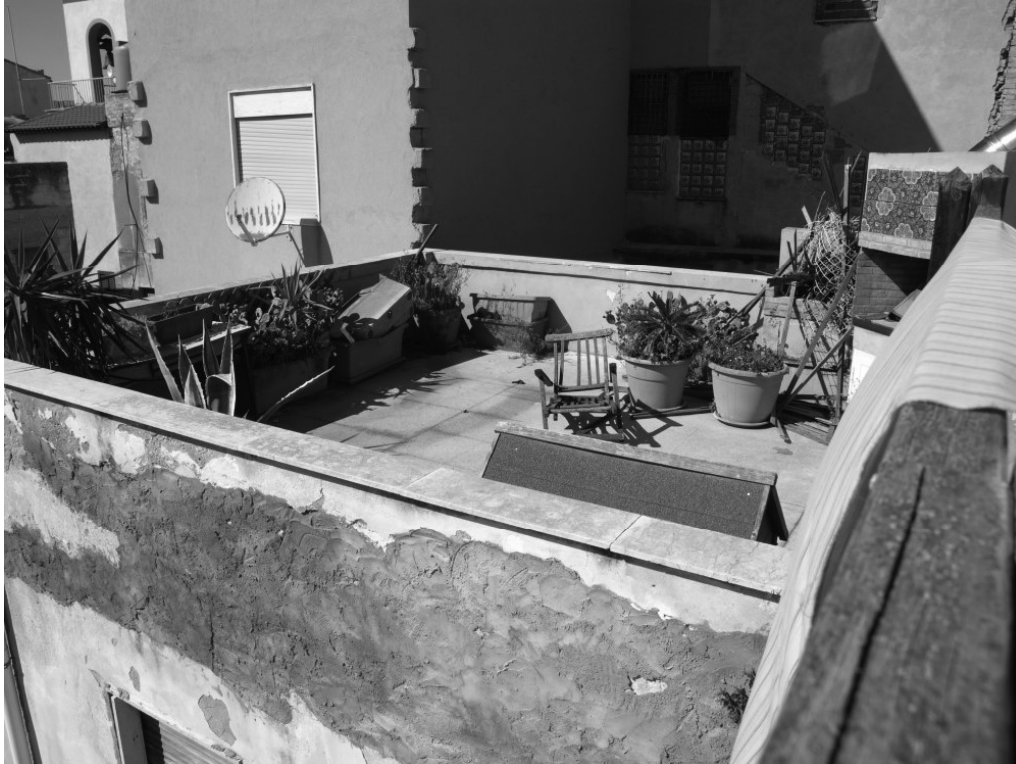
Foto n° 33 – Appartamento in Gela nel vicolo Giardinelli n° 28, foglio 253, part. 339 sub 11, graffate part. 340 sub 9 e part. 341 sub 10 – Panoramica degli esterni del 3° piano (veranda ad ovest).
