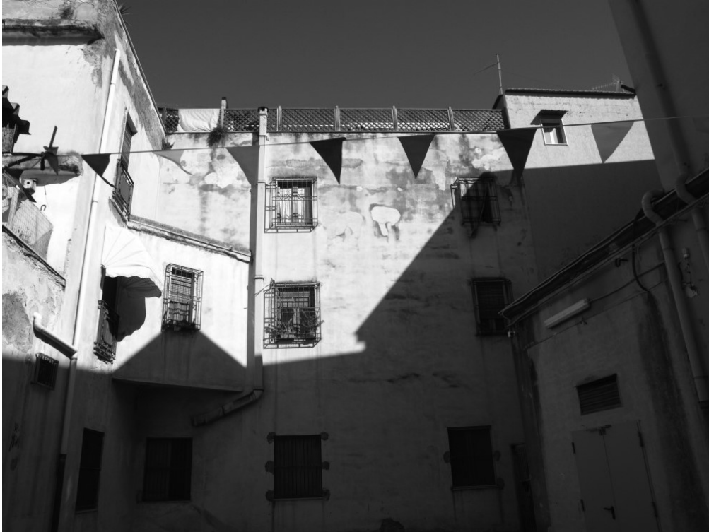
Foto n° 3 – Appartamento in Gela nel vicolo Giardinelli n° 28, foglio 253, part. 339 sub 11, graffate part. 340 sub 9 e part. 341 sub 10 – Panoramica del prospetto su corte privata (lato ovest).
