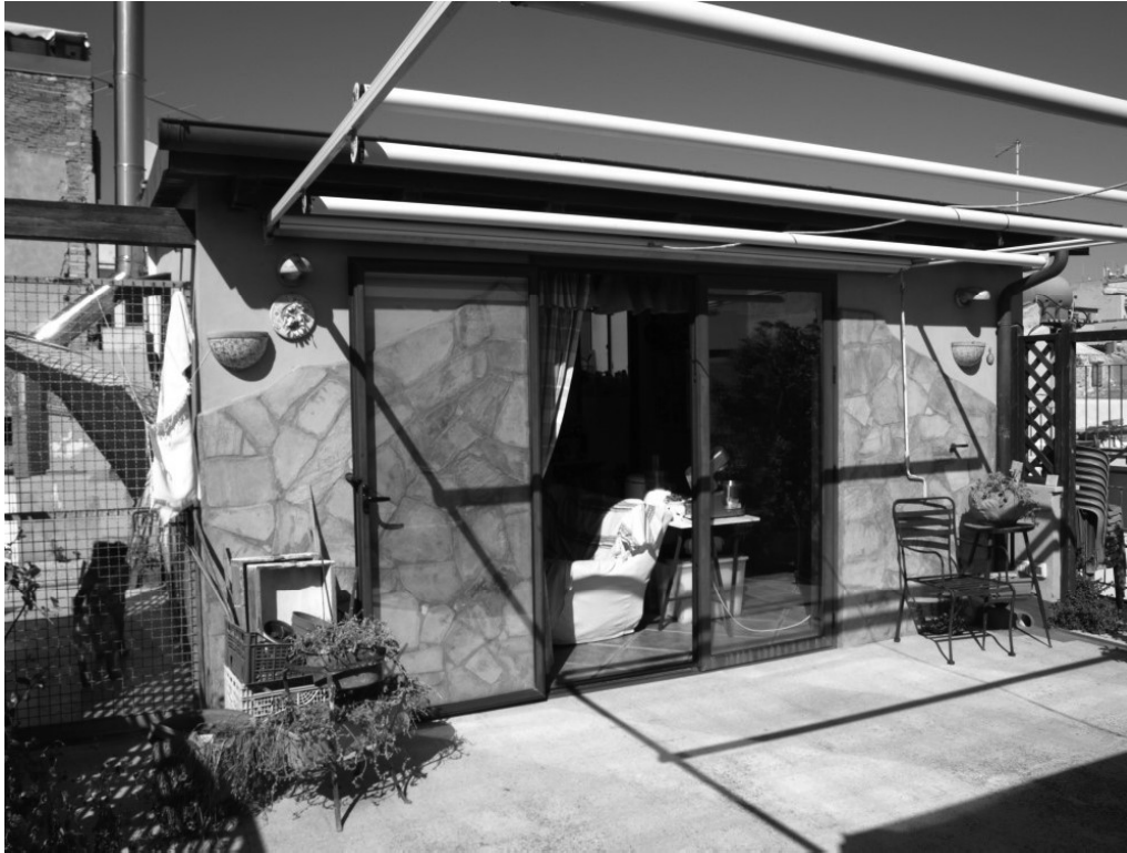
Foto n° 35 – Appartamento in Gela nel vicolo Giardinelli n° 28, foglio 253, part. 339 sub 11, graffate part. 340 sub 9 e part. 341 sub 10 – Panoramica degli esterni del 3° piano (veranda).
