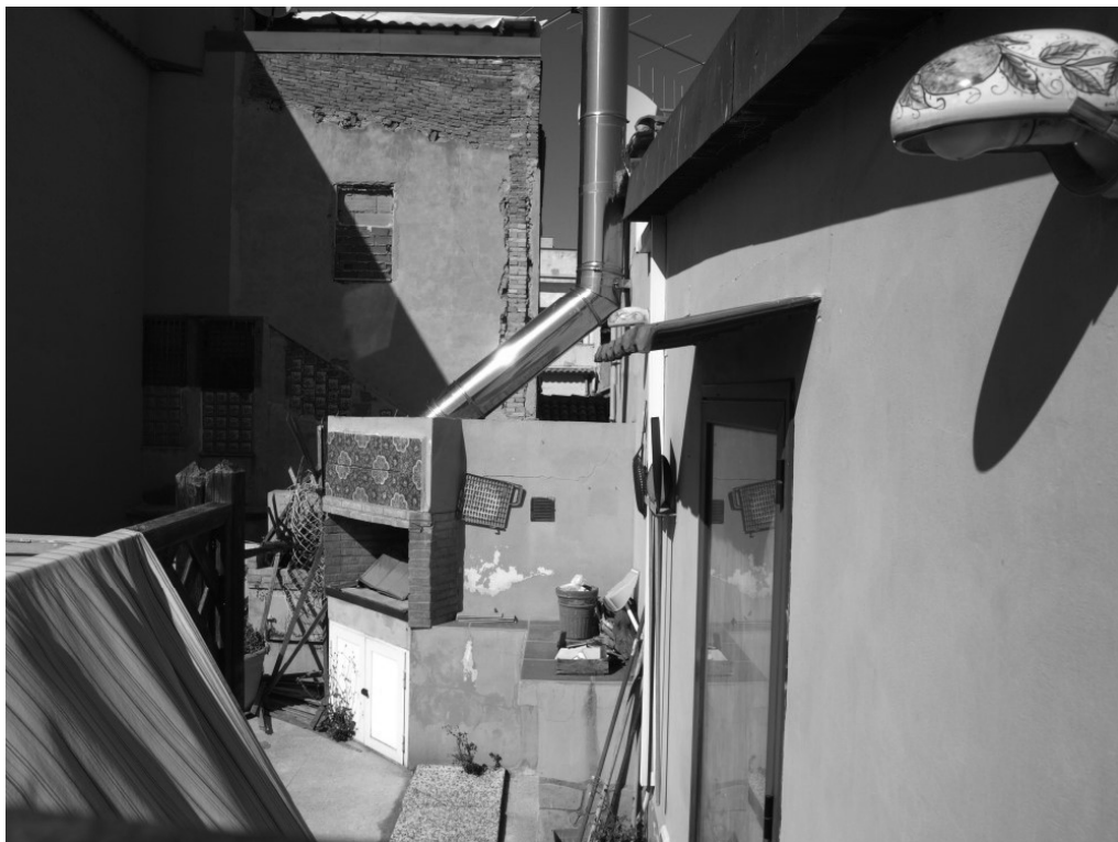
Foto n° 34 – Appartamento in Gela nel vicolo Giardinelli n° 28, foglio 253, part. 339 sub 11, graffate part. 340 sub 9 e part. 341 sub 10 – Panoramica degli esterni del 3° piano (veranda ad ovest).
