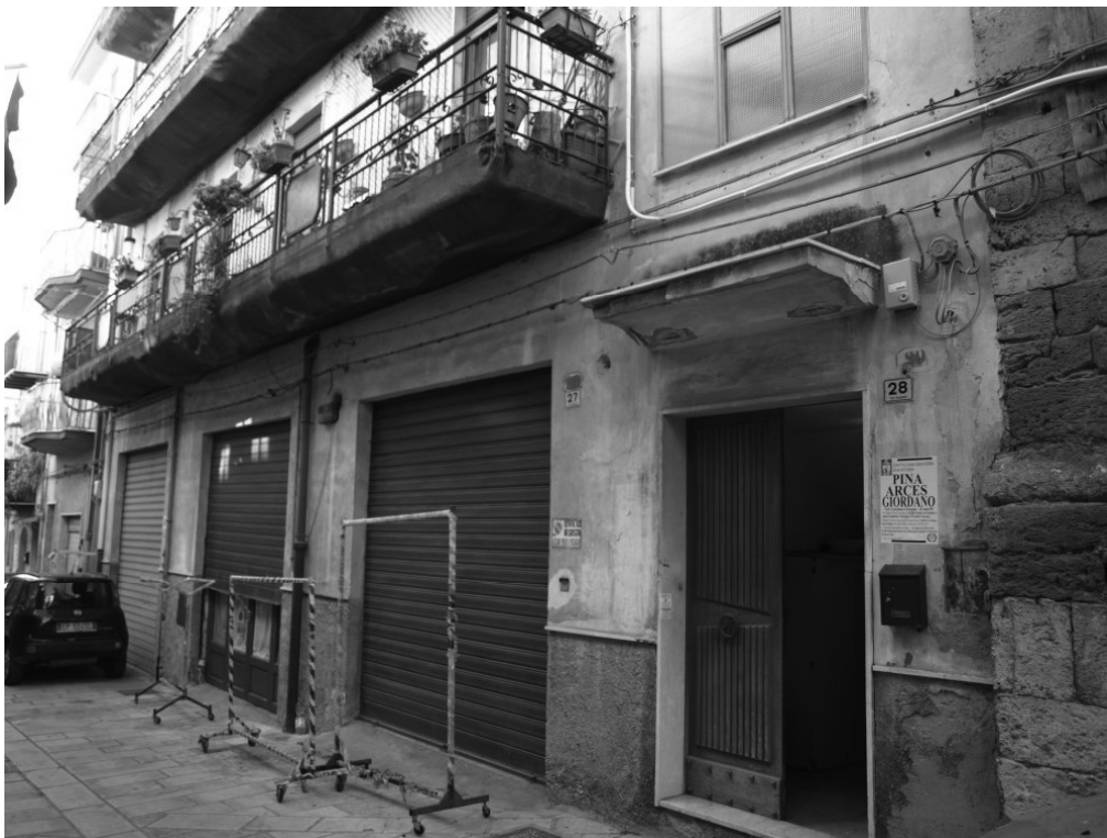
Foto n° 2 – Appartamento in Gela nel vicolo Giardinelli n° 28, foglio 253, part. 339 sub 11, graffate part. 340 sub 9 e part. 341 sub 10 – Panoramica del prospetto principale su vicolo Giardinelli.
