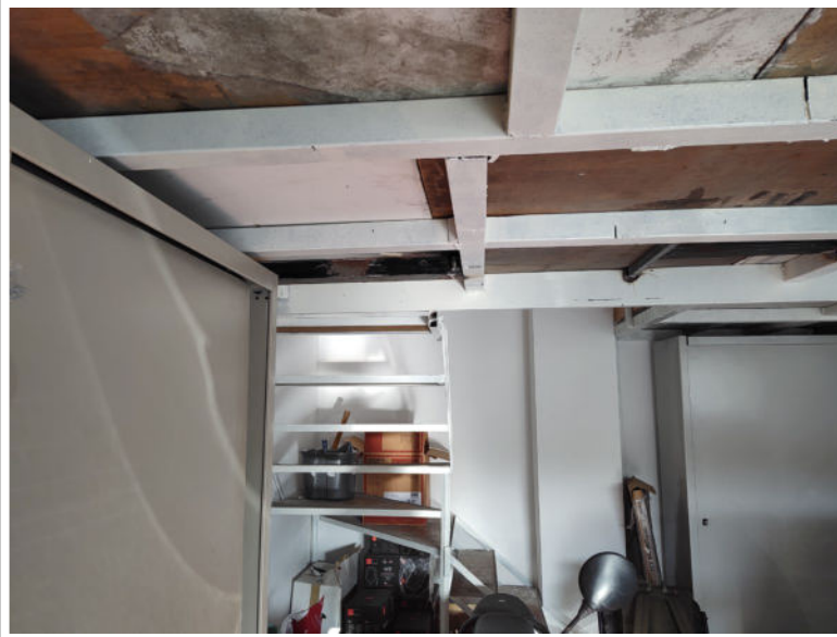
Foto n. 16 – Scala accesso soppalco garage
