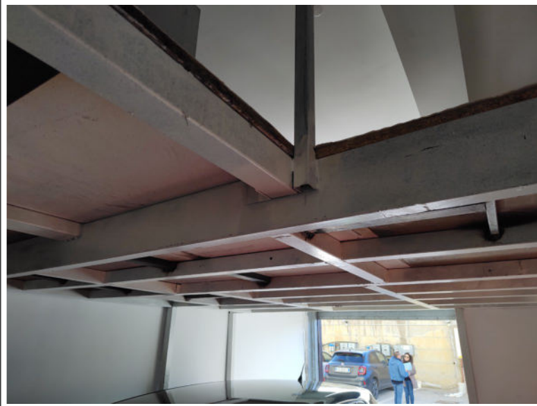
Foto n. 15 – Struttura soppalco garage
