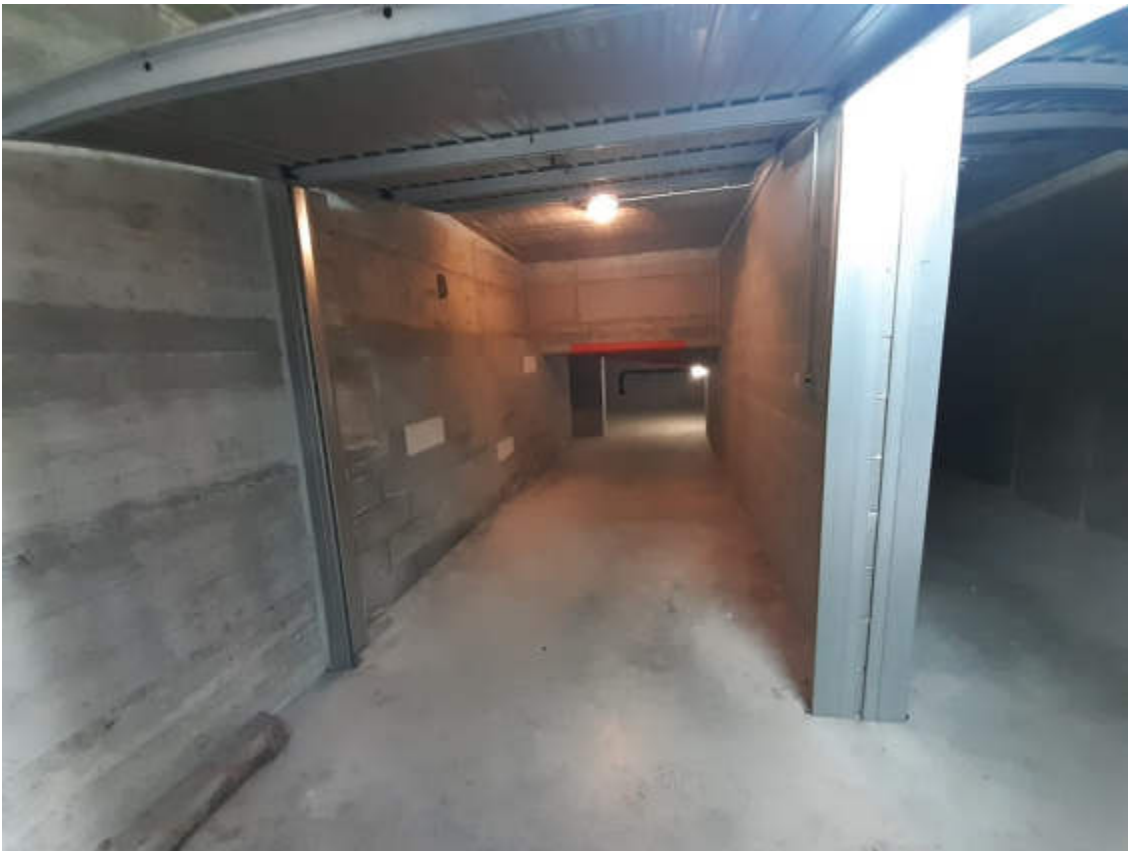
Vista interna della U.I.U. oggetto di valutazione
