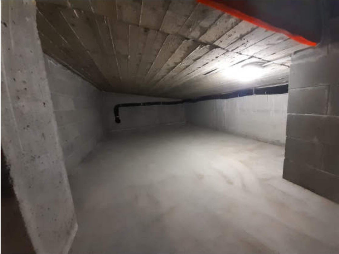
Vista interna della U.I.U. oggetto di valutazione
