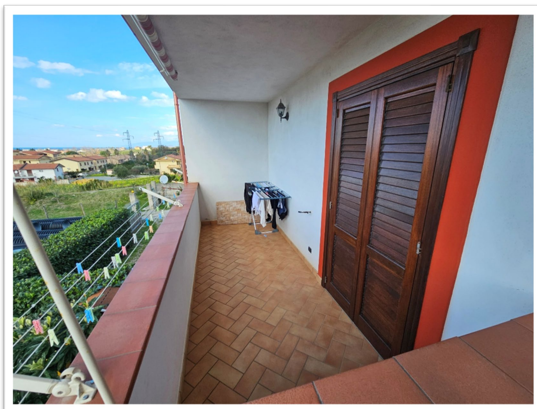
Foto 14 –Particolare balcone lato Ovest a servizio del vano disimpegno piano primo
