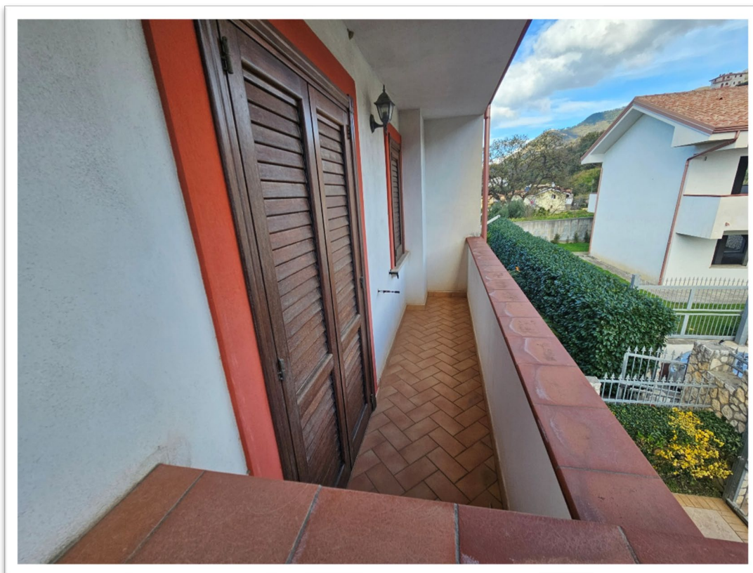
Foto 15 –Particolare balcone lato Est a servizio del vano disimpegno piano primo
