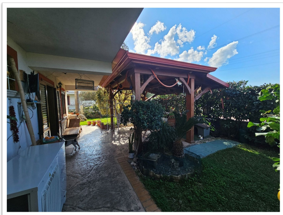
Foto 24 – Vista Ovest giardino con gazebo in legno lamellare abusivo
