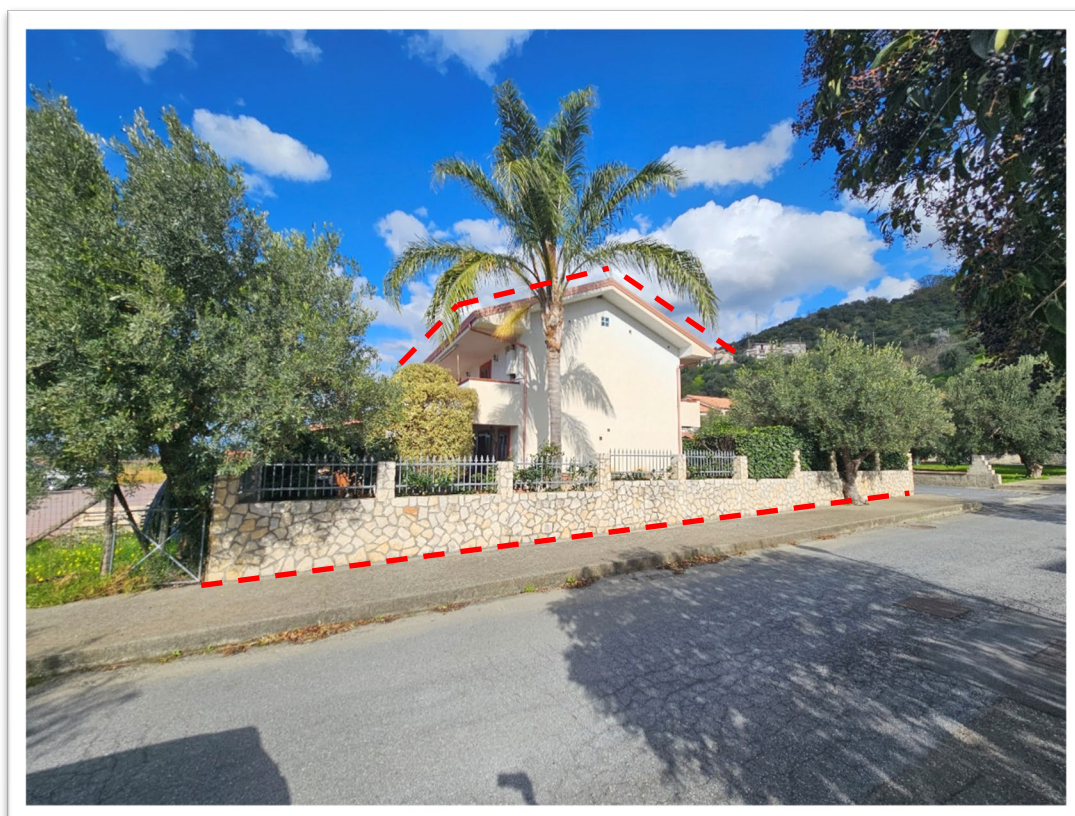
Foto 2 - Vista prospetto Sud/Ovest - Indicazione immobile - - - -
