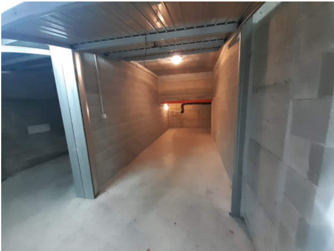
Vista interna della U.I.U. oggetto di valutazione
