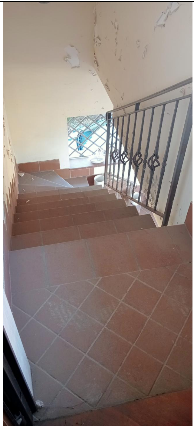
SCALA DI ACCESSO
