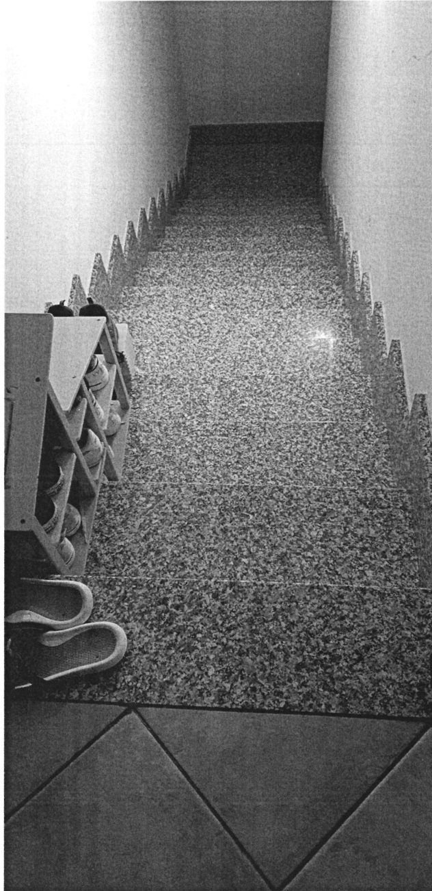
Scala di accesso al piano seminterrato
