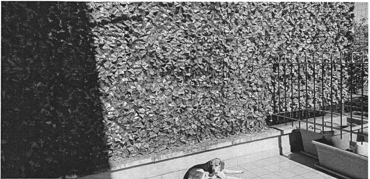
Recinzione lato cortile interno a confine con altra proprietà
