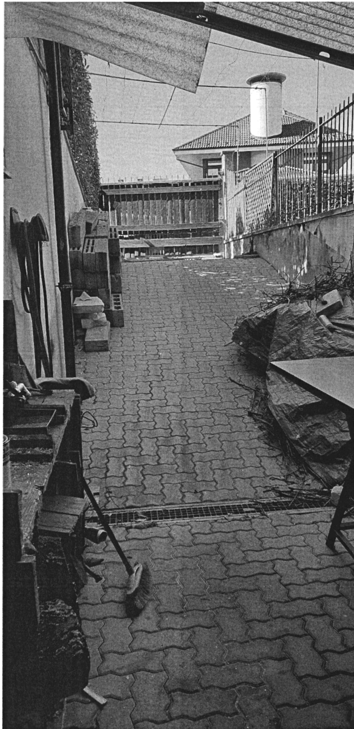
Rampa di accesso all'autorimessa
