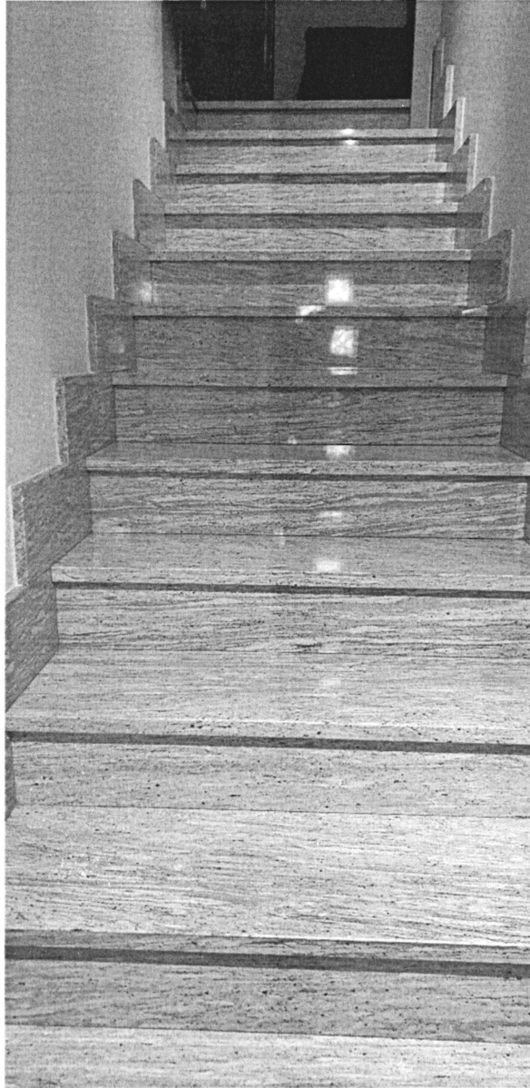
Scala di accesso al secondo piano fuori terra
