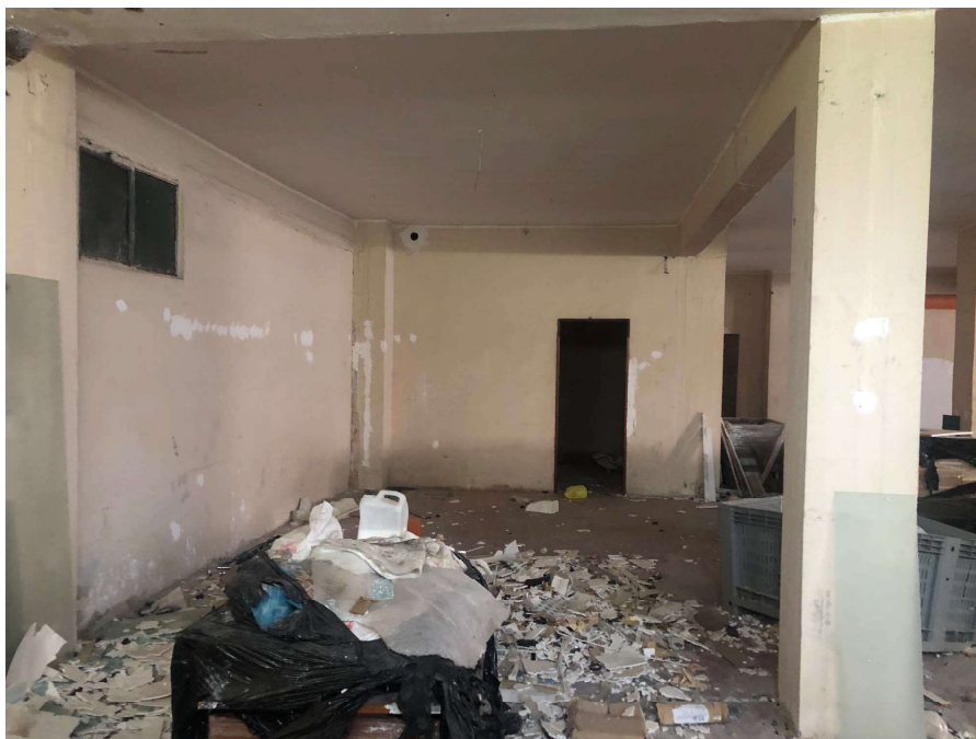
Foto n.7: vista interna magazzino
