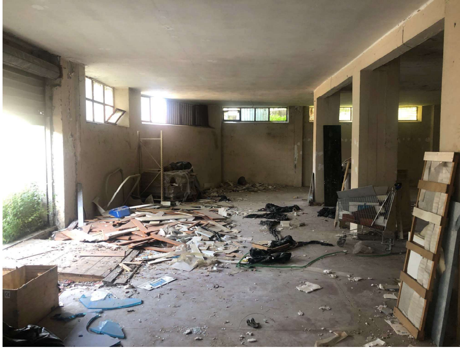
Foto n.3: vista interna magazzino
