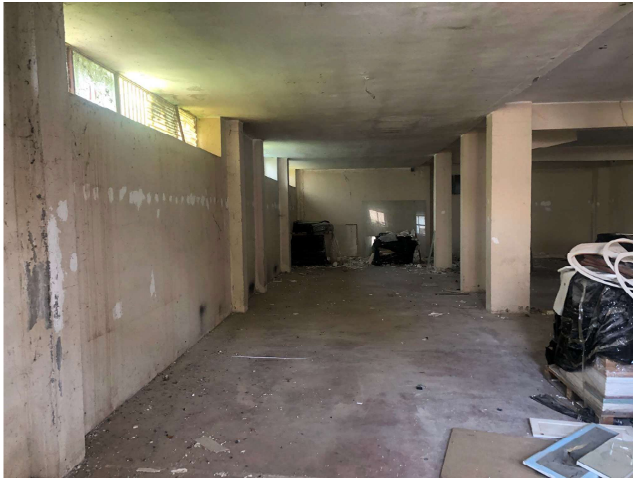
Foto n.6: vista interna magazzino
