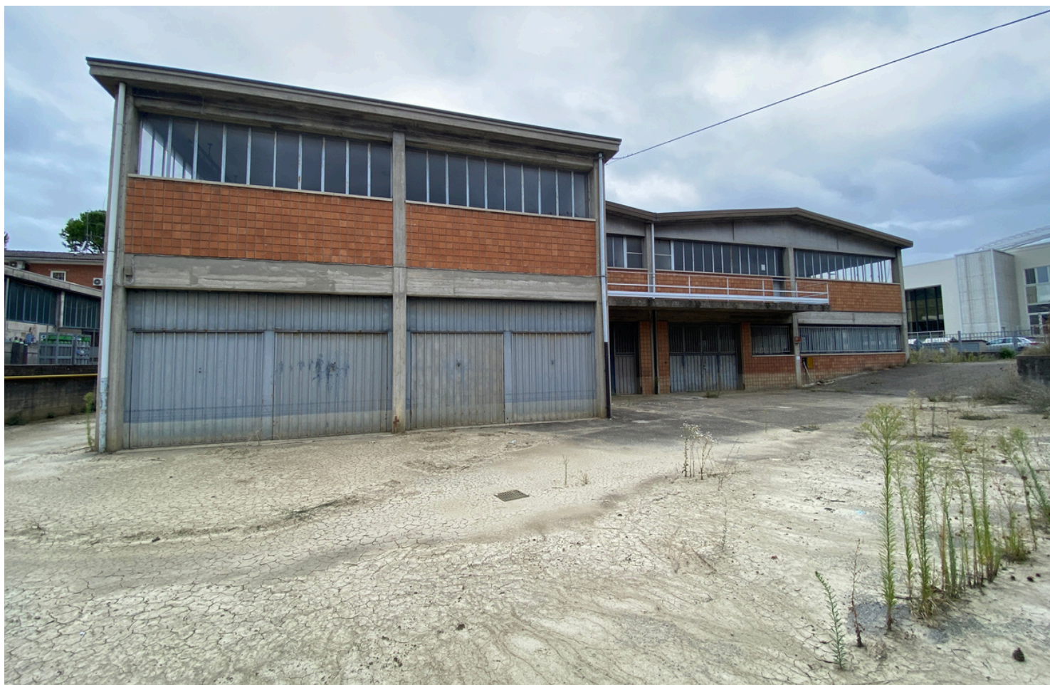
Piazzale retrostante con zona per carico scarico
