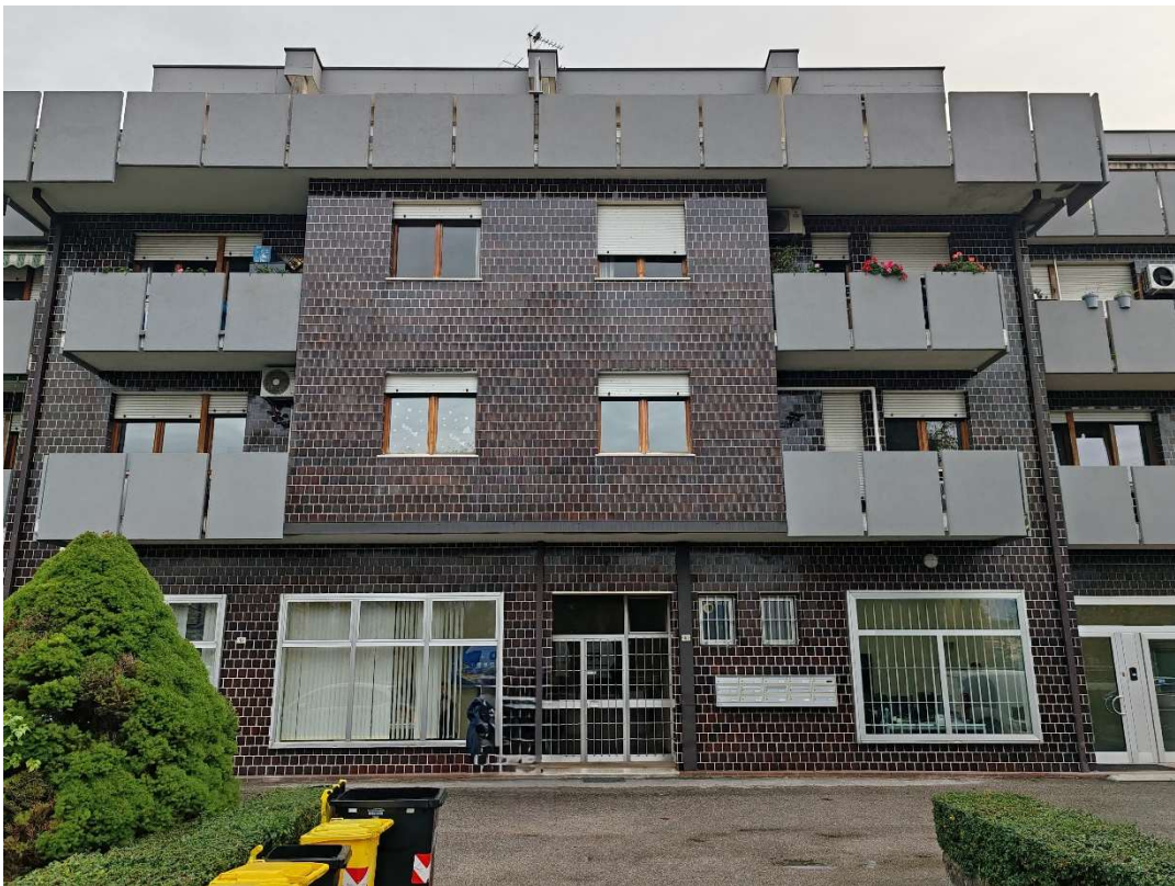
Foto 04: esterno vista da Viale Italia, ingresso condominiale
