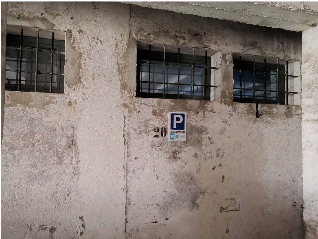
Foto 10: posto auto coperto Sub 19
