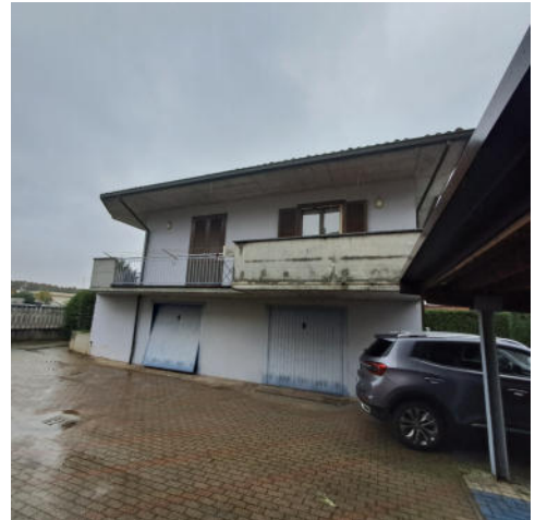
Foto 4 – Fabbricato abitativo dalla corte -Lato sud
