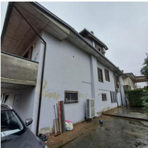
Foto 5 – Fabbricato abitativo dalla corte -Lato est
