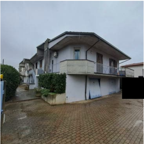
Foto 3 – Fabbricato abitativo dalla corte -Lato sud -ovest
