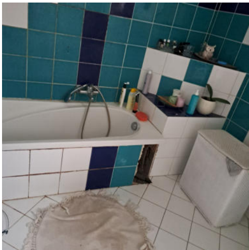
Foto 21 – Bagno al piano primo
