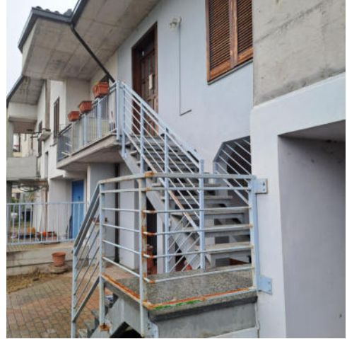
Foto 2 – Scala di accesso al piano primo – Lato ovest
