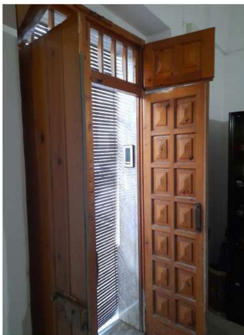
Figura 12 –Foto 6: Vano Ingresso
