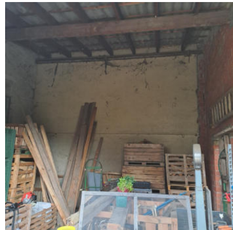
Foto 16 – Locale autorimessa (ora deposito).
