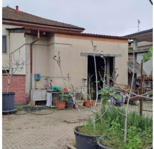
Foto 14 - Box, ripostiglio e legnaia dalla corte
