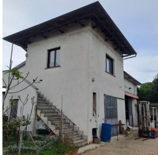
Foto 2 - Immobile dalla corte interna-Lato sud-est
