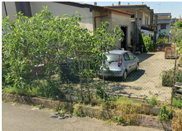
Foto 17 – Immobile dalla Via Agostino Depretis
