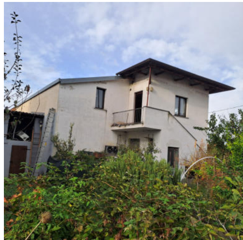
Foto 4 – Edificio dalla corte - Lato sud-ovest
