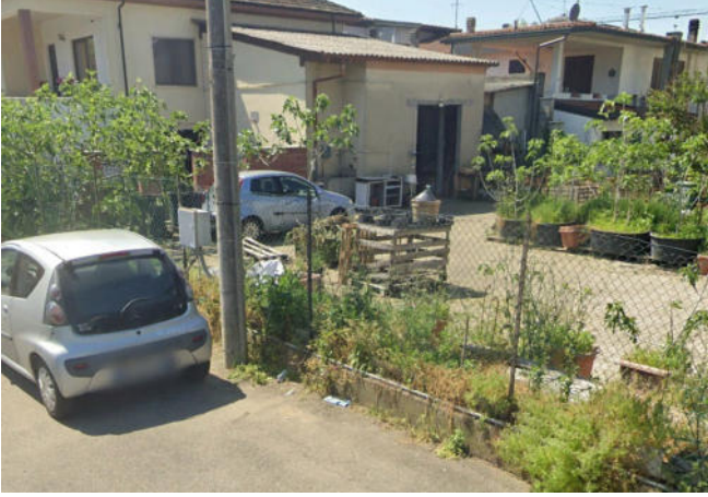
Foto 13 – Box, ripostiglio e legnaia da Via Depretis
