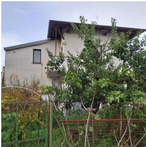
Foto 3 – Immobile dalla corte interna-Lato sud
