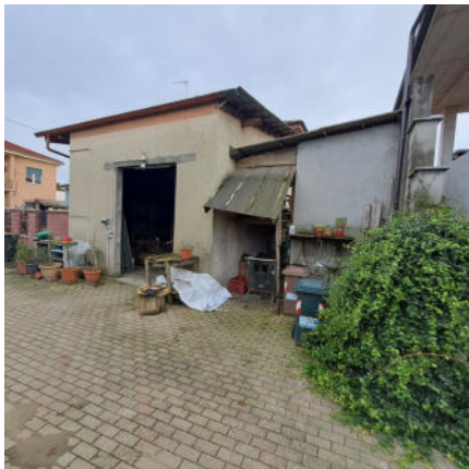
Foto 15 – Box, ripostiglio e legnaia dalla corte
