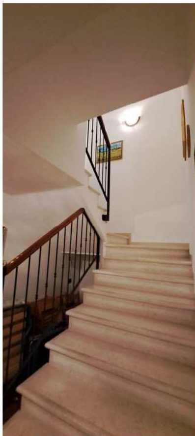
14_vano scala al piano interrato
