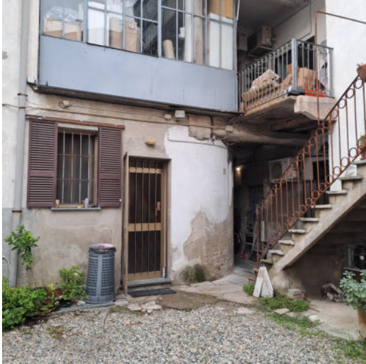
Foto 7 – Accesso al deposito dalla corte comune
