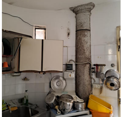
Foto 12 – Locale all'interno del deposito
