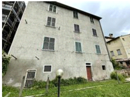
Vista retrospetto da cortile privato (non di proprietà)
